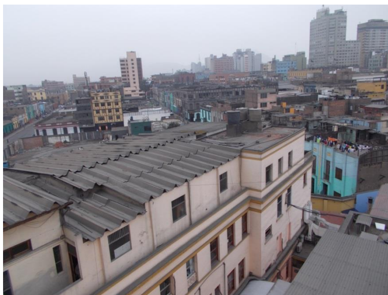
Foto 53: Solución temporal con tanques individuales de almacenamiento para sector antiguo
