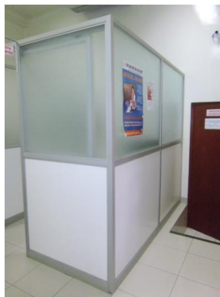
Foto 41: Tabiquería con estructura de aluminio, vidrios tipo catedral (crudos) y fijados sólo en el piso falta fijación en techo.
