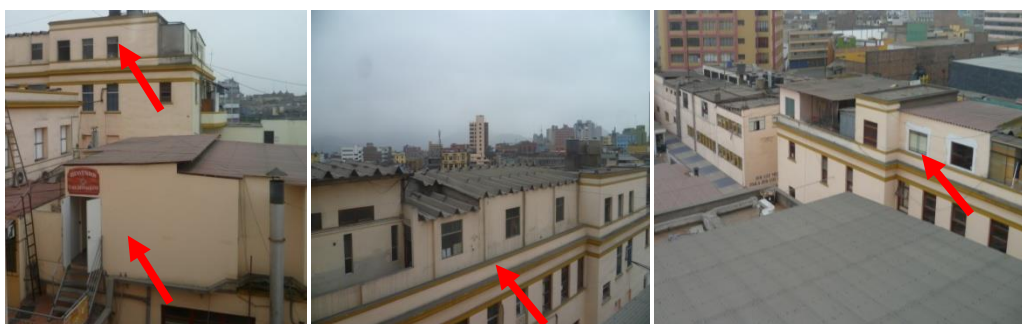
Foto 3. Vista de Bloques, se observa las adaptaciones y remodelaciones para ambientes con cobertura ligera, modificando el peso de la estructura.
