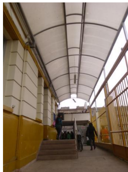
Foto 37: Las coberturas sobre las áreas de espera de Laboratorios, Banco de Sangre, e ingreso a Emergencia son de acrílico y cartón corrugado, las cuales al desprenderse no afectarían la integridad física de las personas pero si causaría alarma o pánico.
