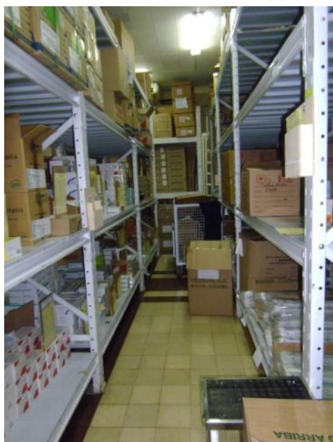
Foto 36: Faltan anclajes en las estanterías, y seguridad para los contenidos ubicados en los tableros. En general en las UPSS.
