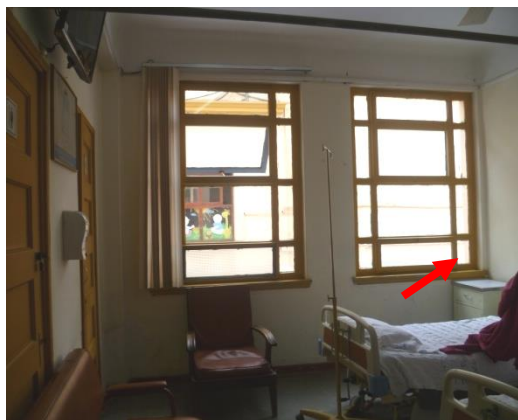
Foto 1. Se observa los vanos y mampostería adyacentes a las columnas, modificando la estructura, las cuales producirían columna corta.
