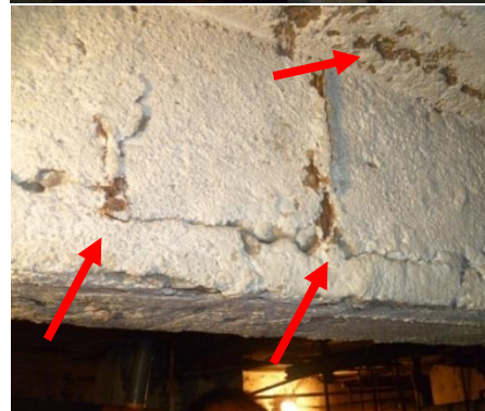
Foto 4. Vistas debajo del área de cocina (sótano), donde se observa tuberías de vapor con problemas de oxidación, muros, losas, columnas y vigas con problemas de humedad.
