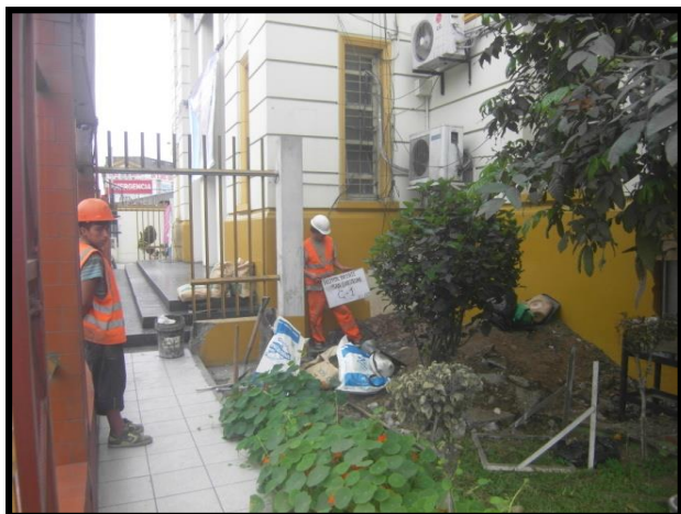
FOTO N° 1: VISTA PANORÁMICA DE LA AUSCULTACIÓN N° 1.
