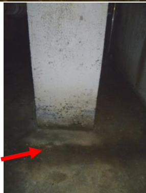
Foto 4. Vistas debajo del área de cocina (sótano), donde se observa tuberías de vapor con problemas de oxidación, muros, losas, columnas y vigas con problemas de humedad.
