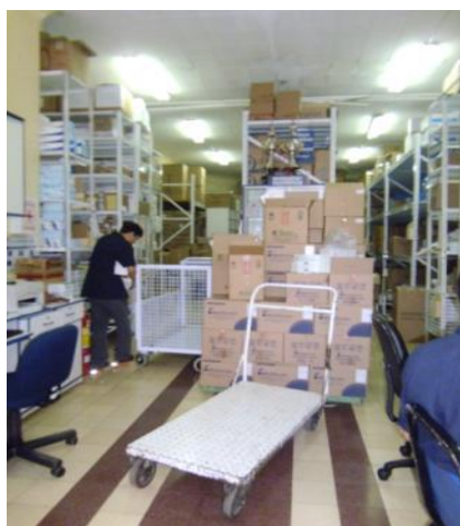
Foto 33: Almacén de Farmacia: estanterías de estructura metálica, anclados a muro, pero no arriostradas entre ellas, los tableros son planchas metálicas sin borde de protección para evitar desplazamientos de medicamentos e insumos en caso de movimiento sísmico.
