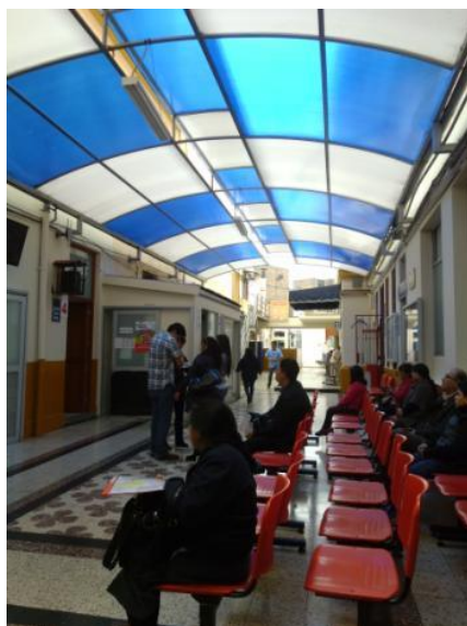
Foto 37: Las coberturas sobre las áreas de espera de Laboratorios, Banco de Sangre, e ingreso a Emergencia son de acrílico y cartón corrugado, las cuales al desprenderse no afectarían la integridad física de las personas pero si causaría alarma o pánico.
