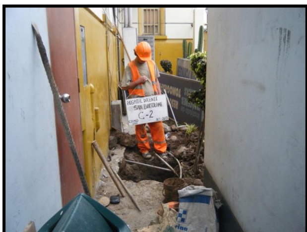
FOTO N° 3: VISTA PANORÁMICA DE LA AUSCULTACIÓN N° 2.
