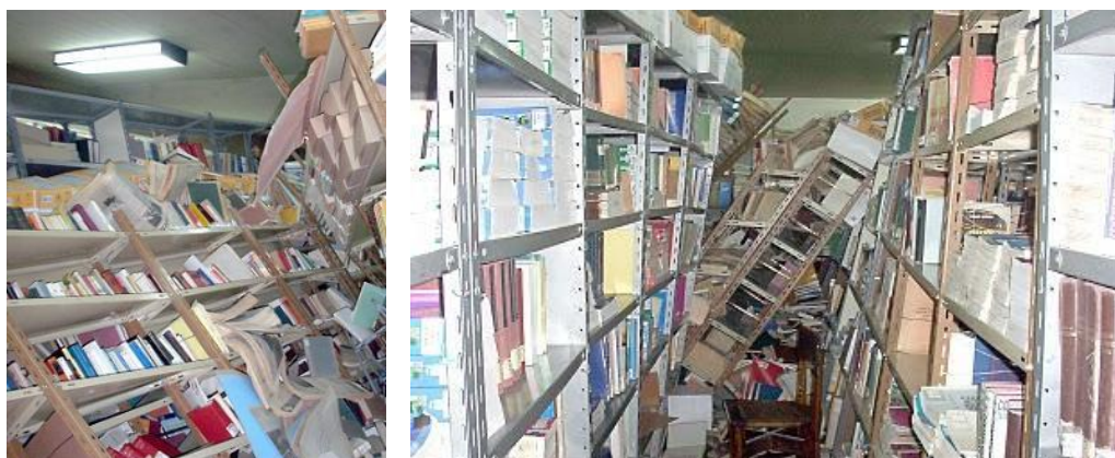
Figura 8: Caída y volcamientos de estanterías que no están adecuadamente sujetos
