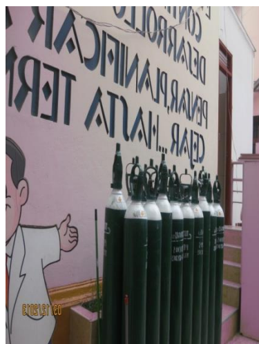
Foto 64: Balones de O2 sin bandas de sujeción, inseguros
