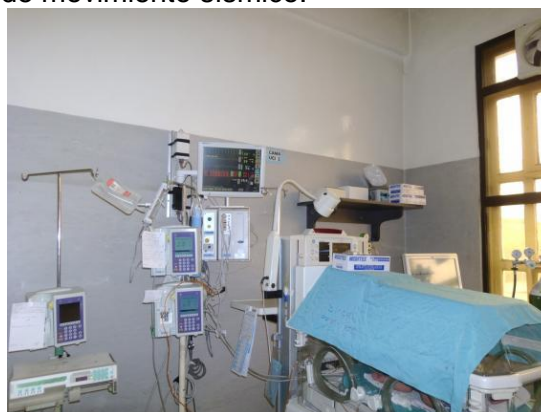
Foto 31: UCIN, equipos monitores apoyados sobre repisas sin borde de seguridad y sin anclajes sobre incubadoras.
