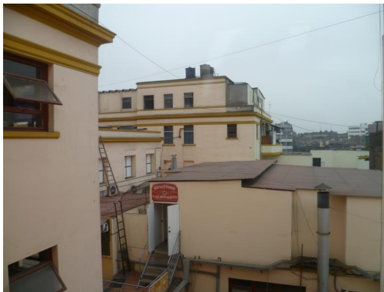
Foto 18. Vista del Bloque B
