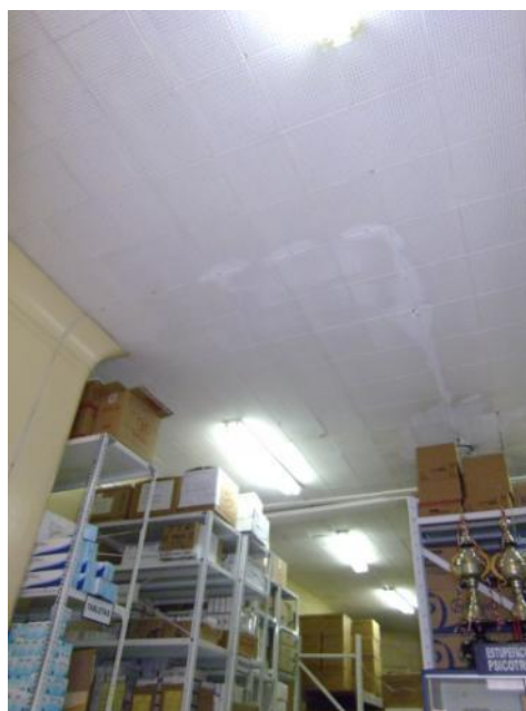
Foto 36: Faltan anclajes en las estanterías, y seguridad para los contenidos ubicados en los tableros. En general en las UPSS.
