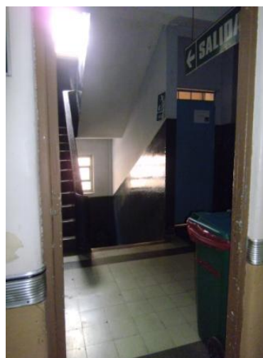
Foto 42: los carteles de señalización deben estar ubicados en los corredores que permitan identificar las salidas de evacuación, las fotos reflejan que éstas se encuentran ubicada al interior de las cajas de escaleras.
