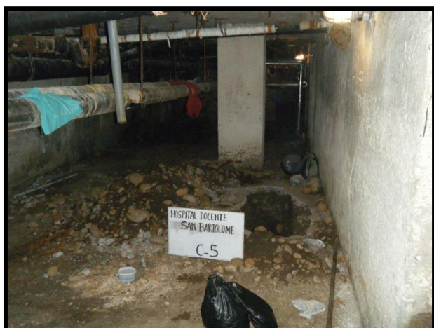
FOTO N° 9: VISTA PANORÁMICA DE LA AUSCULTACIÓN N° 5.
