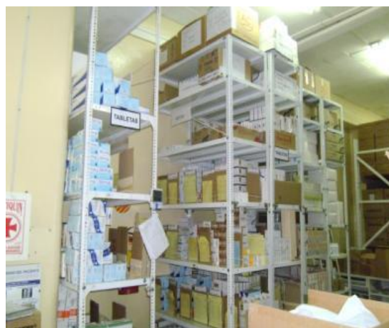
Foto 33: Almacén de Farmacia: estanterías de estructura metálica, anclados a muro, pero no arriostradas entre ellas, los tableros son planchas metálicas sin borde de protección para evitar desplazamientos de medicamentos e insumos en caso de movimiento sísmico.
