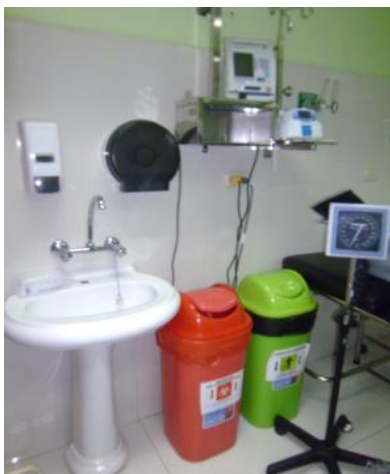
Foto 29: Equipos de Tópicos de Urgencias apoyados en repisas de madera que permiten un desplazamiento en caso de movimiento sísmico.
