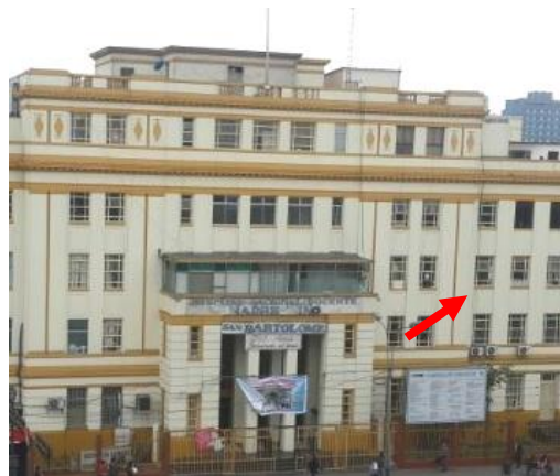
Foto 1. Se observa los vanos y mampostería adyacentes a las columnas, modificando la estructura, las cuales producirían columna corta.
