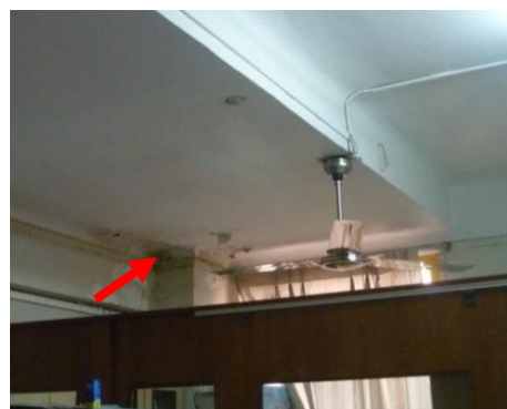
Foto 2. Se observa presencia de humedad en ambientes debilitando la estructura.
