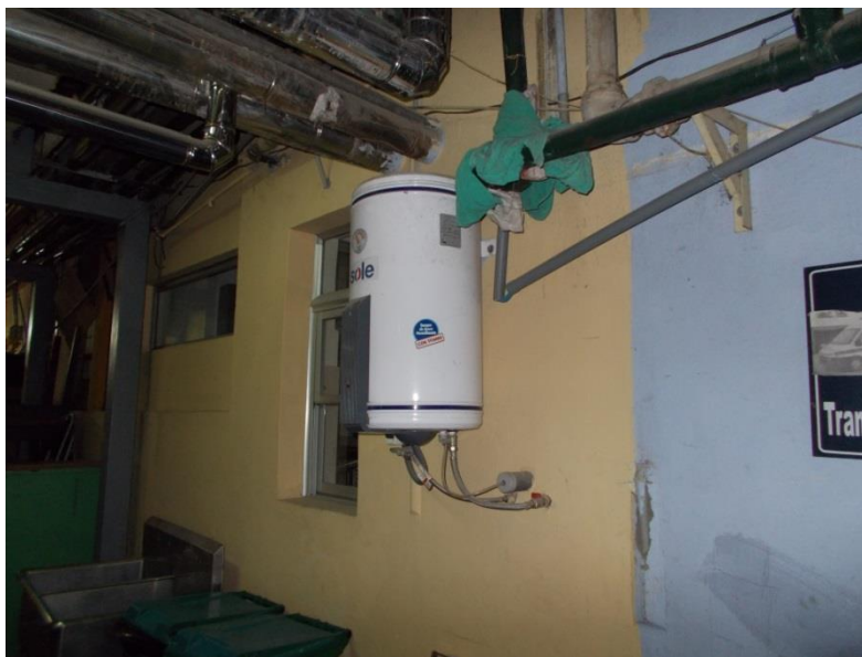
Foto 48: Conexión provisional de agua caliente.
