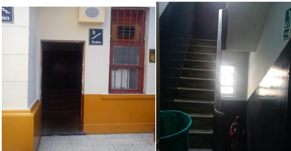
Foto 8. Escalera estrecha de evacuación del ambiente lateral, donde se ubica el Centro Quirúrgico y Unidad de Centro Obstétrico.
