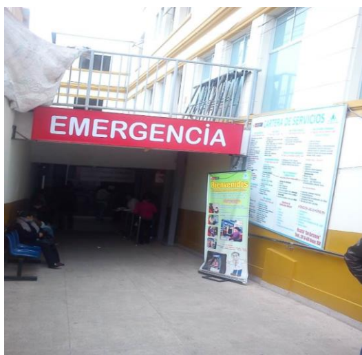
Foto 5. Ingreso del Servicio de Emergencia ubicado en el sótano del edificio principal (Bloque A).
