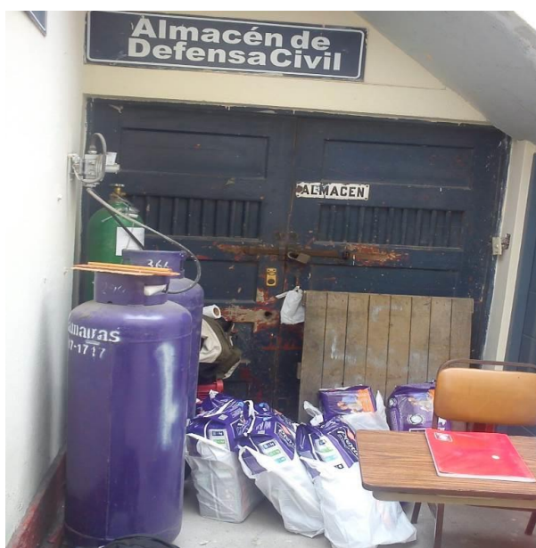
Foto 10. Almacén de insumos de Defensa Civil con balones de oxígeno y gas que además obstruyen el acceso.
