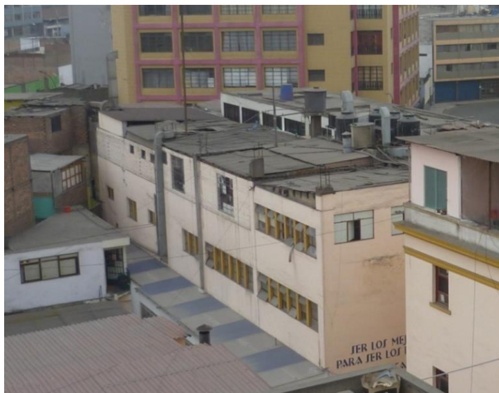
Foto 19. Vista del Bloque C
