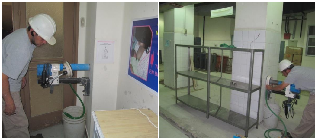
Foto 13. Extracción de núcleos de concreto.
