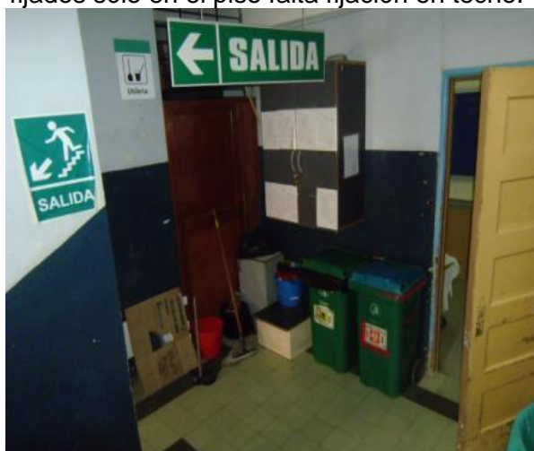
Foto 42: los carteles de señalización deben estar ubicados en los corredores que permitan identificar las salidas de evacuación, las fotos reflejan que éstas se encuentran ubicada al interior de las cajas de escaleras.
