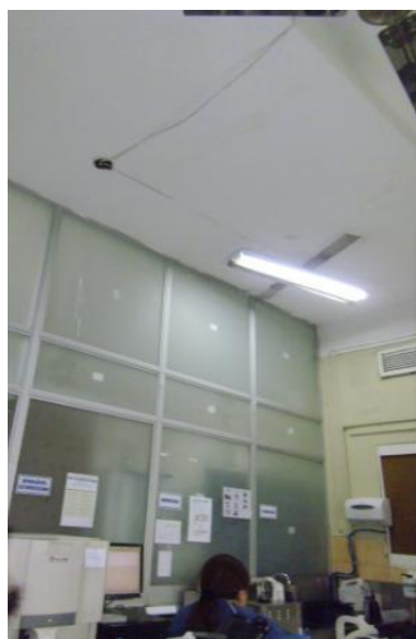
Foto 41: Tabiquería con estructura de aluminio, vidrios tipo catedral (crudos) y fijados sólo en el piso falta fijación en techo.
