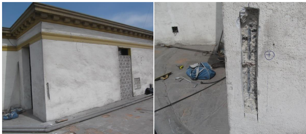
Foto 14. Puntos de extracción de muestras de acero.
