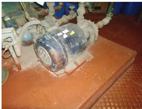
Foto 35: Casa de Fuerza: tanques apoyados sobre piso, sin cadenas de seguridad. Bombas de agua sin pernos de anclaje.
