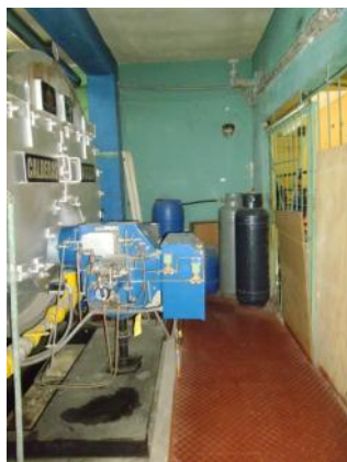
Foto 35: Casa de Fuerza: tanques apoyados sobre piso, sin cadenas de seguridad. Bombas de agua sin pernos de anclaje.
