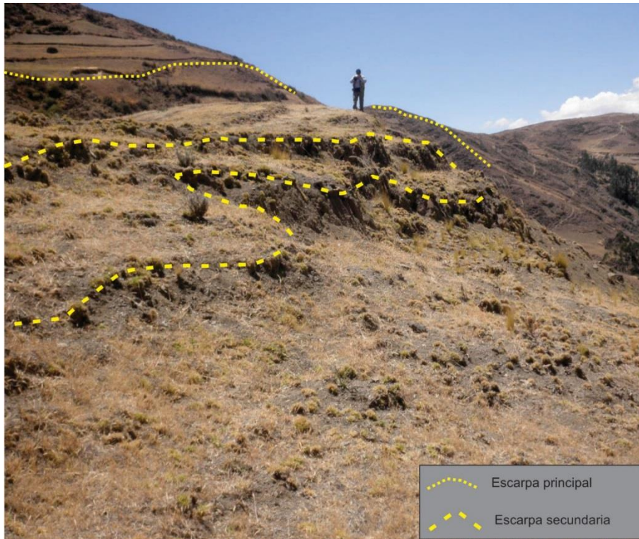
Foto 9. Escarpas desarrolladas en la cabecera del deslizamiento rotacional, parte alta del cerro Cachus.
