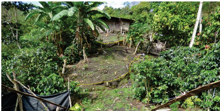
Foto 11. Agrietamientos del terreno.
