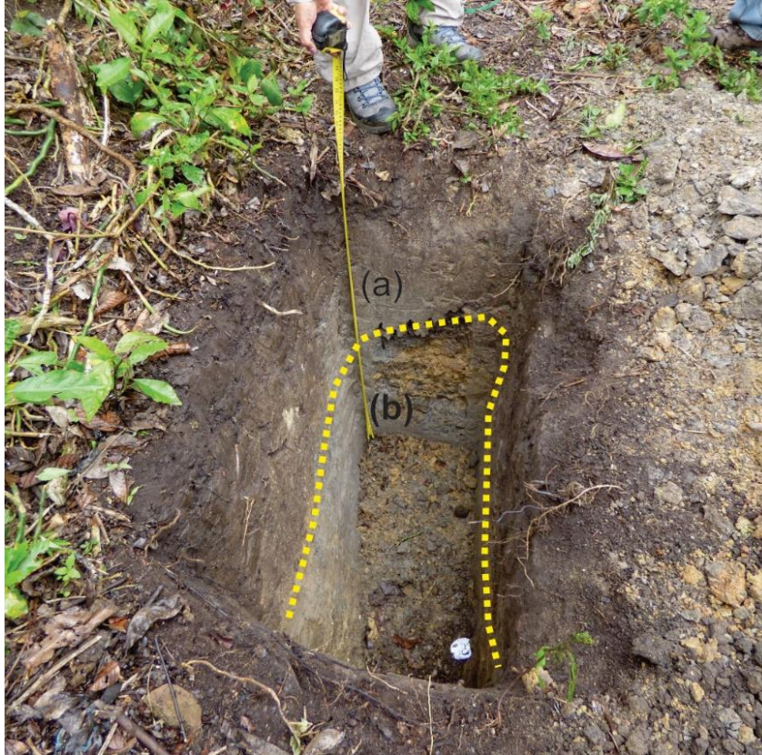
Foto 22. Calicata en el sector Garruchas (sector de reubicación), se observó suelo limoso (a) y roca altamente meteorizada (b).
