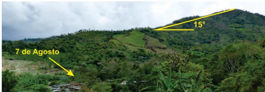
Foto 7. Ladera con pendiente, sector 7 Agosto.
