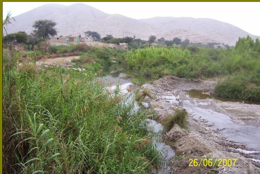
Figura N° 5.1 Foto de la Estación Puente Carretera (Casma)
