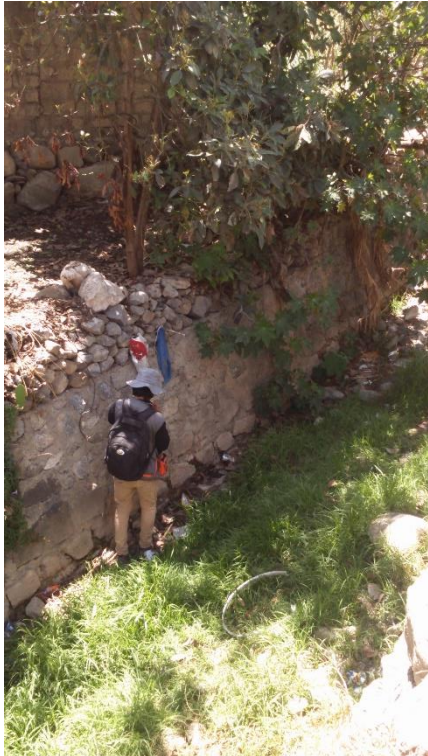
Muros de contención construidos en el cauce del río.
