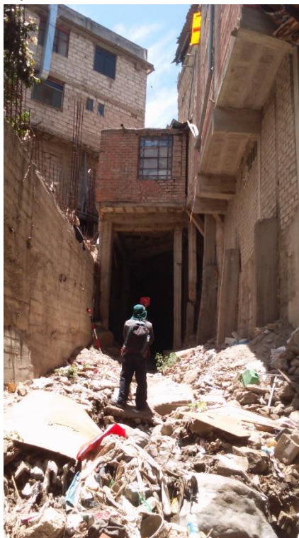
Vivienda construida sobre el cauce del río Chinchichaca.
