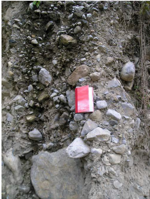
Foto N° 5: Depósito aluvial en la escarpa de talud.
