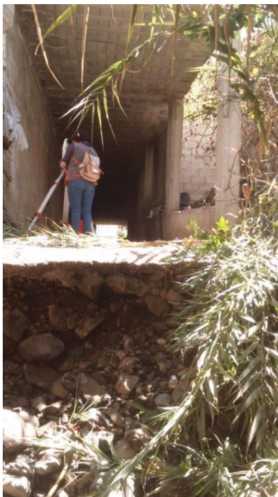
Galería comercial El Olivo construido sobre el cauce del Río de Chinchichaca.
