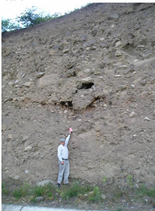
Foto N° 4: Depósito coluvial en la corte de talud de carretera.
