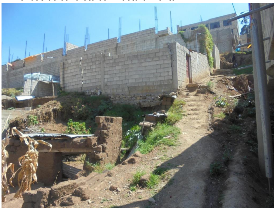
Corte de talud para la construcción de futuras viviendas.
