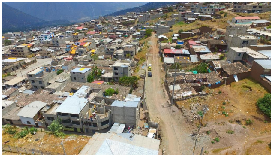
Urbanizaciones asentadas en zonas con peligro muy alto.
