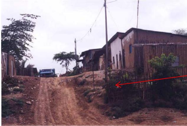
El relleno y compactación de calles erosionadas por el drenaje se efectuara adecuadamente con material de préstamo para disminuir los riesgos por acción pluvial.
