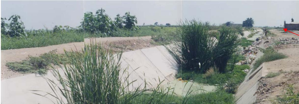
Previamente a la canalización cerrada del dren/aliviadero La Tuna Carranza se deberá evaluar el diseño del canal para avalar la capacidad del transporte y posteriormente proceder al almacenamiento y protección del canal por proximidad al casco urbano.
