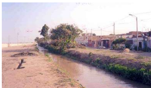
Probabilidad de inundación por desborde del Dren FAP, nótese el nivel del caudal hídrico en periodos normales
