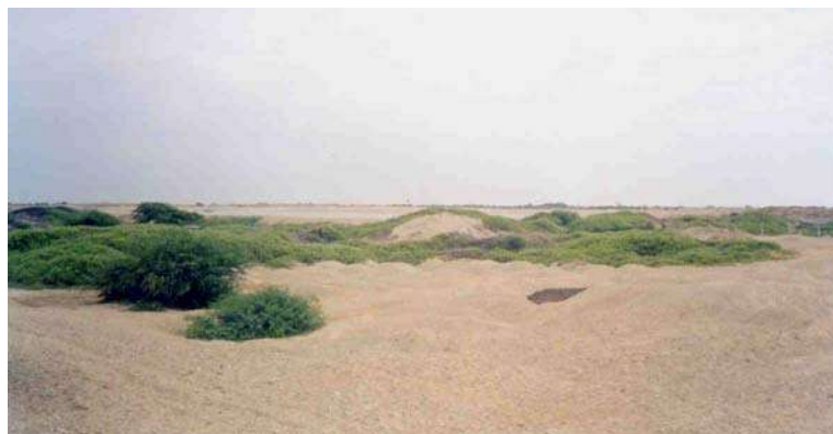
Vista de las Lagunas de Oxidación, ubicadas sobre la Carretera a San José.
