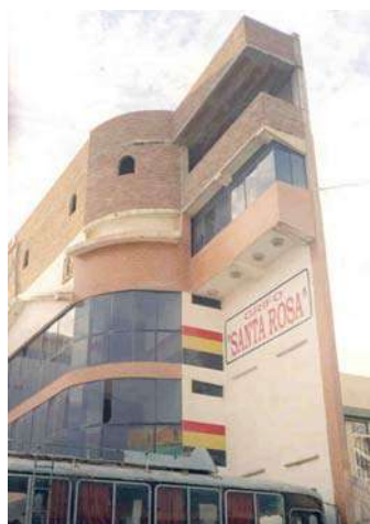
Inadecuada configuración horizontal en forma en "L" Av. Augusto B. Leguia
