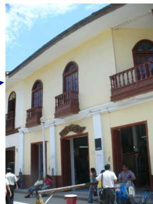
Fotografía: Abril de 2010 Casa de inicios de la República, edificada con ladrillo, adobe y quincha. El inmueble se registra exteriormente en regular estado de conservación.
