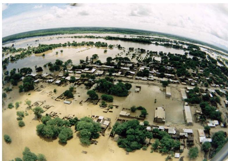
Foto: Inundación Bajo Piura 1998
