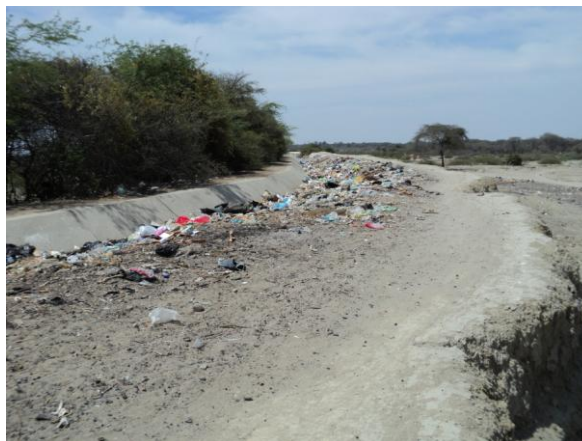
Vista del Canal de la zona La Legua, se puede apreciar la cantidad de residuos sólidos arrojados.
