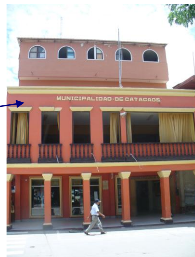
Fotografía: Abril de 2010 Municipalidad de Catacaos – Regular estado de Conservación
