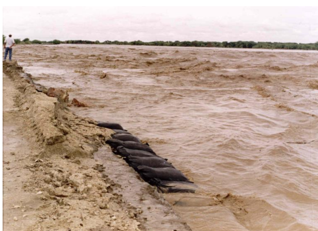
Erosión Dique Izquierdo Avenidas Río Piura 1998 Fuente: Proyecto Especial Chira Piura PECHP
