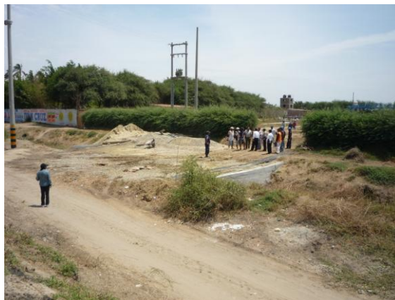
Ubicación de la Calicata 4 – 10 Altura Viduque, margen izquierda carretera Piura Sechura
