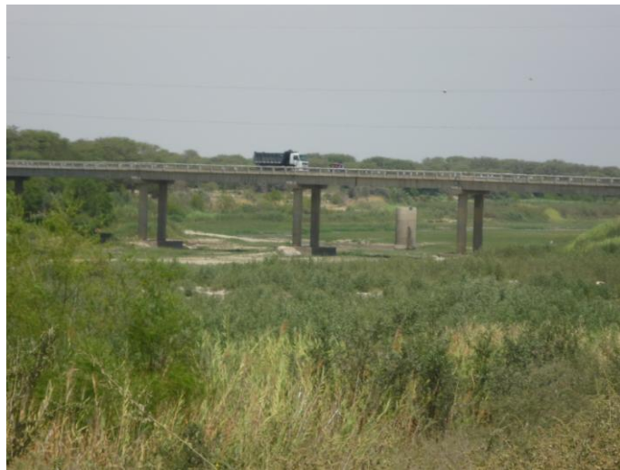
Conducto de Inspección Sifón Piura y Puente Grau
