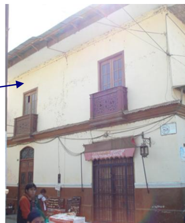
Casona Colonial ubicada en el Jr Comercio 699 – Centro Histórico de la ciudad de Catacaos Actualmente el inmueble se registra estado de Conservación Regular
