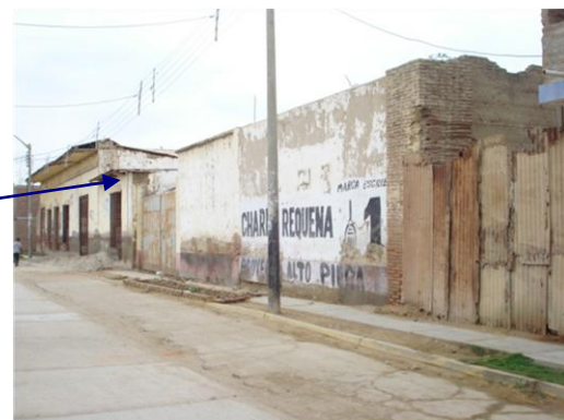
Casona Colonial ubicada en el Jr Comercio 116 120 – Centro Histórico de la ciudad de Catacaos Actualmente el inmueble se registra en mal estado de Conservación
