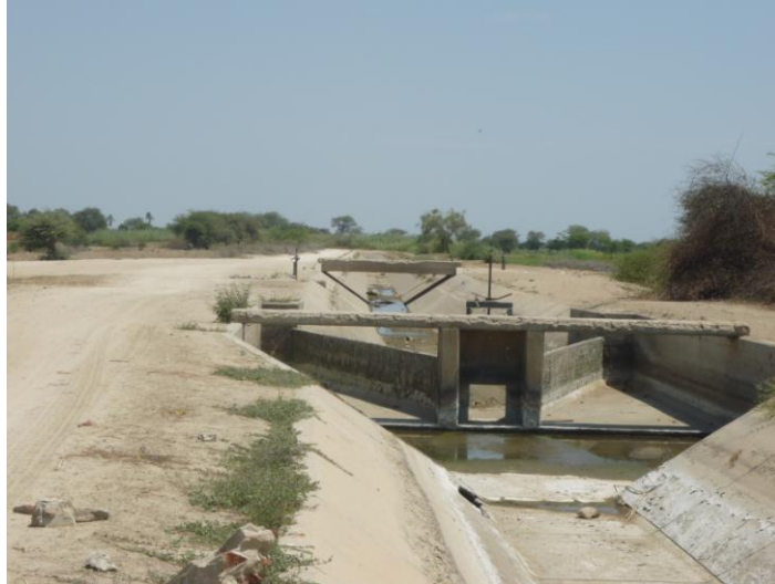
Estructura de Control, Toma y Puente Vehicular - Canal Puyuntala
