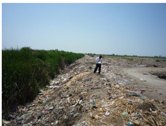
Dren Integración totalmente sucio con desmontes y basura
