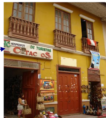
Casona Colonial ubicada en el Jr Comercio 632 -Centro Histórico de la ciudad de Catacaos Actualmente el inmueble se registra en mal estado de Conservación
