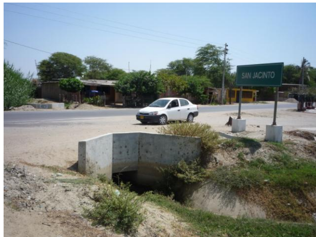
Alcantarilla canal terciario – San Jacinto
