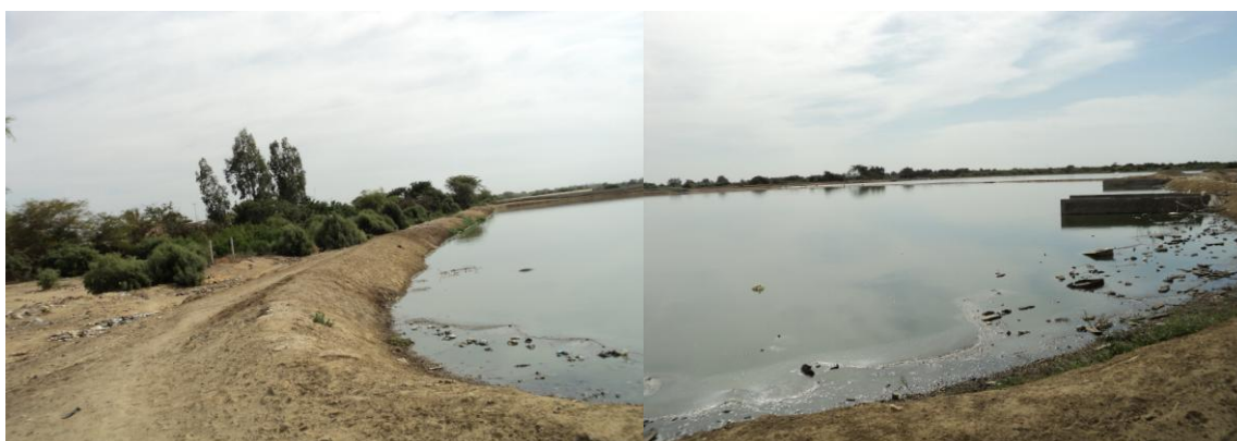
Laguna de Oxidación
