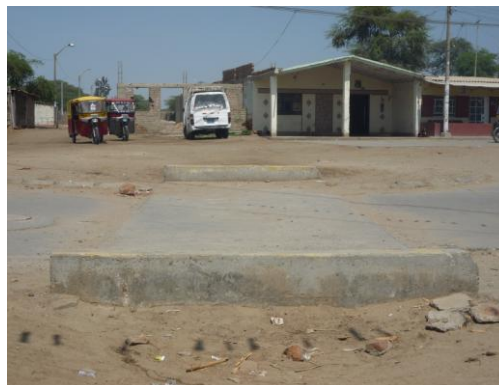
Dren Los Sechuras, alcantarillas y caja colmatados, construcciones sobre trazo del Dren
