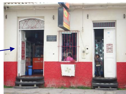
Casona Colonial ubicada en el Jr Comercio 440 – 448 – Centro Histórico de la ciudad de Catacaos Actualmente el inmueble se registra estado de Conservación Regular
