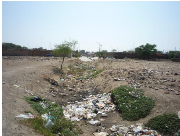
Empalme de Dren Pluvial Urbano Cayetano Heredia hacia Dren Agrícola Integración
