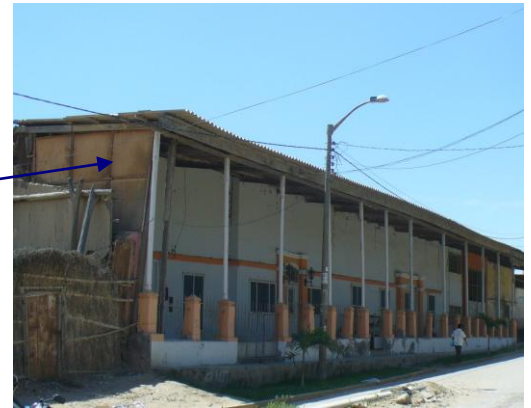
Fotografía: Abril de 2010 Casa de inicios de la República, edificada con ladrillo, adobe y quincha. El inmueble se registra exteriormente regular estado de Conservación. Fue una Desmotadora ,la "Cabredo Hermanos".
