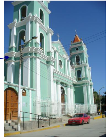
Fotografía: Abril de 2010 Iglesia San Juan Bautista de Catacaos, edificada con ladrillo, adobe y quincha. El inmueble se registra exteriormente buen estado de conservación.
