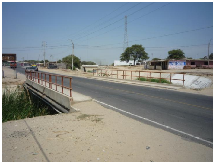
Empalme Dren DS-66.00 con Dren Sechura – La Legua
