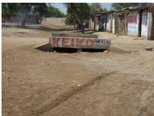
Dren Los Sechuras, alcantarillas y caja colmatados, construcciones sobre trazo del Dren
