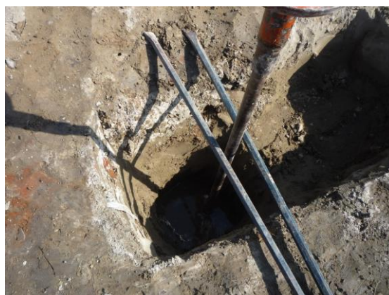
Calicata 5 – 10, se observa Nivel Freático y salinización de suelo Ubicado parte posterior de Centro Poblado Simbilá
