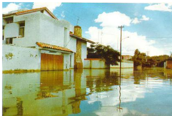
Viviendas afectadas por el fenómeno " El Niño" en la Urbanización «El Chilcal» de Piura.
