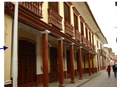
Casona Colonial ubicada en el Jr Comercio 669 – 684- 688 - 694 Centro Histórico de la ciudad de Catacaos Actualmente el inmueble se registra regular estado de Conservación
