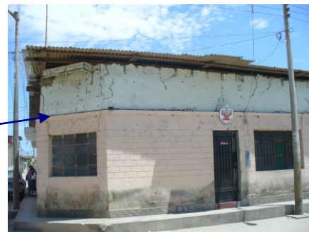
Fotografía: Abril de 2010 Casa de inicios de la República, edificada con ladrillo, adobe y quincha. El inmueble se registra exteriormente mal estado de Conservación, por las múltiples intervenciones.
