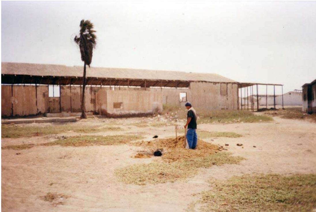
Foto Nro .3. Excavación de Calicata en Ciudad Eten
