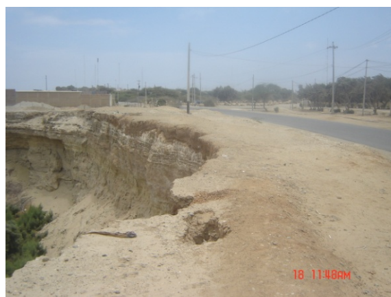
Foto, el proceso de movimiento de masa de rocas y suelo ha sido generado por los suelos colapsables en el sector urbano Industrial
