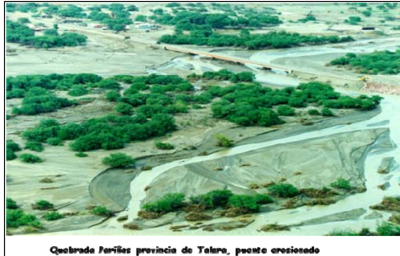
Imagen N° 7: Quebrada Pariñas (Puente Pariñas)
