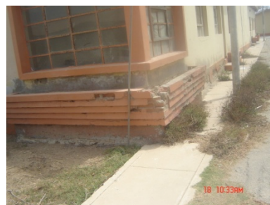
Foto, La agresividad del suelo por contenido de sales solubles y sulfatos que deterioran la cimentación de la vivienda, en la Villa FAP
