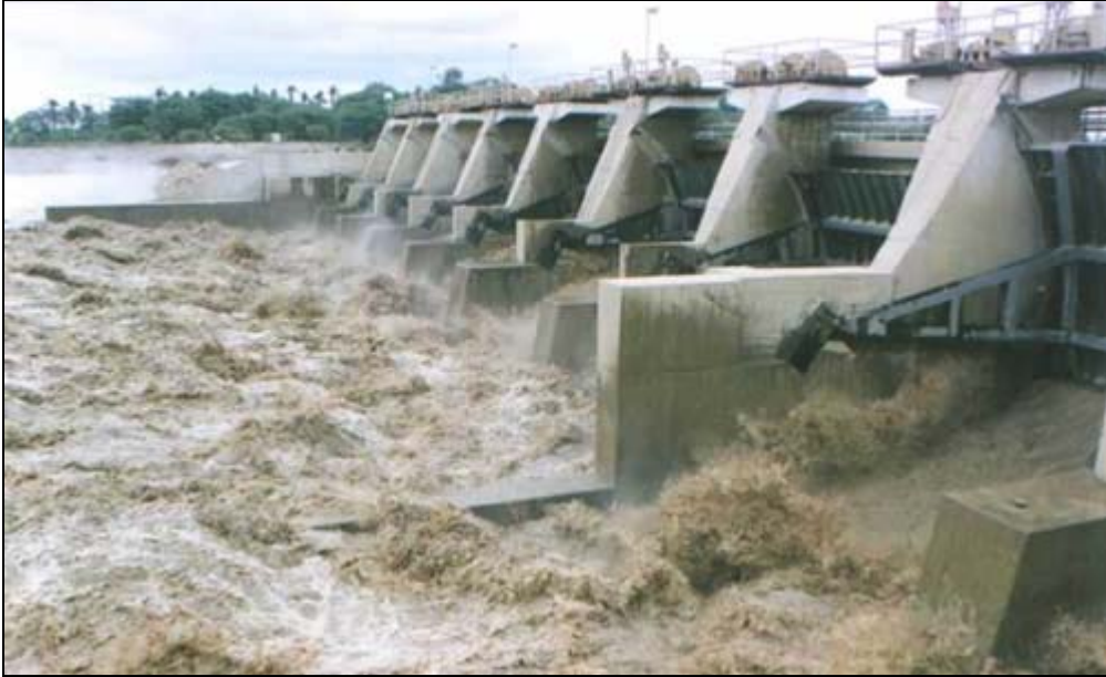
Fotografía Nº 6. Operación de las compuertas del Barraje Móvil de la Presa Derivadora Sullana, en épocas de avenida.
