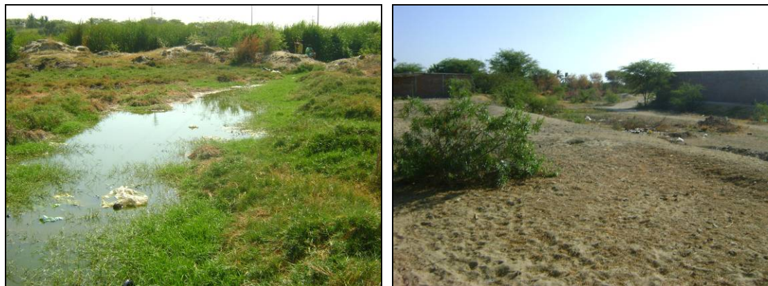
Fotografía N° 9 y N° 10. Izq. Cauce de la Quebrada Cieneguillo, aguas arriba de la carretera a Tambogrande. Se observa acumulación de desmonte y vegetación, además un cauce no definido. Der. Quebrada Cola del Alacrán, se observa crecimiento de arbusto en su cauce.
