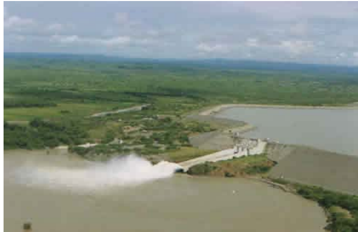
Fotografía Nº 5. Aliviadero y Poza amortiguadora de la Presa Poechos.
