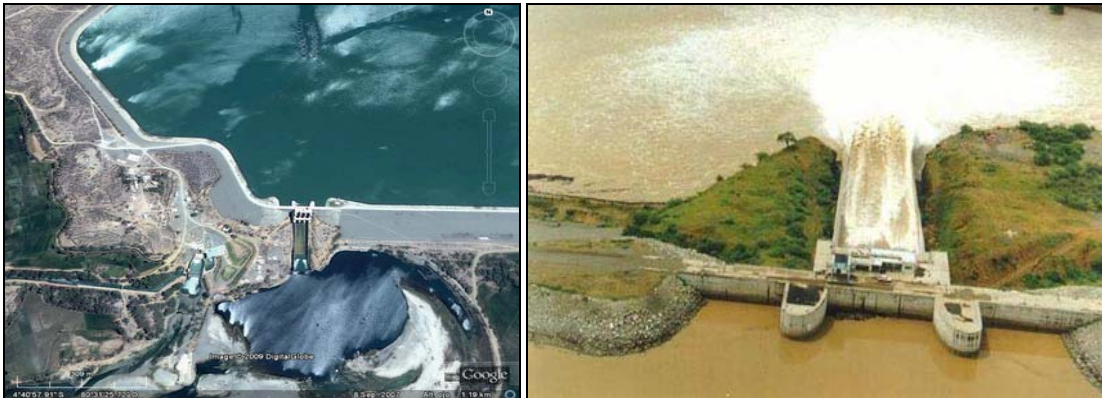
Fotografía N° 1 y N° 2. Aliviadero y Poza Amortiguadora de la Presa Poechos.
