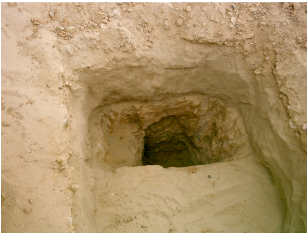
Fotografía N° 52. Calicata C-14 excavada en el Campo Ferial Los Reyes y que muestra un suelo areno arcilloso con gravas en estado de compacidad Medio a Denso.
