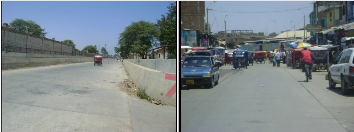
Fotografía N° 34 y 35. Dren Canchaque vista hacia aguas abajo. Sector donde el dren Canchaque desemboca en el Canal Vía (sector Mercadillo).
