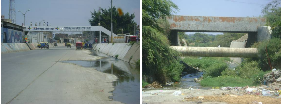
Fotografía Nº 26 y 27. Canal Vía Construido después del Fenómeno El Niño de 1983. Sirve de vía para el tránsito vehicular durante períodos secos. A la derecha se muestra el final del Canal Vía (desembocadura en el río Chira).
