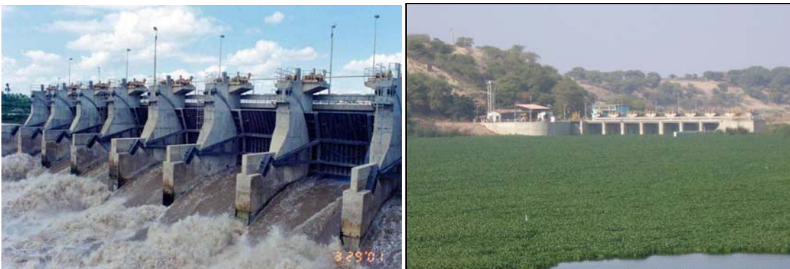
Fotografía N° 3 y N° 4. Izq. Operación de los Barrajes Móviles de la Presa Derivadora Sullana, en épocas de avenidas. Der. Vista desde aguas arriba de la Presa Derivadora Sullana.
