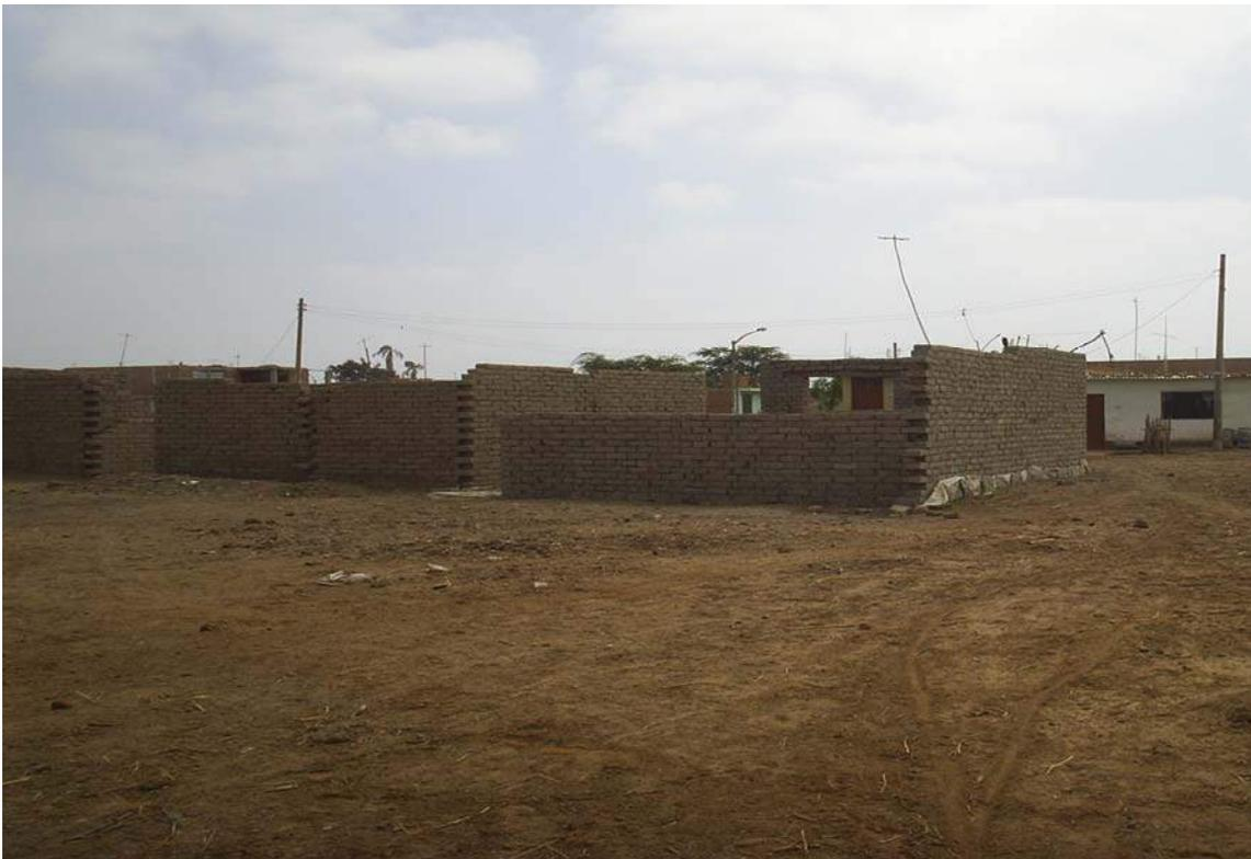
**F-14** Prolongación de la calle Chiclayo. Construcción de viviendas de adobe en zona de Inundación Crítica y con presencia de suelos expansivos.
