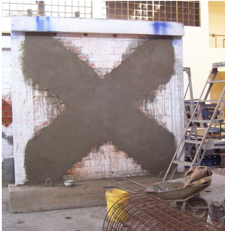
Figura 107: Reforzamiento con bandas de refuerzo.
