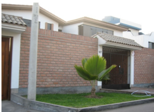
Figura 30. Vivienda multifamiliar albañilería confinada.
