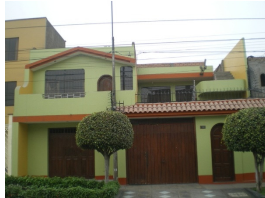
Figura 17. Vivienda de albañilería confinada.
