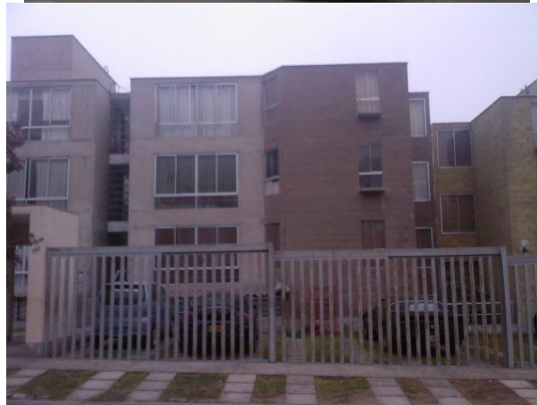
Figura 42: Edificaciones típicas del Sector 17. Vivienda multifamiliar y conjunto residencial.
