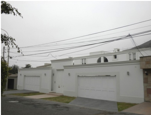
Figura 31. Vivienda de mampostería confinada de 2 pisos
