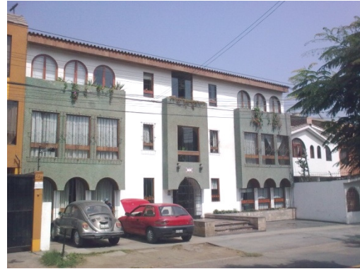
Figura 28. Vivienda multifamiliar de mampostería confinada de 3 pisos
