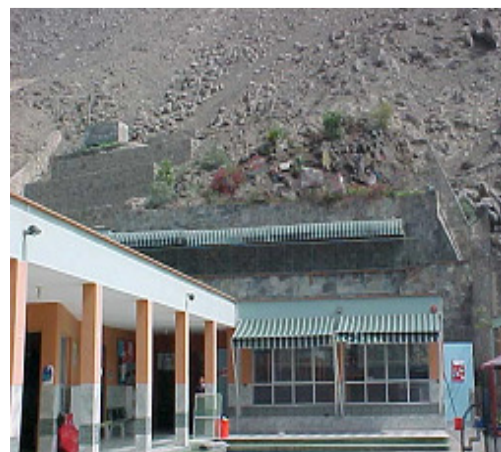
Figura 87. Visita del interior del Colegio. (Archivo CISMID, 2002)
