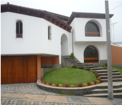
Figura 65. Vivienda típica de la urbanización, construida con mampostería confinada por elementos de concreto armado, en muy buen estado de conservación, y con una antigüedad entre 10 y 30 años.
