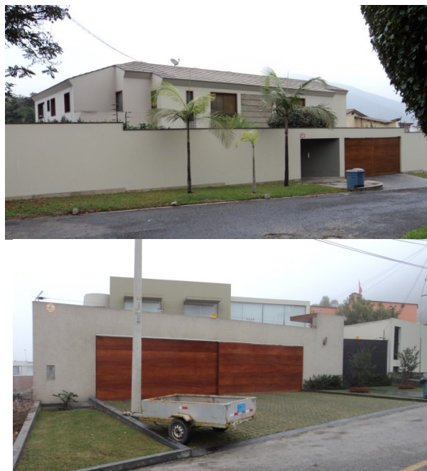
Figura 29. Viviendas de mampostería confinada de 2 pisos en muy buen estado.
