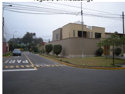
Figura 12. Vivienda en zona residencial y reja de seguridad abierta
