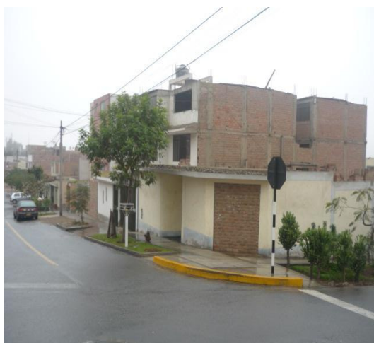
Figura 52. Predominio de mampostería confinada por elementos de concreto armado.
