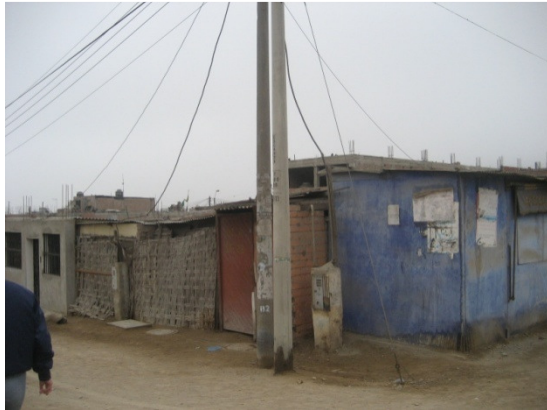
Figura 69. Vivienda informal de madera y esteras.
