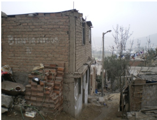
Figura 34. Vivienda de albañilería informal.
