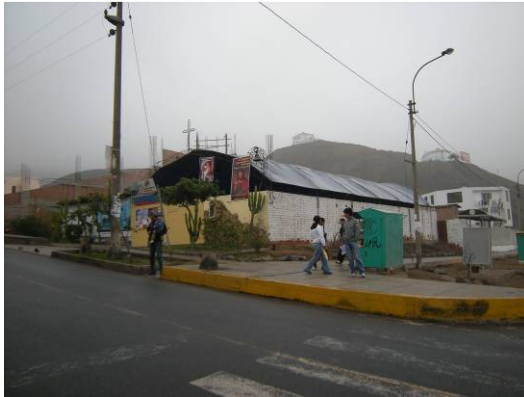
Figura 46. Capilla Santa Maria (estructura provisional)
