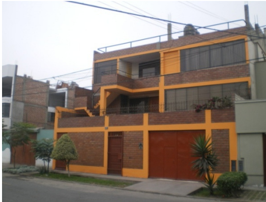
Figura 16. Vivienda multifamiliar albañilería confinada.
