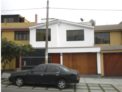
Figura 40. Vivienda de mampostería confinada de 2 pisos
