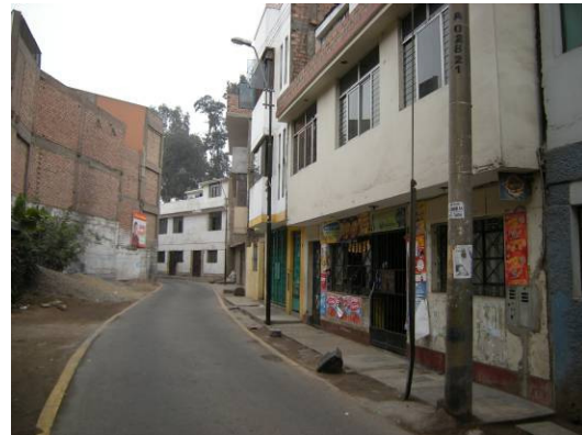
Figura 8. Uso indiscriminado de ladrillo pandereta como portante
