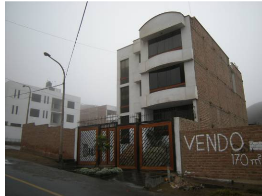
Figura 49. Desnivel, terrenos baldíos y multifamiliar de construcción reciente
