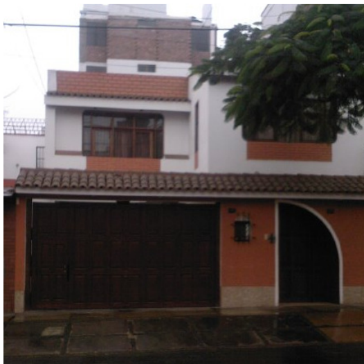
Figura 18. Vivienda típica en el Sector 5.
