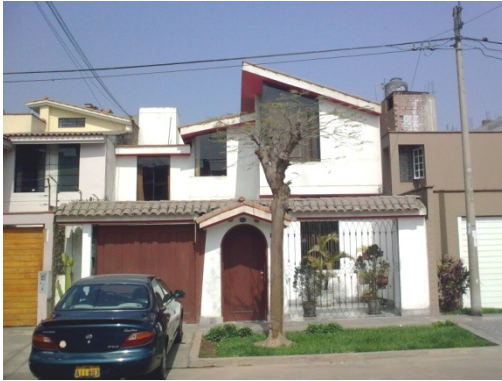
Figura 27. Vivienda de mampostería confinada de 2 pisos
