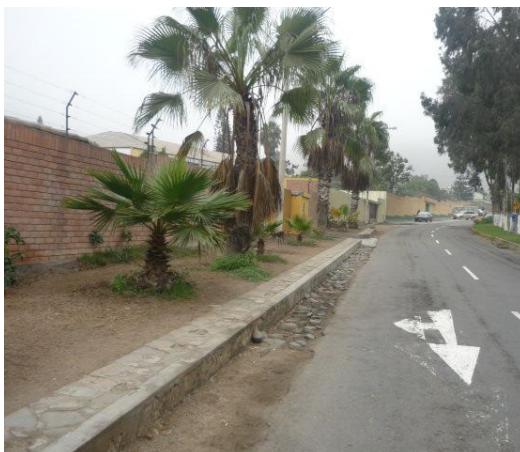
Figura 86. Vista fotográfica del cerco perimetral de este centro educativo (no hubieron facilidades para ingresar, junio 2010).
