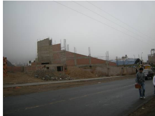
Figura 47. Capilla en construcción
