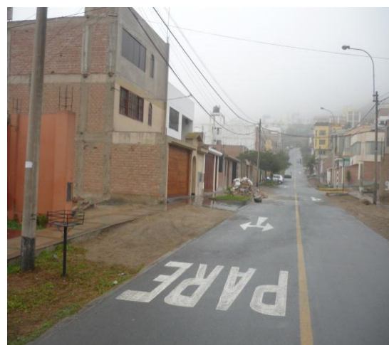
Figura 53. Existencia de lotes baldíos o con construcciones precarias
