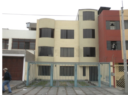
Figura 41. Vivienda multifamiliar de mampostería confinada de 3 pisos
