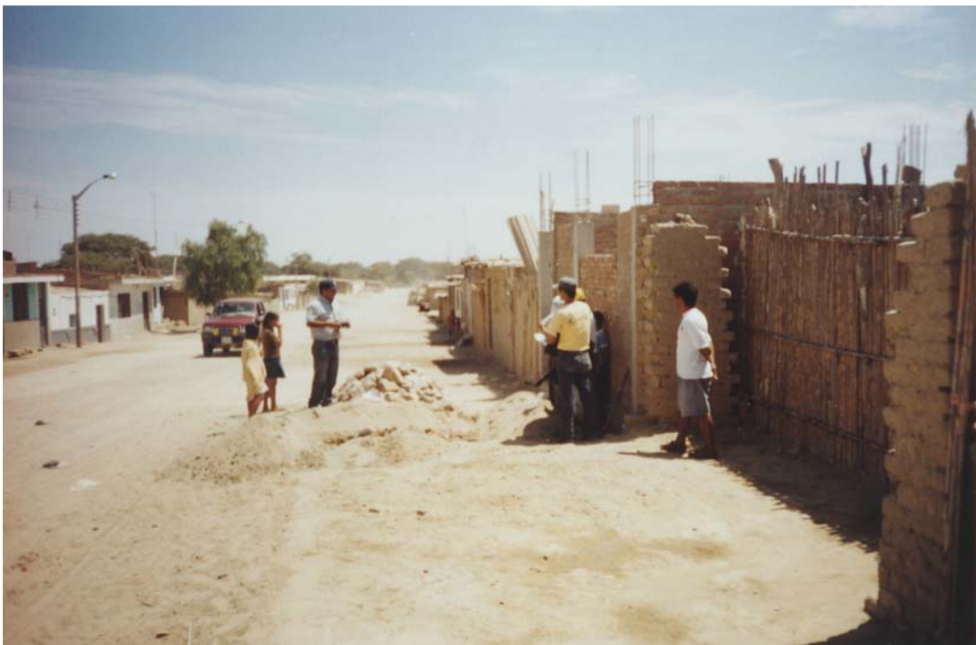
Foto Nro. 10. Calicata C-15 ubicada en Av. México.
