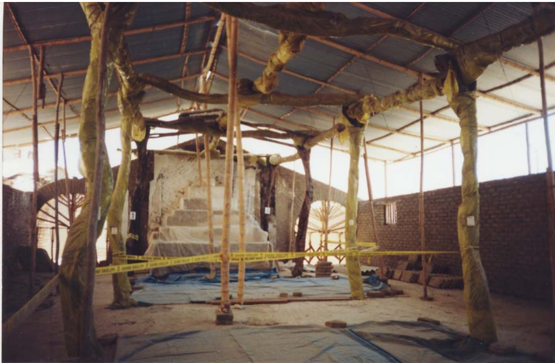
Foto Nro. 20. Restauración de la Capilla Doctrinal San Pedro – Mórrope.
