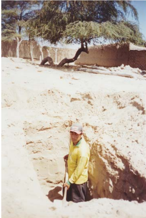
Foto Nro. 5. Ejecución de calicata C-6 ubicada en Jr. Sola.
