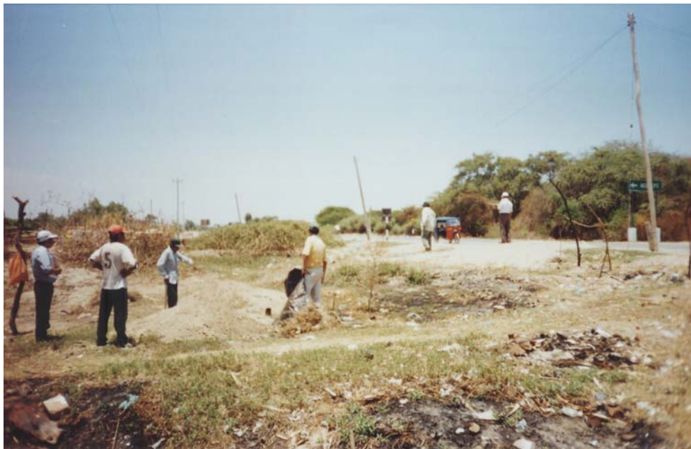
Foto Nro. 6. Ejecución de calicata C-7 ubicada en el lado derecho de la carretera Panamericana en la dirección Sur-Norte.
