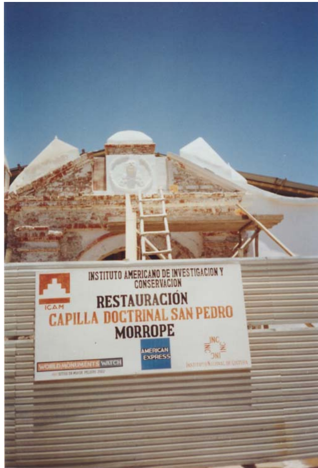
Foto Nro. 19. Restauración de la Capilla Doctrinal San Pedro – Mórrope.
