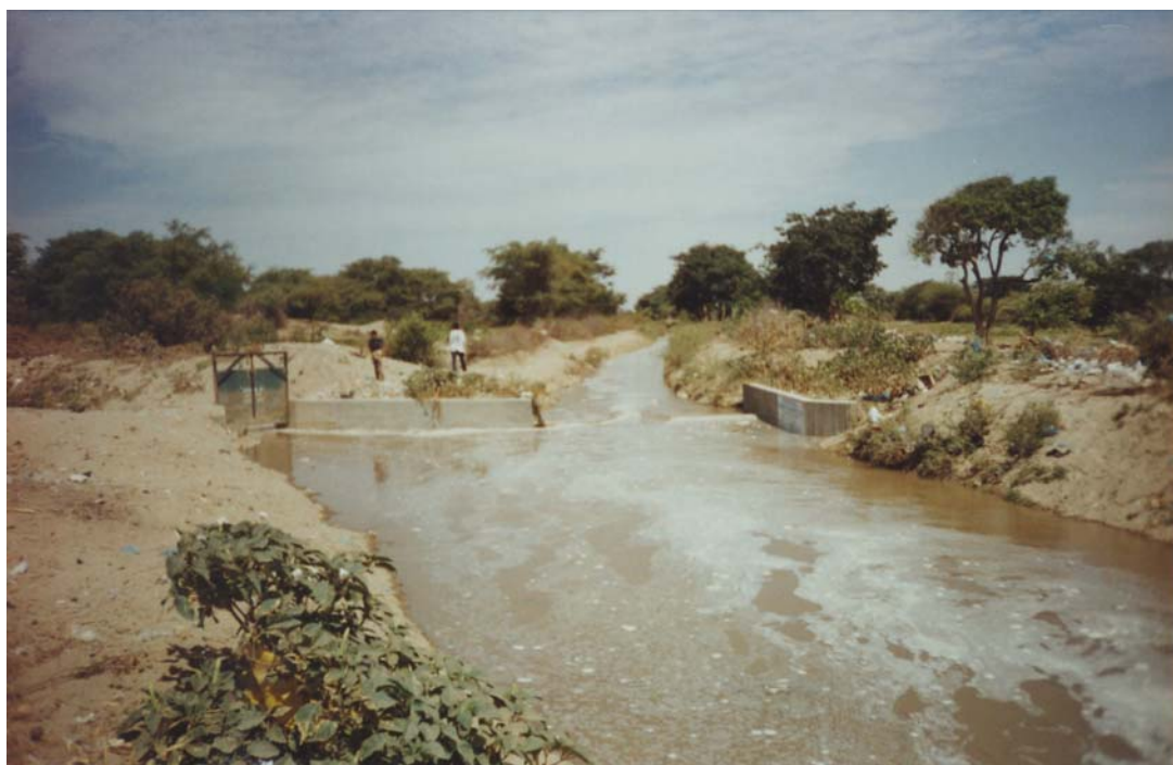
Foto Nro. 16. Vista de Toma Cornelio desde aguas arriba.
