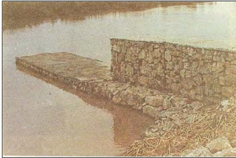
Fig. 10: Espigón típico de río que sirve como disipador de energía en crecida de ríos. (Tomado de PROLANSA).
