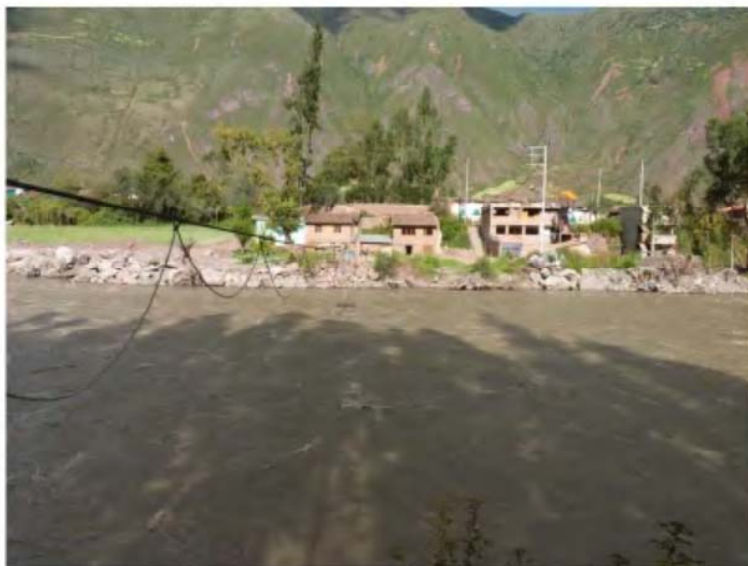
Foto 09: Donde actualmente se ubica una oroya artesanal se encontraba el Puente Huycho el cual fue destruido por la crecida del río Vilcanota.
