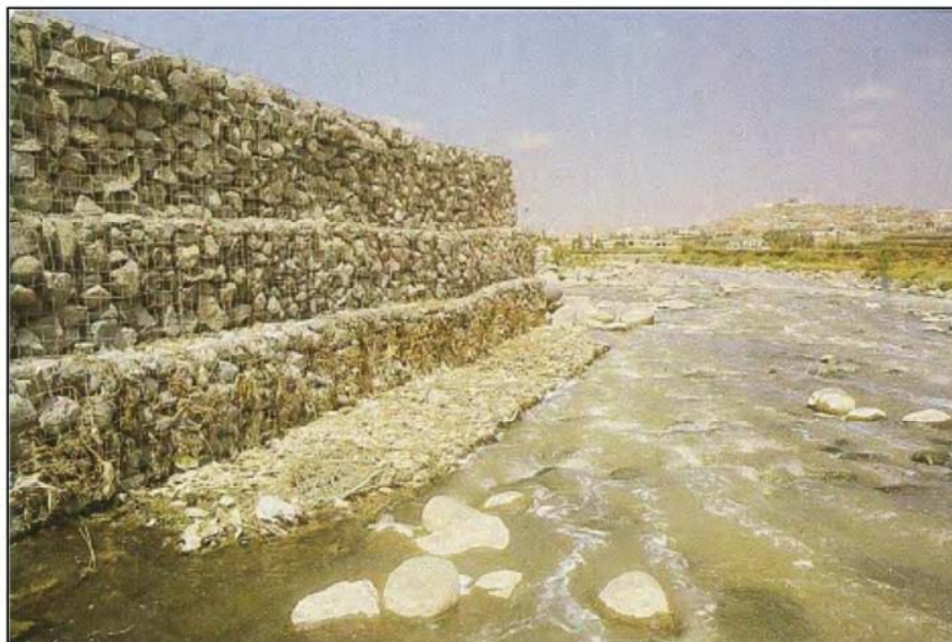
Fig. 08: Gaviones en forma de terrazas.
