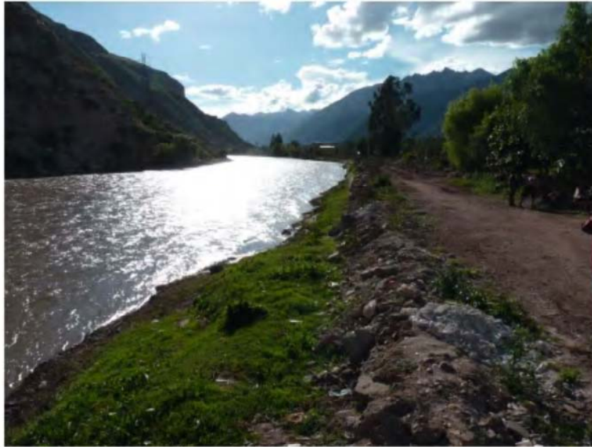
Foto 13: Vista de la carretera ya reconstruida que fue erosionada por la crecida del río Vilcanota.
