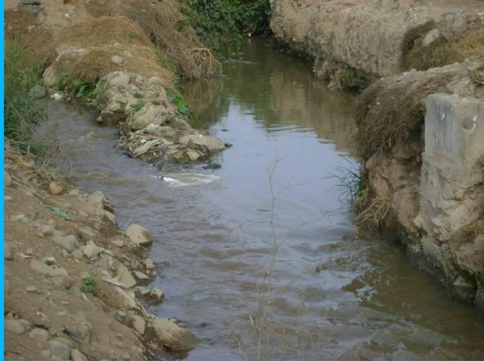
Canal Cañón 1 en el sector El Milagro, se observa la unión del canal de riego con un emisor de aguas servidas, la unión del flujo se reusa para riego constituyendo un peligro.
