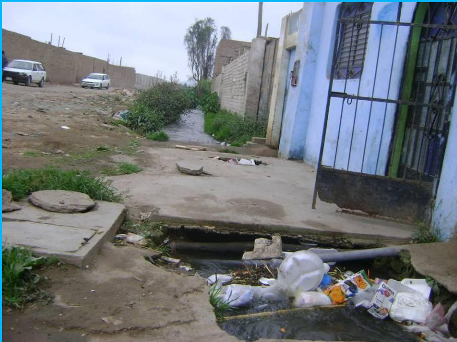
Zona de inundación. El canal Cañón 2 pasa por delante de viviendas. Se muestra acumulación de material flotante (basura), retenido en las veredas y alcantarillas de las viviendas.
