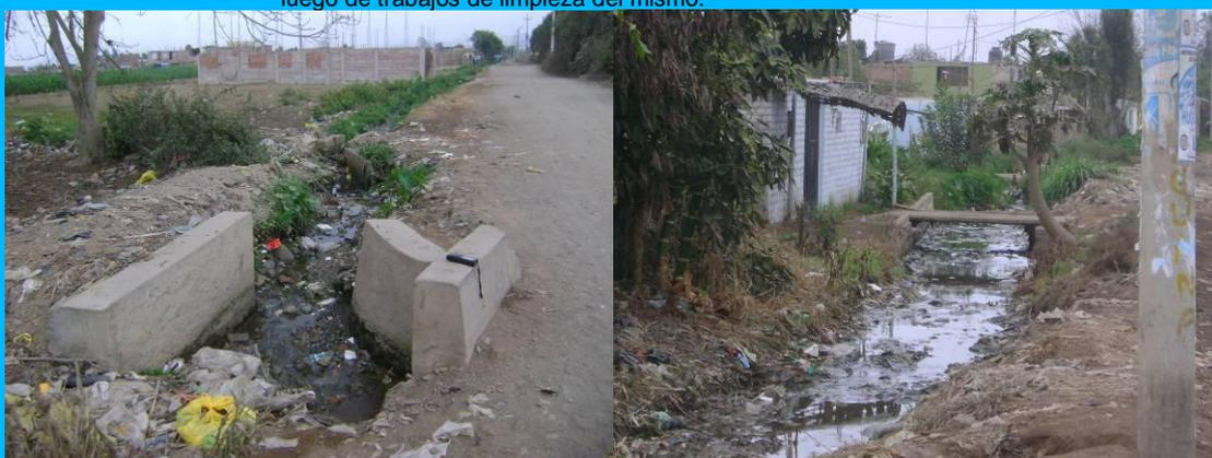
Canal Caporala 1, se observa canal colmatado con material de arrastre y basura.
