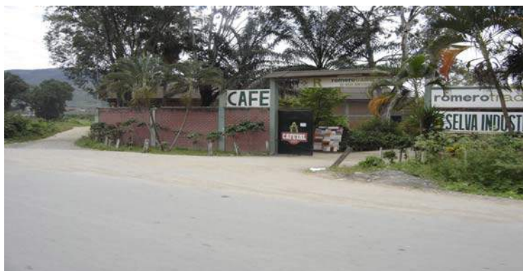
Planta Procesadora de Café Selva Industrial ubicada sobre la Av. Pakamuros.
