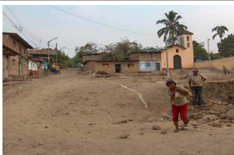
Vista de la construcción del baraque en Montegrande.
