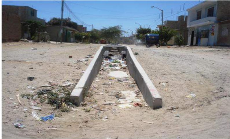
Estructura de transvase de cuenca ciega en la parte alta, sin mantenimiento y con rasantes inadecuadas.
