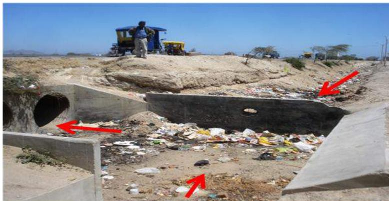
Alcantarillas del dren Circunvalación en la parte alta, que recoge el drenaje pluvial de la parte alta, pero que es ineficiente, por incompatibilidad de rasantes.
