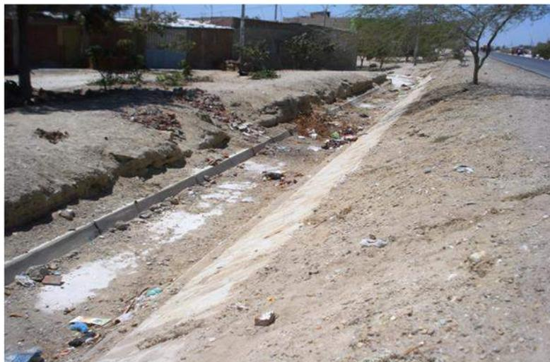
Dren pluvial revestido de concreto simple en el fondo y en solo un talud, nótese la erosión del talud no revestido
