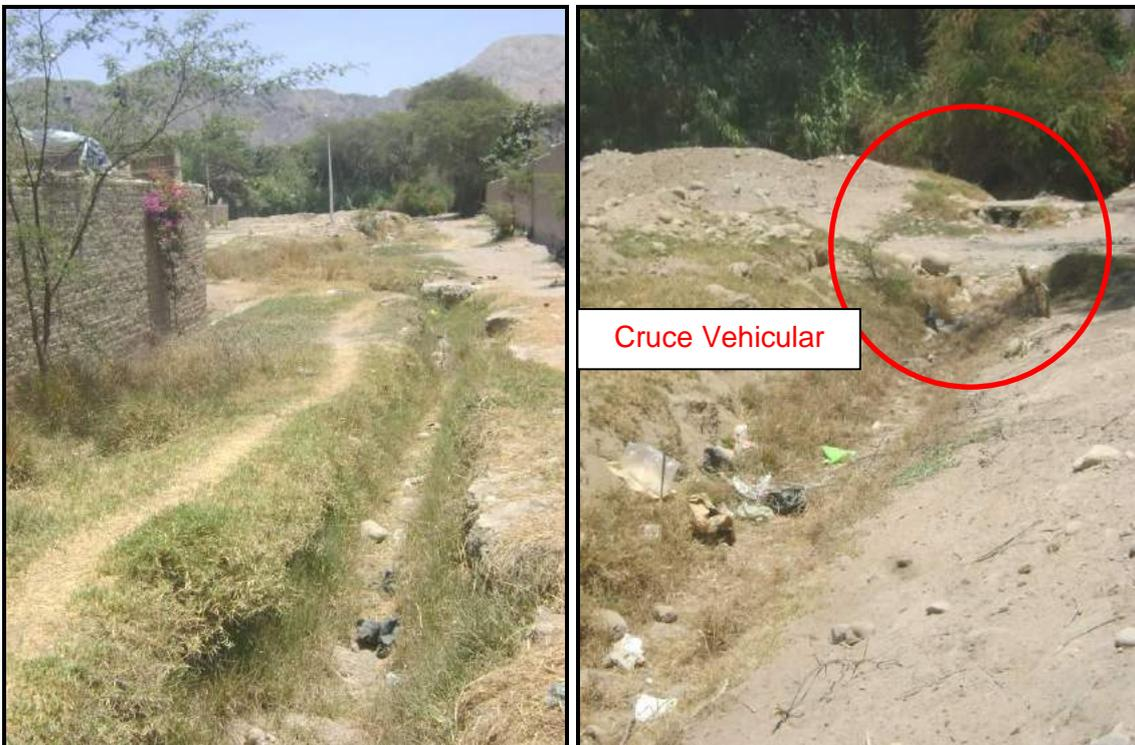
En la fotografía se muestra el canal que sale de la Poza "Huachuca". Izquierda se observa el canal sin mantenimiento, sector donde se produce habitualmente el rebose. Derecha, se observa el cruce de un paso vehicular totalmente inadecuado.
