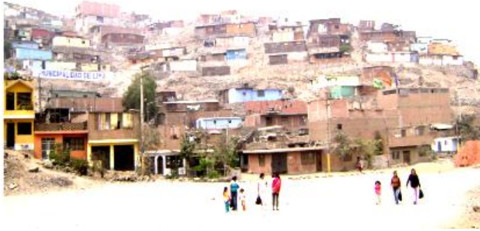
Foto N°24: La altura de edificación predominante en el sector es de 1 piso, sin embargo, existen viviendas que alcanzan los 2 pisos y de 3 pisos. En estos casos la edificación es de ladrillo.
