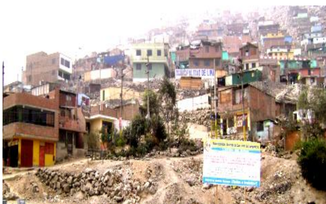
Foto N°26: Edificaciones en mejor regular estado de construcción localizadas en la zona baja de la quebrada.
