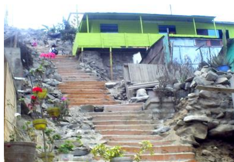
Foto N° 12: Escaleras de concreto ejecutadas por la población.
