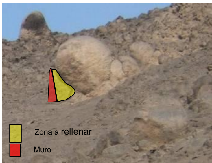
Foto N° 01: Se muestra esquemáticamente el muro y la zona a ser rellenada para formar una cuña.
