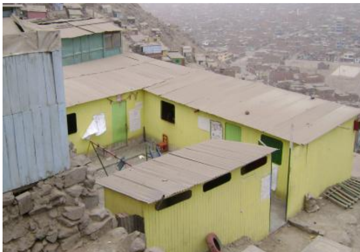
Foto N°04: Centro educativo inicial ubicado en la parte alta de la quebrada construido con materiales livianos y con techo de eternit.
