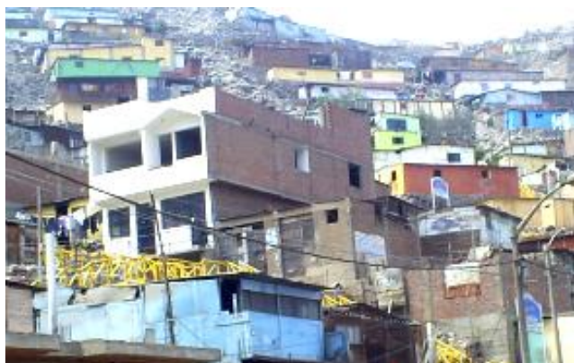
Foto N°22: Edificaciones en buenas condiciones localizados en zona plana o ubicados en terrenos de pendiente moderada que permite una mayor estabilidad en la edificación.
