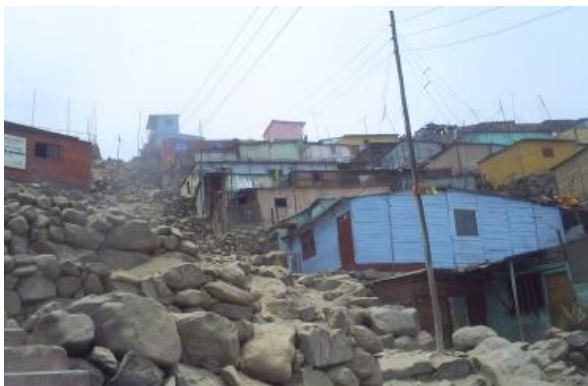
Foto N° 15: Tendido eléctrico rústico y precario en la zona alta del sector generando peligro dentro y fuera de las viviendas.
