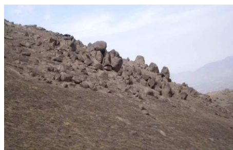
Foto Nº29: Bloques de roca inestable localizados en la parte alta del cerro Negro. Pueden desprenderse de generarse sismos de gran magnitud y lluvias excepcionales.
