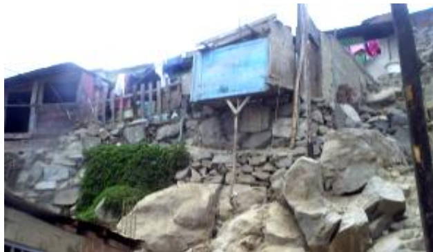
Foto N°19: Pirca de piedras superpuestas sin argamasa que las ligue. Característica de la ocupación en gran parte del Sector Virgen de Fátima y de las laderas en general.
