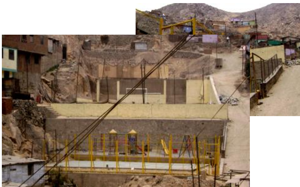
Foto N° 7. Loza deportiva ubicada en el cauce de la torrentera
