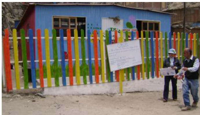
Foto N° 03: Uno de los centros educativos de nivel inicial y primario parcial que funciona además como comedor. Infraestructura de 1 piso de altura, paredes de material liviano y con techos de eternit.
