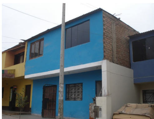
Figura 11. Vivienda de albañilería con cobertura ligera
