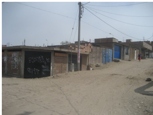
Figura 115. Viviendas de albañilería sin acabados.
