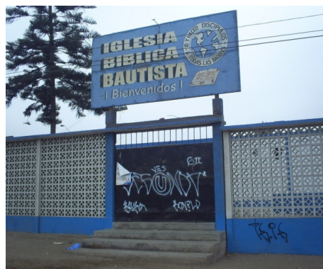
Figura 27. Vista general de la iglesia ubicada en el sector estudiado
