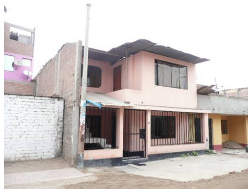
Figura 43. Vivienda de mampostería confinada con cobertura ligera
