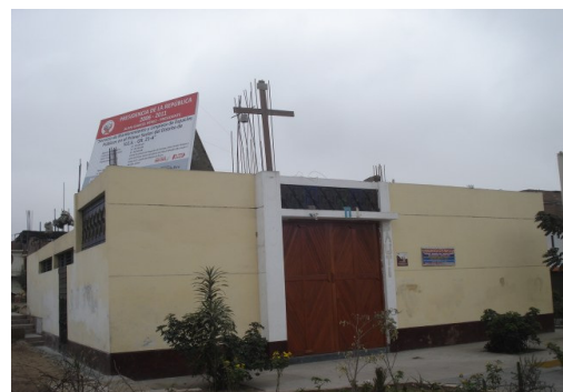
Figura 141. Servicio De Mantenimiento Y Limpieza De Espacios Públicos
