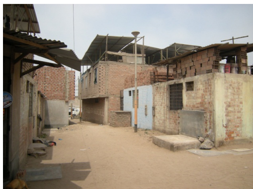
Figura 58. uso de material apilado y cobertura ligera en niveles superiores
