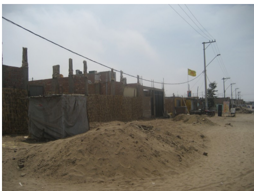
Figura 116. Calles sin asfaltar y huecos para trabajos de saneamiento.
