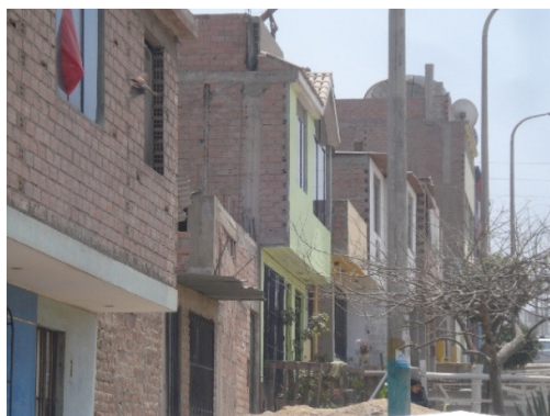
Figura 88. Viviendas típicas, de 2 a 3 pisos en base a albañilería confinada
