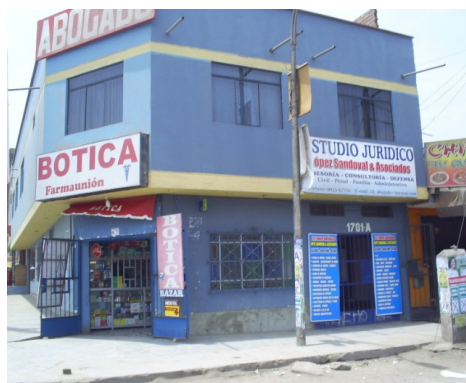
Figura 37. Vista de edificación con uso de vivienda y comercio
