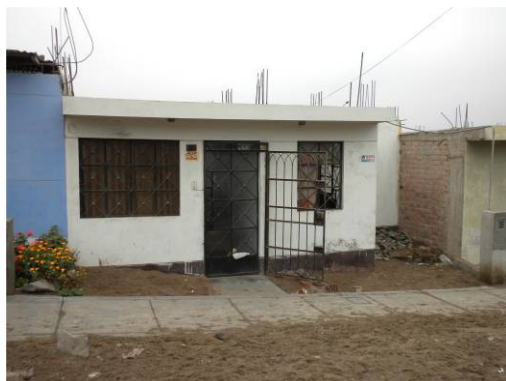
Figura 111. Vivienda de mampostería confinada con diafragma rígido
