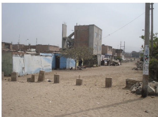
Figura 89. Viviendas rurales mezcladas con viviendas en base a albañilería confinada
