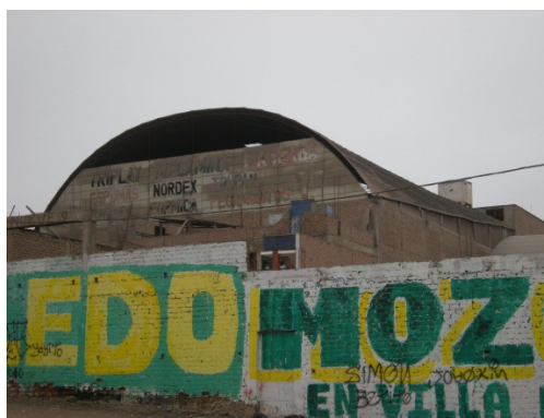
Figura 100. Nave industrial grandes luces y cobertura de planchas sobre armadura metálica
