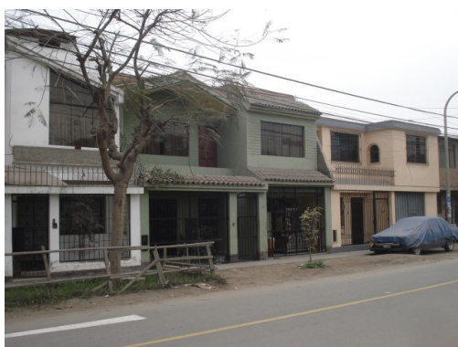
Figura 10. Vivienda de albañilería confinada
