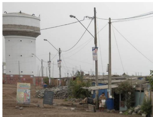
Figura 291. Reservorio de Agua
