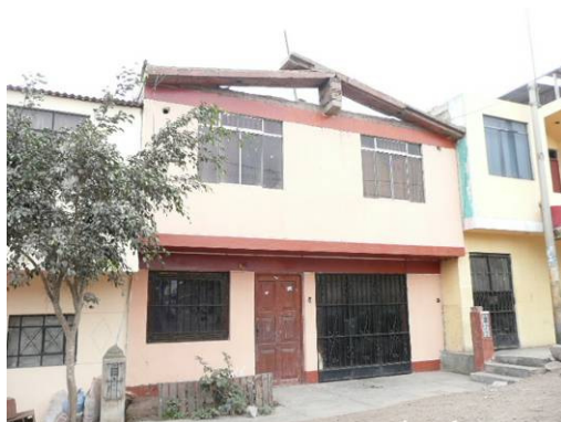
Figura 42. Vivienda de mampostería confinada con diafragma rígido
