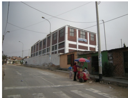
Figura 265. Zona invadida al lado (posterior) de la Parroquia, construcciones informales, provisionales
