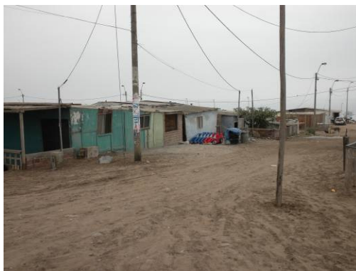
Figura 113. Vía no asfaltada y construcciones de madera
