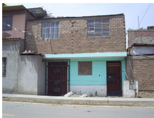
Figura 35. Vivienda típica de albañilería de 2 pisos
