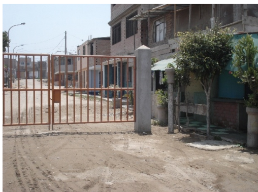
Figura 87. Viviendas típicas, de 1 a 3 pisos en base a albañilería confinada
