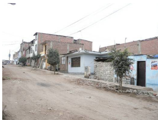
Figura 44. Avenidas no asfaltadas
