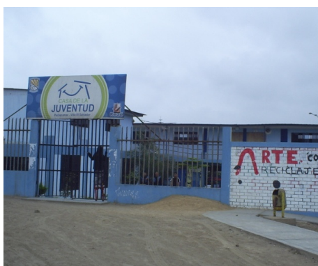
Figura 300. Vista general del local de "La Casa de la Juventud"
