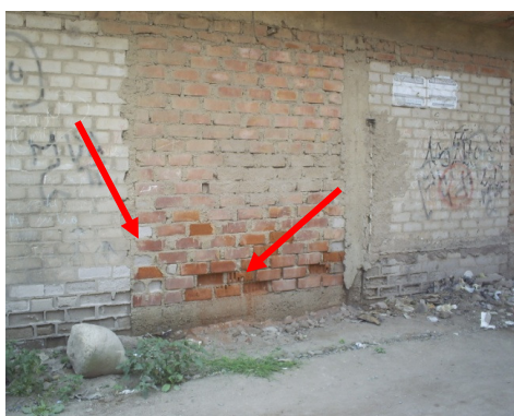
Figura 66. Vista de una vivienda con unidades de ladrillos distintos y en mal estado en un mismo vano
