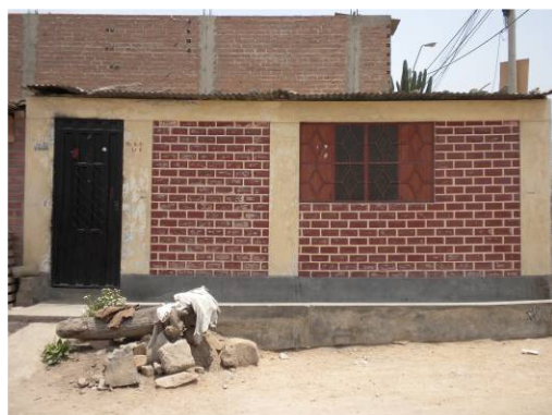
Figura 69. Vivienda de mampostería confinada con cobertura ligera
