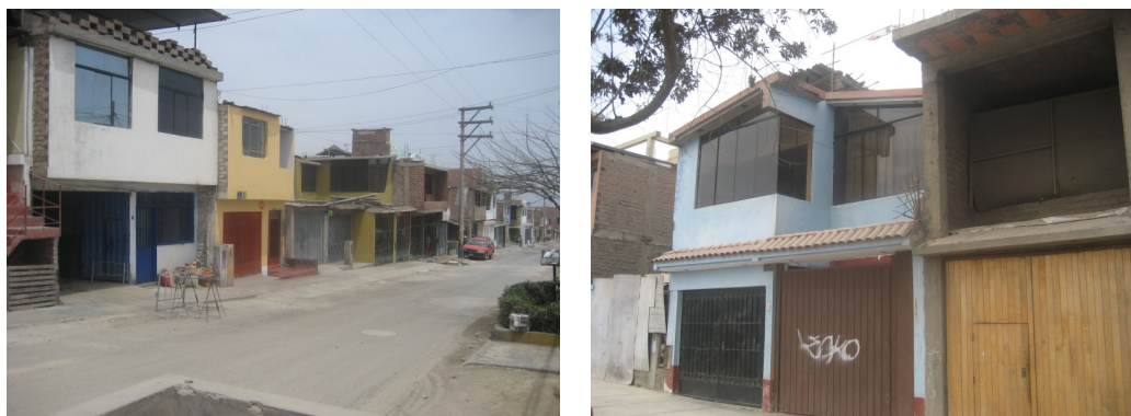
Figura 68. Tipos de edificaciones en el sector 04B
