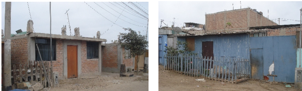
Figura 128. Tipos de edificaciones en el Sector 10E
