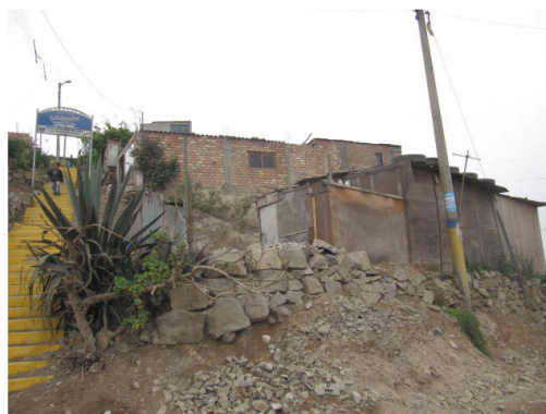
Figura 13. Forma de acceso al cerro, informalidad en la construcción y de la cimentación
