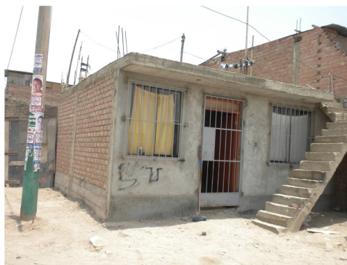
Figura 70. Vivienda de mampostería confinada
