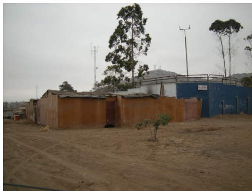
Figura 106. Calle lateral con viviendas informales
