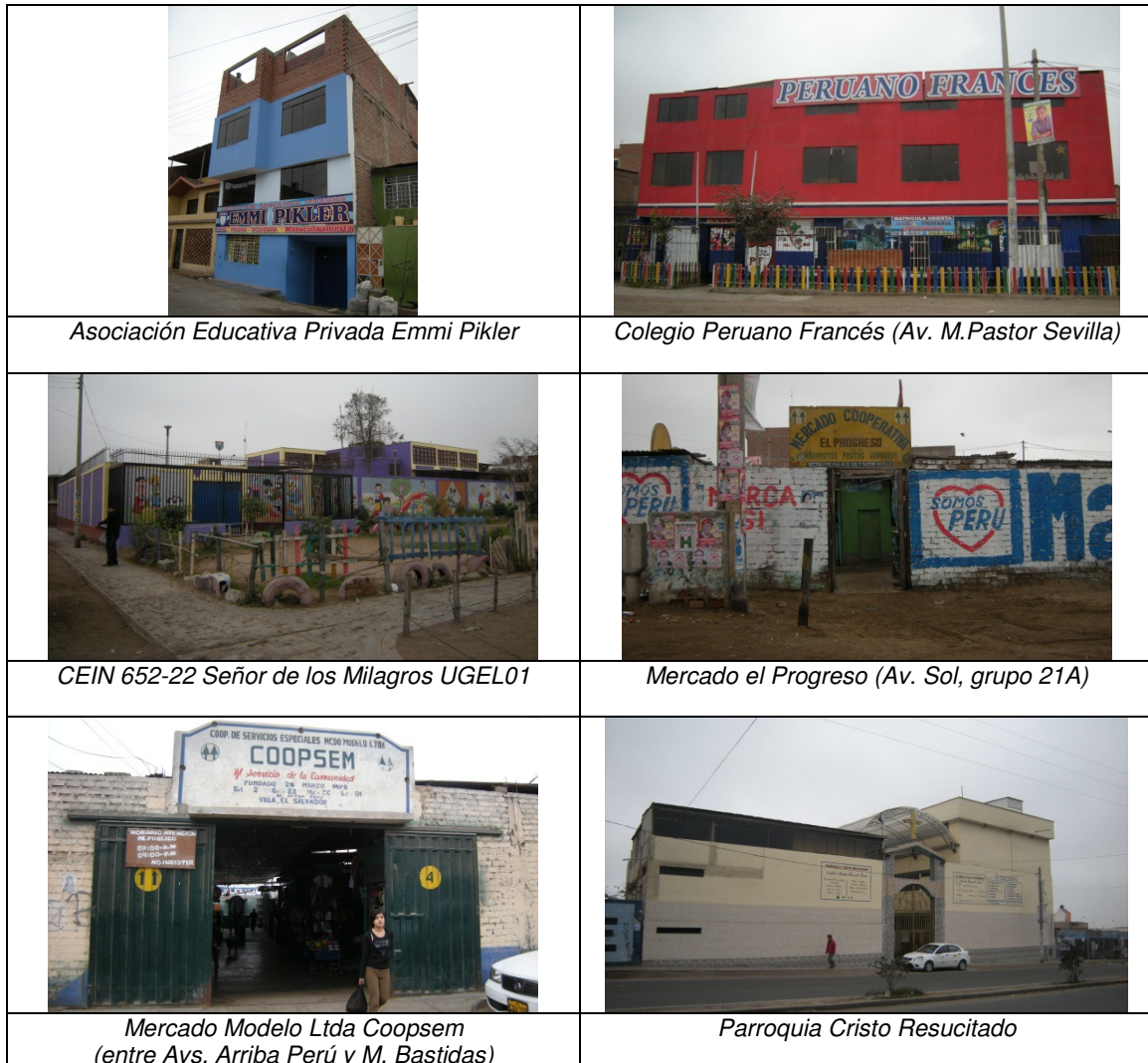
Figura 179: Edificaciones Esenciales e importantes sector 2A.
