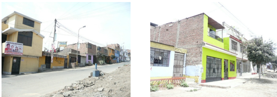
Figura 18. Tipos de Edificaciones en el Sector 1E.
