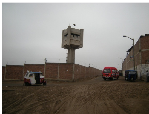
Figura 108. Instalaciones del tren eléctrico
