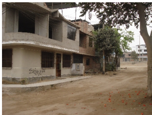
Figura 33. Viviendas típicas de 2 pisos y albañilería confinada
