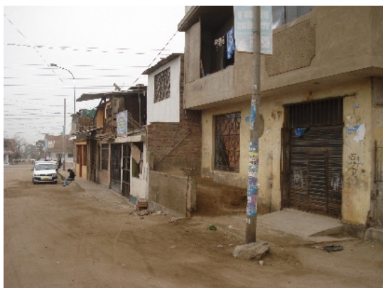
Figura 32. Viviendas típicas, en base a albañilería confinada
