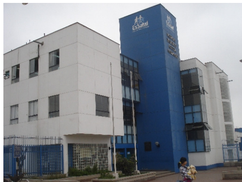
Figura 199. Infraestructura esencial de concreto armado
