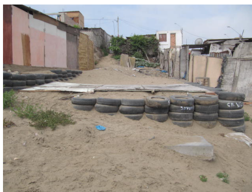
Figura 119. Cimentación informal empleando neumáticos.
