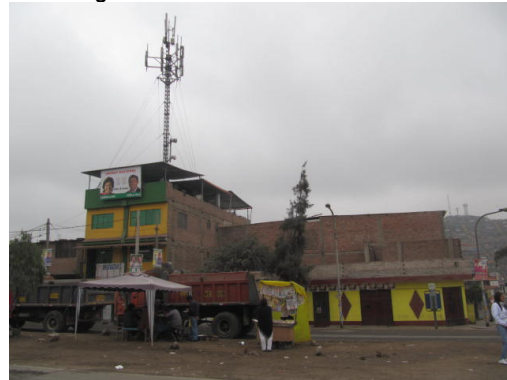
Figura 153. Antena sobre la vivienda
