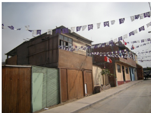
Figura 95. En este caso los dos niveles y vivienda vecina también
