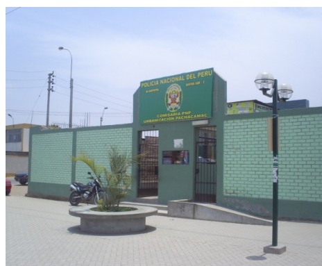
Figura 220. Vista de la Comisaria de la Urbanización Pachamac
