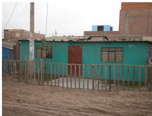
Figura 112. Vivienda de madera con cobertura ligera
