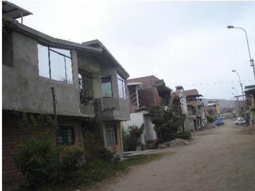
Figura 52. Vivienda de albañilería confinada 02 niveles
