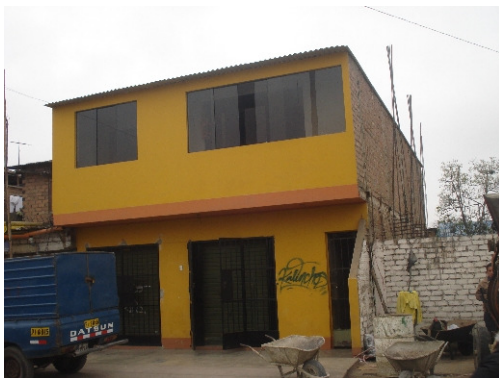
Figura 45. Vivienda de albañilería confinada
