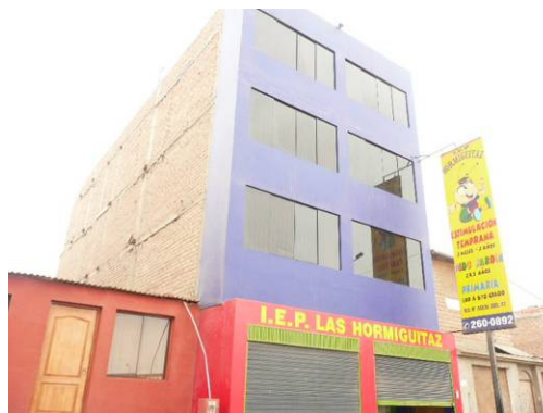
Figura 189. IEP Las Hormiguitas
