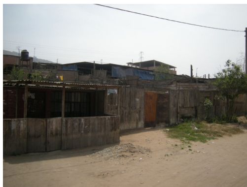
Figura 59. Zona de módulos de vivienda
