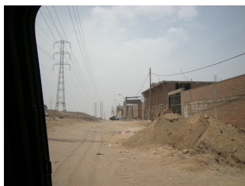
Figura 63. Línea de transmisión en la Av. Pachacútec
