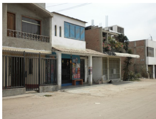
Figura 127. Vivienda de albañilería confinada de 2 niveles
