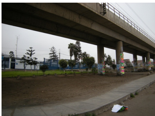
Figura 107. Viaducto para tren eléctrico frente a local Sedapal
