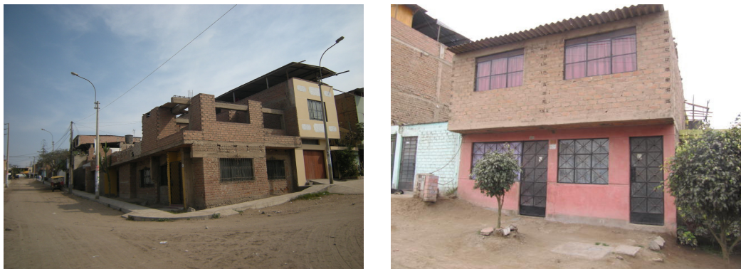
Figura 20. Tipos de edificaciones en el Sector 01D
