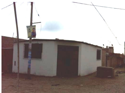
Figura 75. Vivienda de mampostería confinada con diafragma flexible
