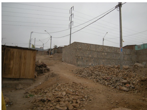
Figura 103. Desnivel en calle de manzanas de viviendas informales
