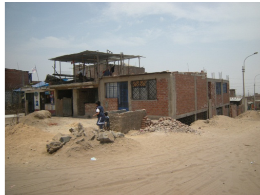
Figura 55. Desnivel entre pista y lote de terreno
