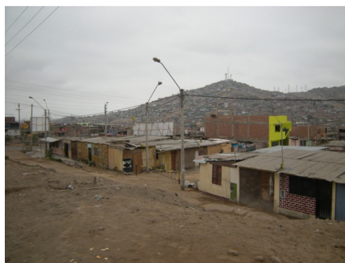
Figura 104. Desnivel entre avenida y manzana, así como viviendas informales (chozas)
