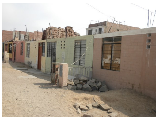
Figura 126. Vivienda de albañilería confinada de 1 nivel
