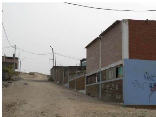
Figura 71. Vía no asfaltada
