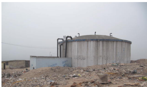
Figura 233. Reservorio de agua
