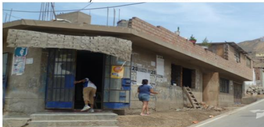
T3: Viviendas de Mampostería Artesanal con ladrillo tubular y techo aligerado
