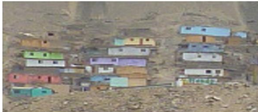
T1: Viviendas de Madera sobre pircas y taludes inestables
