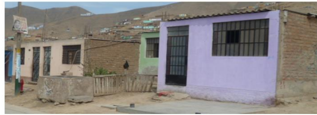
T2: Viviendas de Mampostería Artesanal con ladrillo tubular sin soleras y techo liviano
