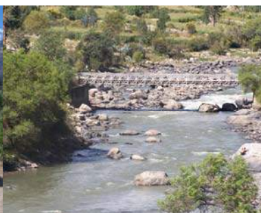
Puente sobre el río Santa – Yungay
