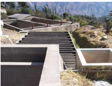
Planta de Tratamiento de agua potable – Yungay
