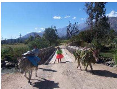
Puente sobre el río Santa – Yungay.
