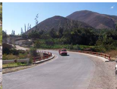
Puente sobre el río Ancash – Yungay
