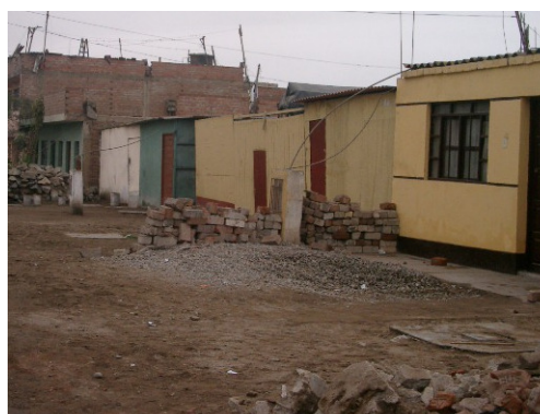
Figura 54. Viviendas con Diafragma Flexibles e Informales
