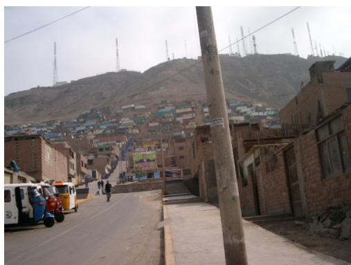
Figura 27. Vivienda de albañilería informal.
