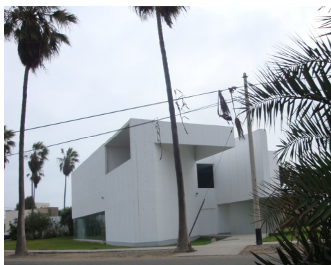
Figura 158. Edificación de Concreto Armado
