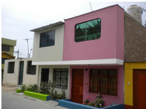
Figura 31. Viviendas de mampostería confinada de 02 pisos
