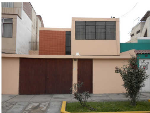
Figura 21. Vivienda de mampostería confinada de 2 pisos
