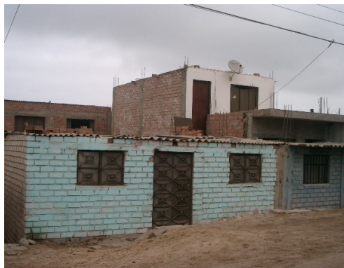
Figura 51. Vivienda de albañilería informal.
