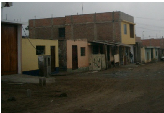
Figura 50. Viviendas de albañilería confinada.
