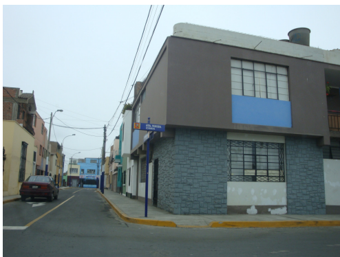
Figura 10. Vivienda de albañilería confinada.
