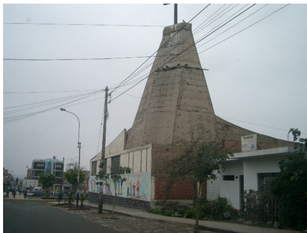
Figura 147. Infraestructura esencial de concreto armado
