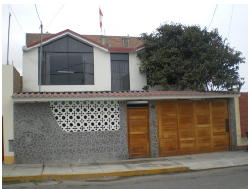
Figura 43. Vivienda de albañilería confinada.
