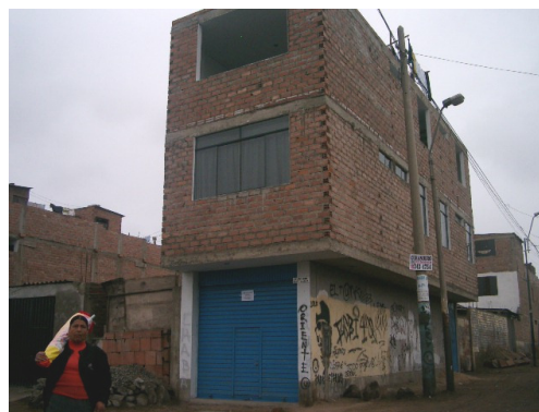
Figura 53. Vivienda de albañilería informal.
