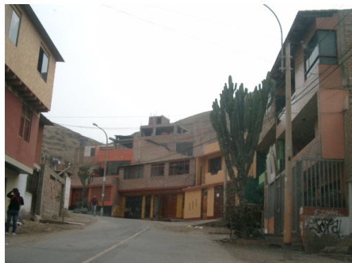
Figura 26. Vivienda de albañilería confinada de 03 niveles.
