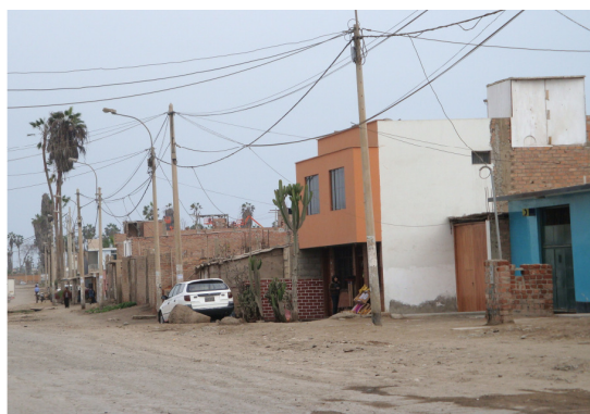
Figura 59. Vivienda de albañilería informal.
