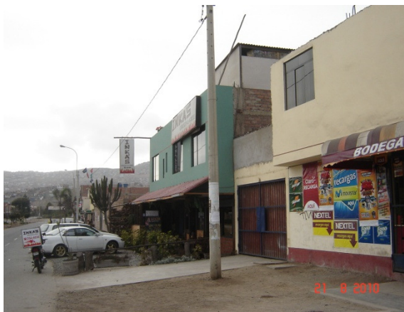
Figura 64. Viviendas destinadas a comercio.
