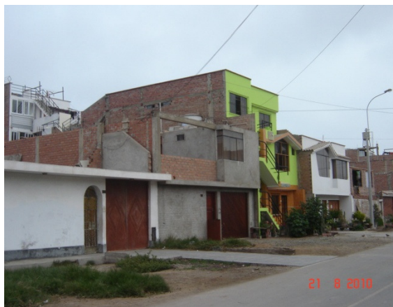
Figura 65. Viviendas predominantes de reciente construcción.
