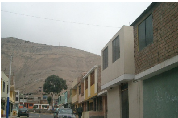
Figura 25. Vivienda de albañilería confinada de 02 niveles.
