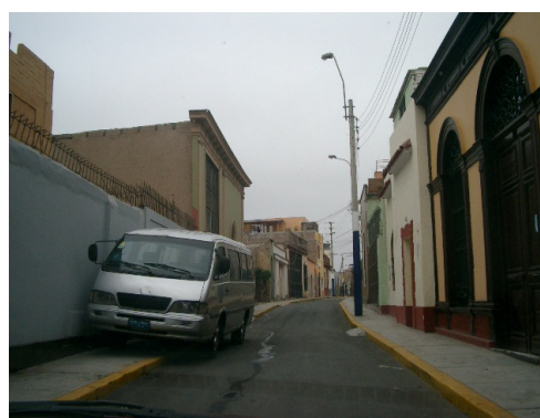
Figura 13. Viviendas de adobe.
