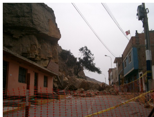
Figura 28. Viviendas en peligro
