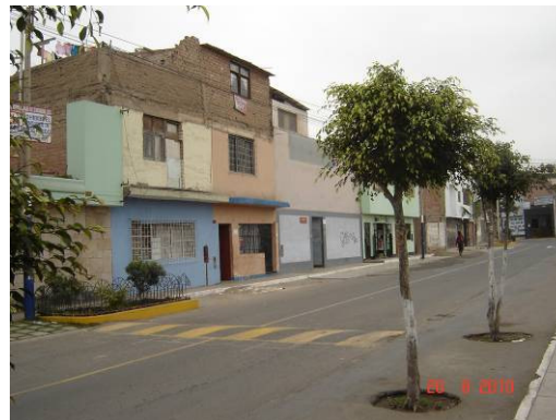
Ampliación en albañilería
