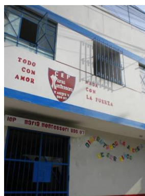
Figura 136. Colegio Maria Montessori de mampostería confinada
