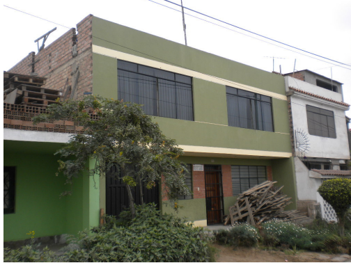
Figura 47. Vivienda de mampostería confinada con diafragma rígido de 2 pisos en buen estado
