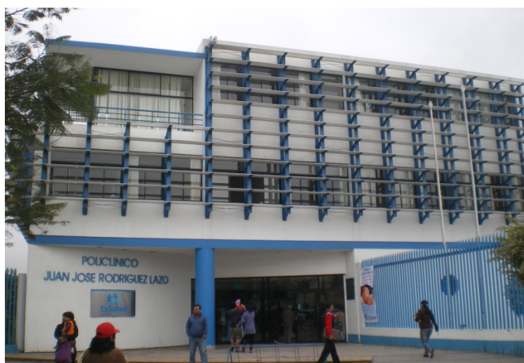
Figura 134. Infraestructura esencial de concreto armado.
