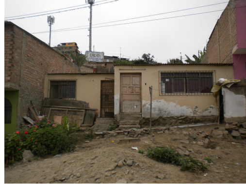
Figura 48. Vivienda de mampostería confinada con techo flexible de 1 piso en regular estado
