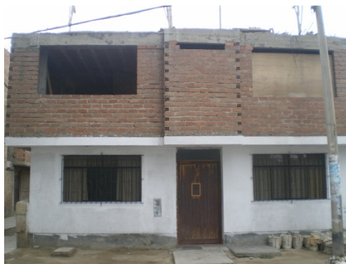
Figura 44. Vivienda de albañilería informal.
