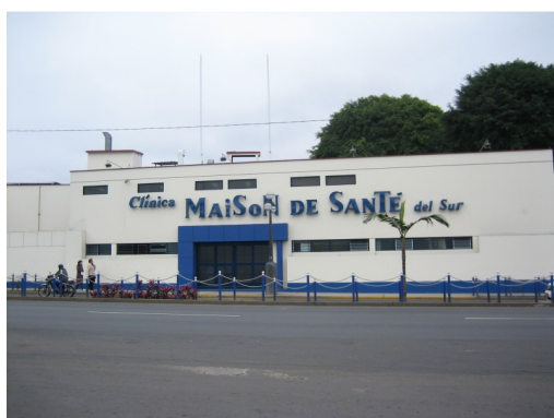
Figura 86 – Clínica Maison de Santé del Sur
