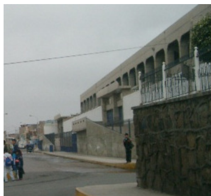
Figura 100. Infraestructura importante de concreto armado.
