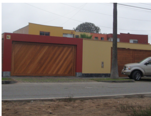
Figura 58. Vivienda de albañilería confinada de 02 niveles.
