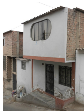
Figura 32. Vivienda de mampostería con cobertura ligera
