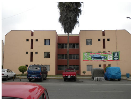
Figura 22. Vivienda Multifamiliar de mampostería confinada de 3 pisos
