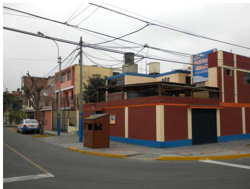
Figura 92. Colegio inicial – primaria de mampostería confinada
