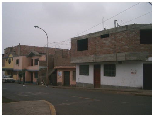
Figura 52. Vivienda de albañilería confinada.
