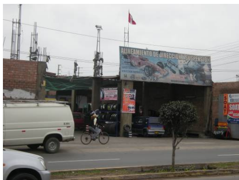
Figura 36: Av. Alameda Sur. Taller con estructura deficiente
