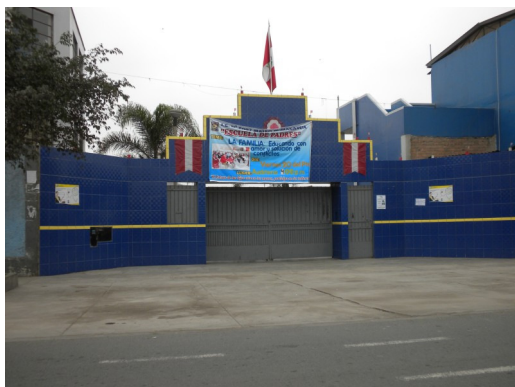
Figura 148. I.E. Mateo Pumacahua de concreto armado y mampostería.
