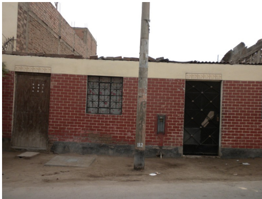
Figura 55. Vivienda de mampostería confinada de 1 pisos
