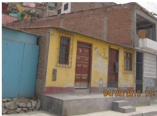
Figura 29. Vivienda de mampostería confinada de 1 piso
