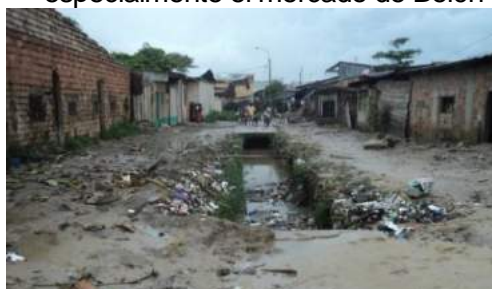
Foto 05.54: Contaminación odorífera: Aguas servidas. Fuente: E.T, PCS-Iquitos, 2014
