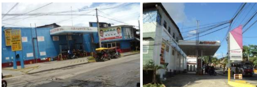
FotoS 05.70 y 05.71: Grifos en el centro de Iquitos ubicados en espacios estrechos e inseguros. Instalados con escasas condiciones de seguridad en el centro de Iquitos-Peligro incendios o explosiones Fuente: E.T, PCS-Iquitos, 2014
