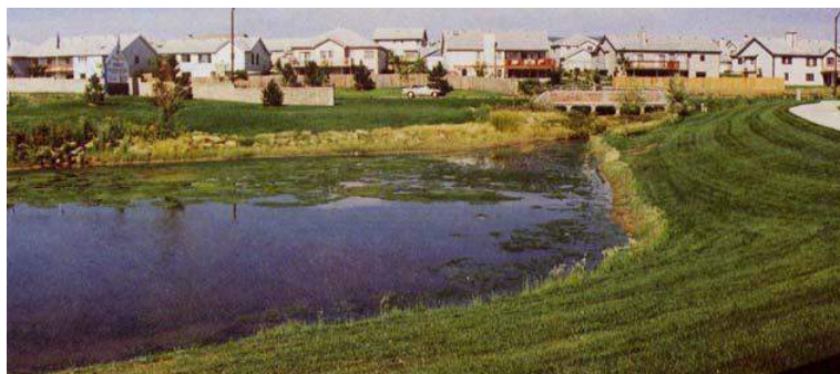
Figura 3.1.3.: Laguna de retención aprovechando una hondonada, E.E.U.U.
