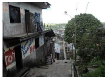
Foto 05.29: Ídem. Aguas residuales que discurren por canaletas a cielo abierto por falta de alcantarillado-Zona Belén (Fuente: E.T, PCS-Iquitos, 2014)
