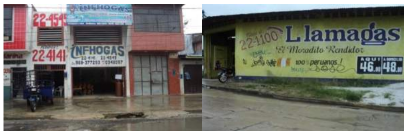
Foto 05.72 a y b: Locales de venta de gas doméstico inseguros con balones expuestos a la vía pública o cerrados con escasa ventilación Peligro incendios, explosiones, fugas de gas
