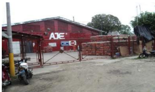
Foto 05.84: Planta embotelladora de bebidas-Peligro incendios y explosiones-San Juan. (Fuente: E.T, PCS-Iquitos, 2014)
