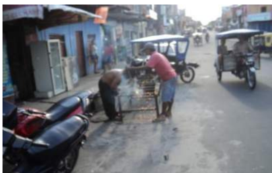
Foto 05.80: Taller de soldadura en vía pública (Belén)- peligro incendios.
