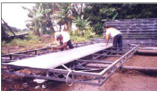
Fabricación e instalación de paneles metálicos en la obra
