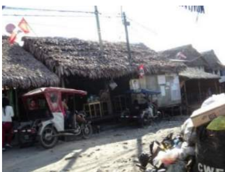
Foto 05.76: Viviendas construidas con materiales de fácil combustión (Belén). Fuente: E.T, PCS-Iquitos, 2014
