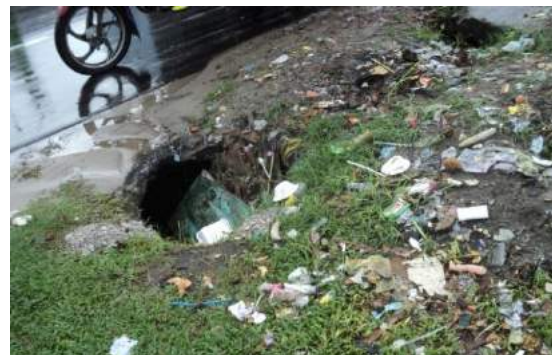
Foto 05.13: Buzón abierto con residuos sólidos, focos de roedores y cucarachas con peligro de epidemias. Fuente: E.T, PCS-Iquitos, 2014
