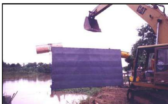
Traslado de los paneles metálicos en la obra
