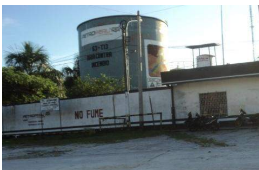
Foto 05.32: Planta de venta de PETROPERU (Fuente: E.T, PCS-Iquitos, 2014)
