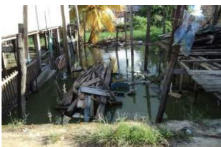
Foto 05.14: Distrito de Punchana: Aguas estancadas, estructuras de madera y residuos sólidos, que constituyen focos infecciosos.
