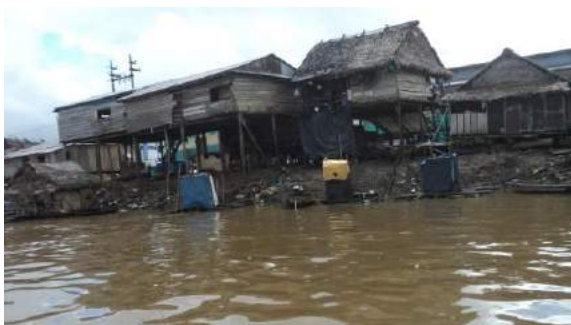
Foto 05.42: Instalación de letrinas sobre las aguas del río Itaya (Belén) generando contaminación en las aguas de dicho río. (Fuente: E.T, PCS-Iquitos, 2014)
