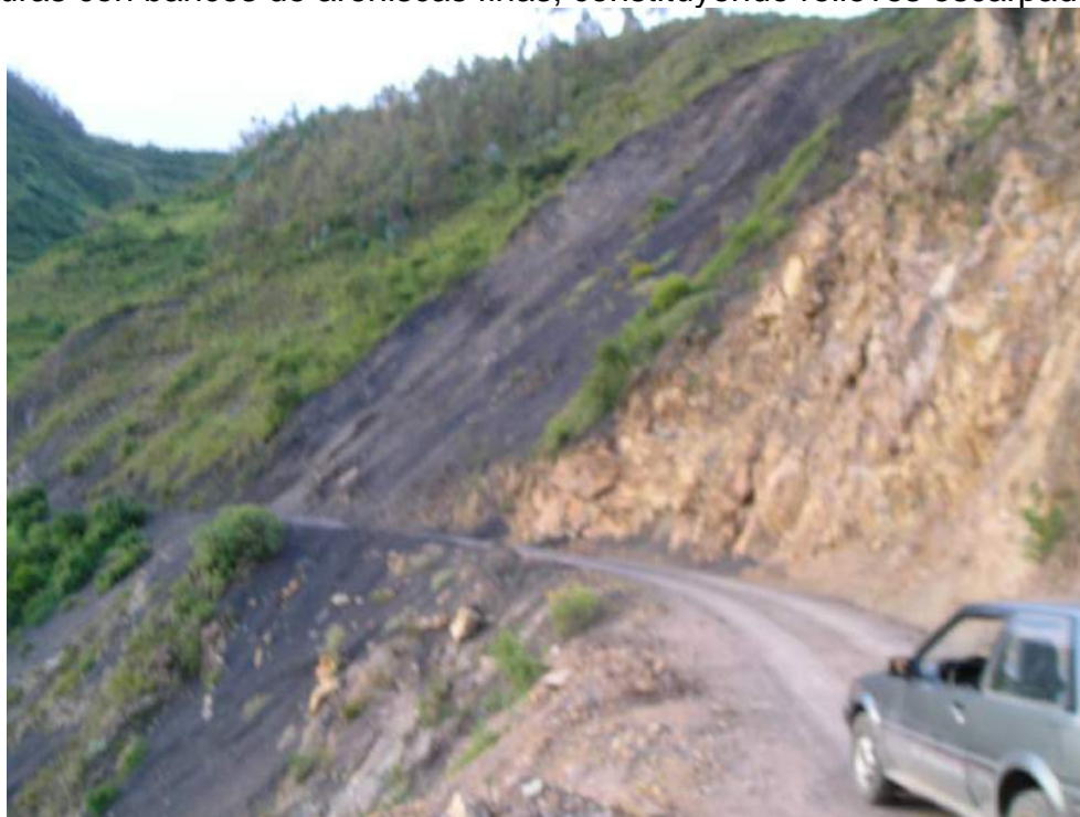
Foto – 16: Vista fotográfica del afloramiento de las calizas Copacabana ubicados en la parte superior de la ladera, contacto entre calizas Copacabana y Grupo Mitu
