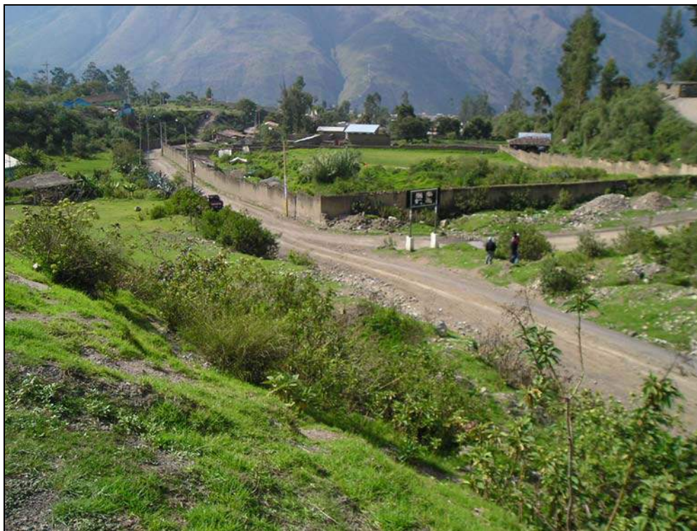
Foto – 31: Cauce del Río Chinchichaca y zona de impacto del aluvión con la ciudad de Abancay en la zona de Maucacalle.
