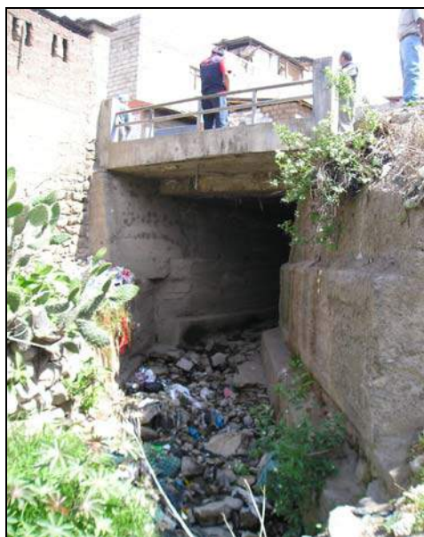
Foto – 34: Cauce del río Chinchichaca en la zona del jirón Altipuerto
