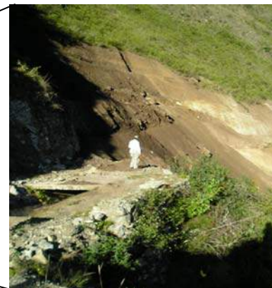
Zona de arranque del deslizamiento.
