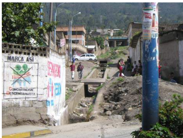
Foto – 32: Canalización del Río Ullpahuayco en la Avenida Seoane (Zona de encuentro con el Río Chinchichaca)
