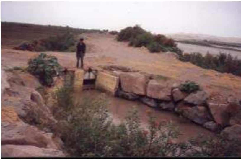
Una de las compuertas del río Camaná, que dan lugar al ingreso no controlado del agua.
