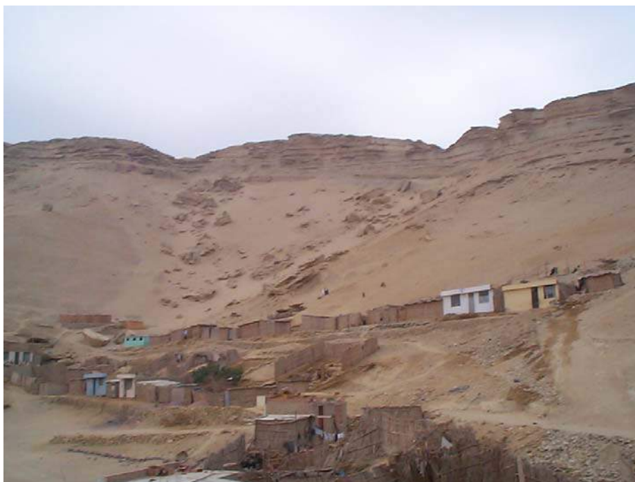
Foto 4.18: Viviendas precarias, cercana a laderas con peligro de derrumbe y deslizamientos de rocas, con una muy alta vulnerabilidad. Sector, Micaela Bastidas.
