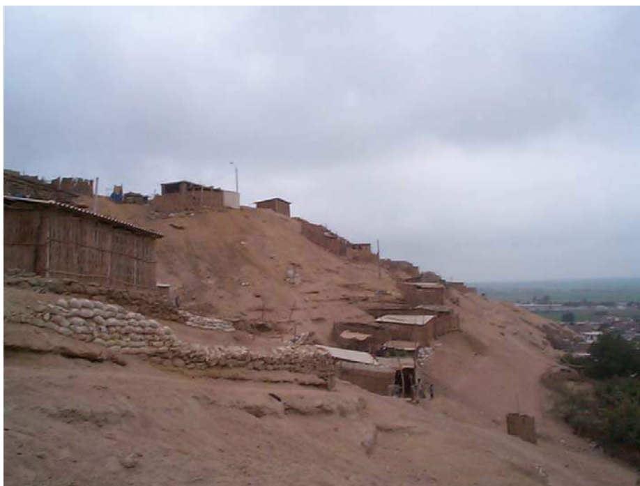
Foto 4.9: Pendientes y deslizamientos en Villa Paraíso.
