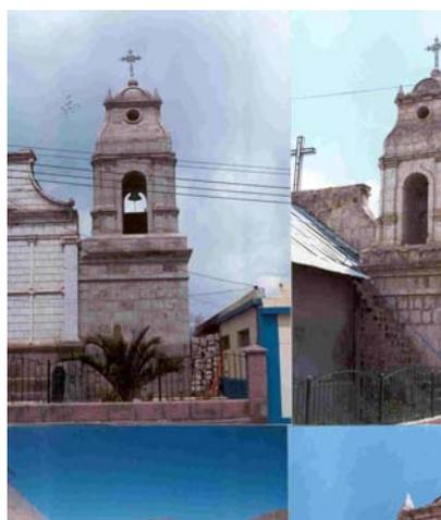
*Actualmente la Iglesia de Candarave, viene siendo reconstruida, con columnas de concreto armado y adobe, dos materiales que no son correspondientes para formar un sistema constructivo adecuado al alto riesgo sísmico que se le atribuye a la zona.*
