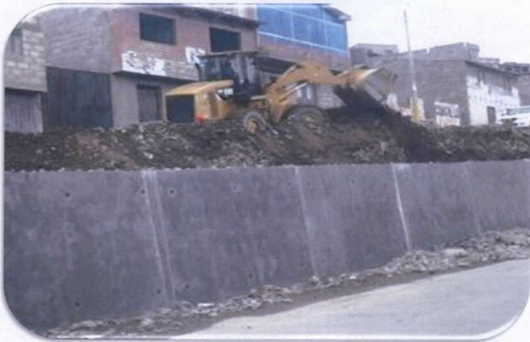
EQUIPO PESADO RELLENANDO Y COMPACTANDO TERRENO PARA ESTRABILIZACION DE TALUD.
