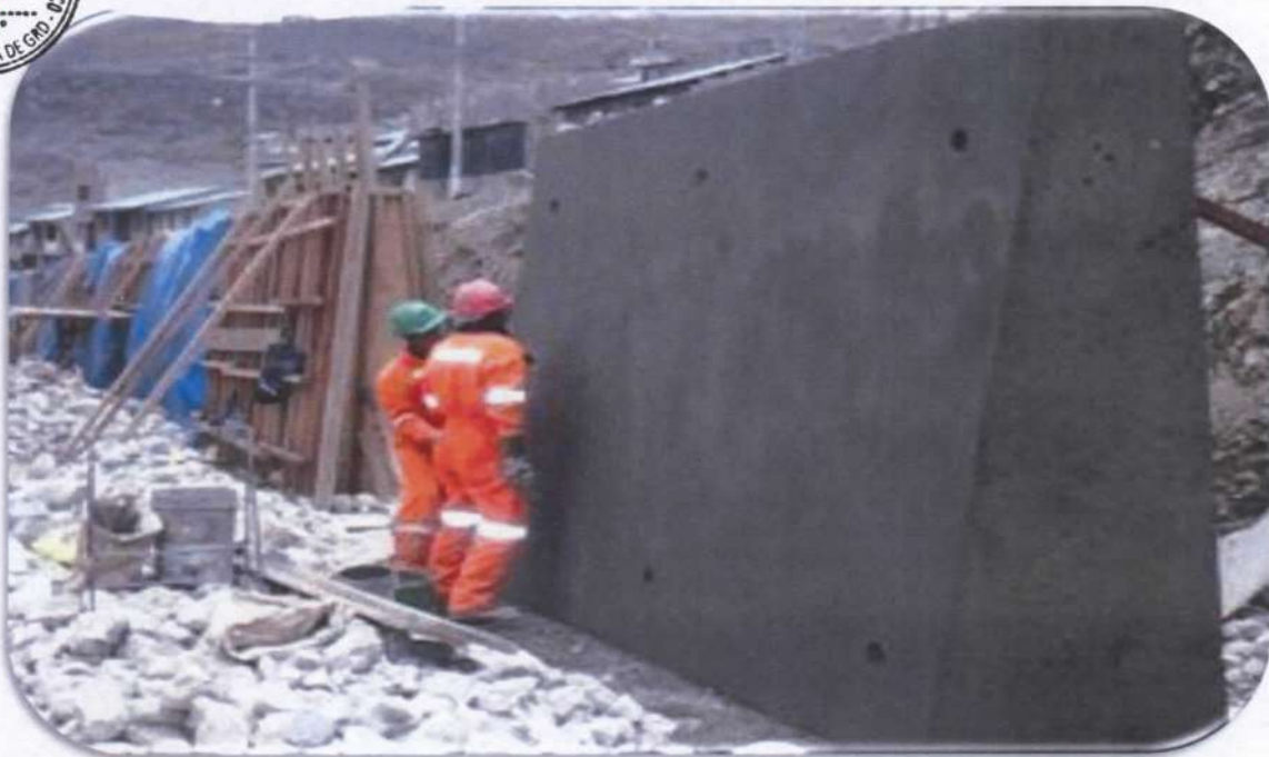
MUROS DE CONCRETO ARMADO CON DESAGÜES DE PVC DE 2 PULGADAS, PARA DRENAJE DE AGUAS PLUVIALES.
