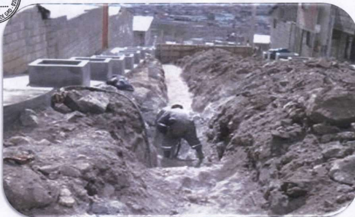
TRABAJOS PREVIOS PARA LA REALIZACION DE GRADERIAS DE CONCRETO ARMADO, DRENAJE PLUVIAL, OBJETIVO ESTABILIZAR LADERAS.
