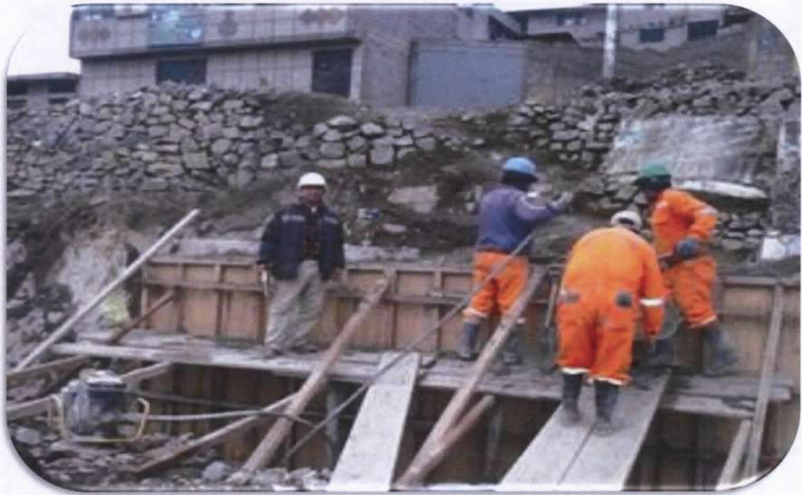
MURO DE SOSTENIMIENTO CON CONCRETO ARMADO PARA REDUCIR ALTURA DE TALUD.
