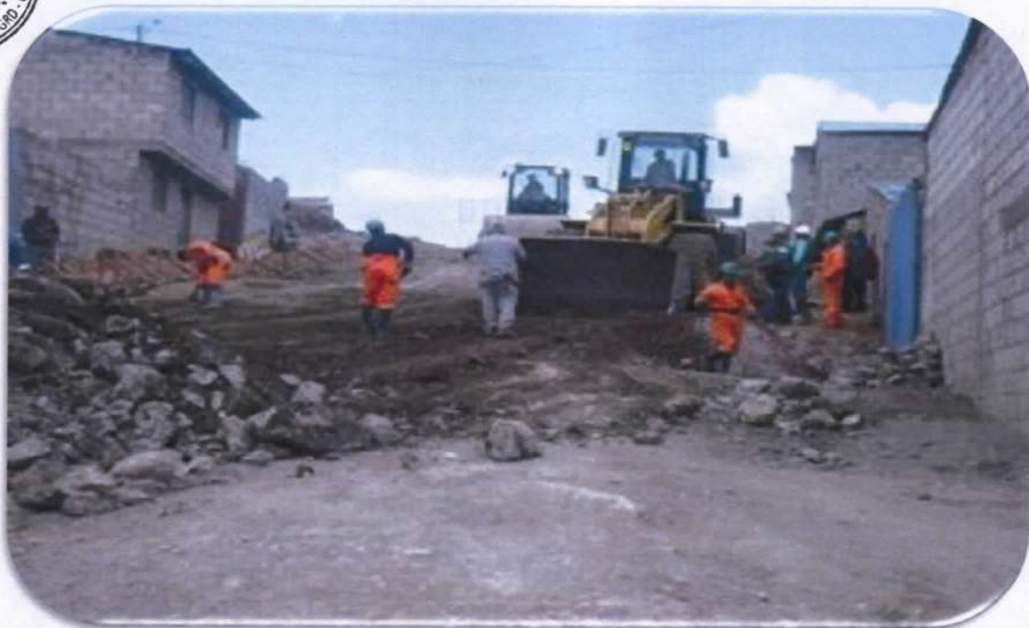
MAQUINARIA PESADA NIVELANDO Y COMPACTANDO TERRENO PARA IMPLEMENTACION OBRAS DE REDUCCION DE RIESGOS.
