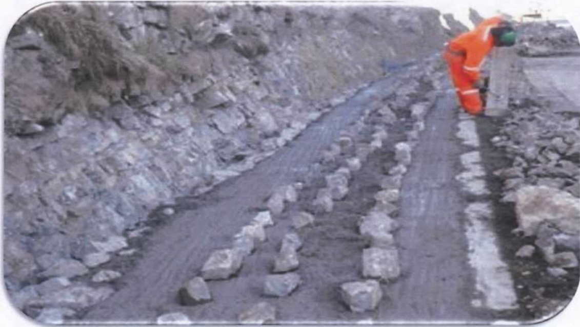
ESTABILIZACION DE TALUDES CON MUROS DE CONCRETO, PARA SOSTENIMIENTO DE ROCAS FRACTURADAS.
