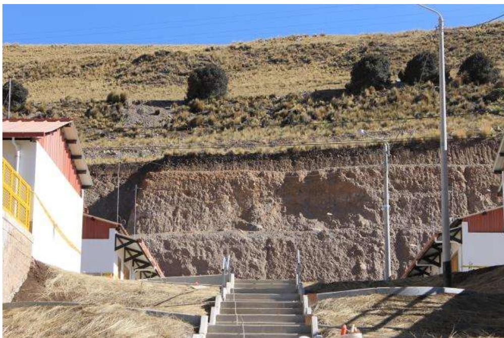
Foto 10: Detalle del tipo de suelo en que se asienta parte de la nueva ciudad de Morococha. Ladera NE del C° Pincullayoc. Al SO de la Nueva Ciudad. Gravas arenosas y grabas arcillosas medianamente densas.
