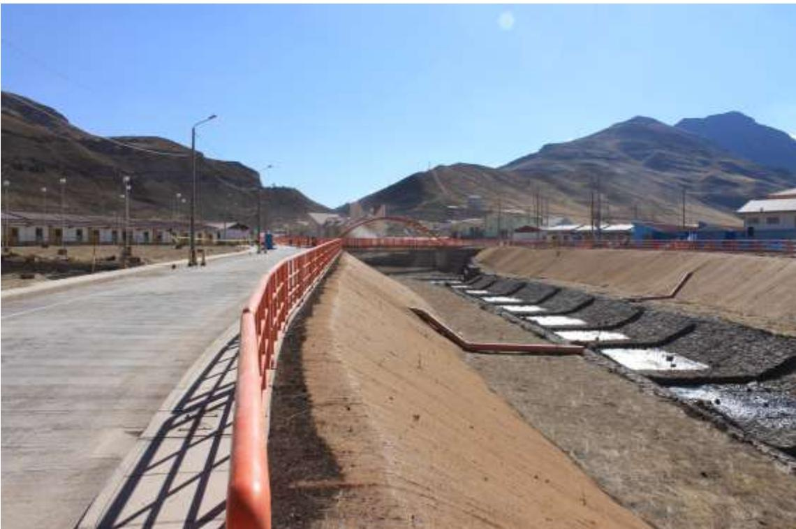
Foto 7: Vista de la quebrada Huascacocha, aguas arriba de la Foto 6. Detalle de las obras de contención realizadas. Vista al SSO.
