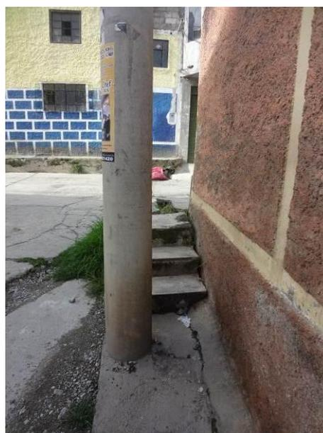
Postes de alumbrado en medio de las veredas y secciones de vereda intransitables, fuera de la normatividad
