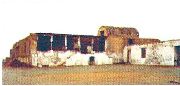
Actual edificación de Punchauca (Foto S. Tácunan 2009)
