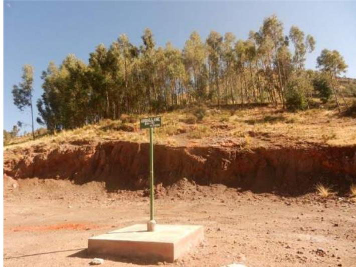
**Foto N° 14:** Pozo de extracción (RH-10) de crudo en el Campo Petrolífero de Pirin – Huancane, se encuentra cubierto por concreto de allí emanaba hasta hace 5 años atrás material de origen orgánico.
