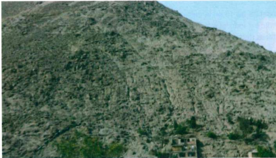
Foto 27. La erosión de laderas produce material suelto que "tapiza" las vertientes de la quebrada Libertad.
