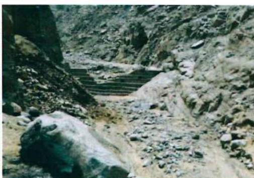
Foto 17. Muro disipador de energía impactado por grandes bloques como el que aprecia aguas abajo durante el paso del flujo de detritos del 23-03-15.
