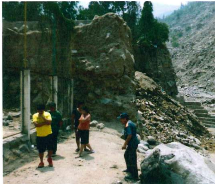
Foto 10. Margen derecha de la quebrada Pedregal, la pared de los depósitos aluviales antiguos ha sido reducida por construcción de estadio.
