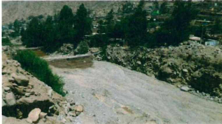
Foto 7. Muro disipador de energía, se encuentra casi totalmente cubierto por sedimentos. Las márgenes de la quebrada muestran depósitos caóticos de huaicos antiguos con matriz-soportada típico de flujos de detritos.
