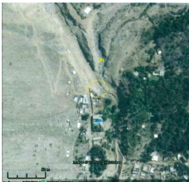
Figura 19. Muro destruido por un flujo de detritos de afluente por la margen izquierda al a quebrada Pedregal. En esa área se produjo el socavamiento de la terraza aluvional antigua.
