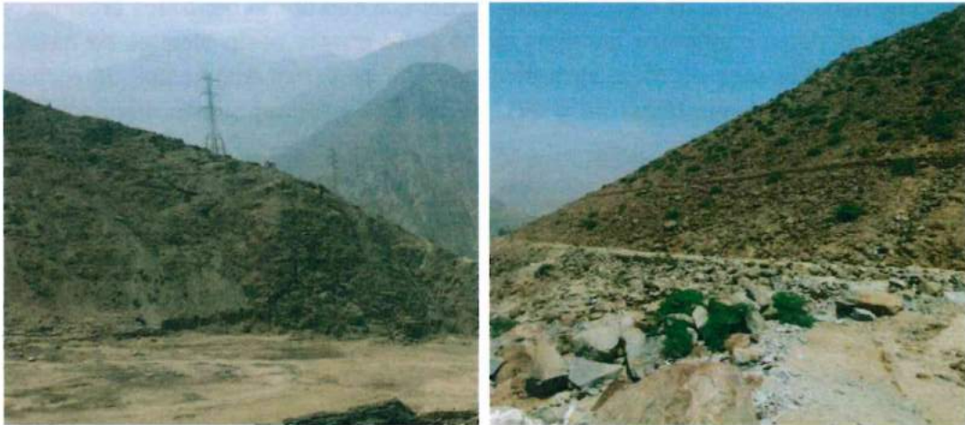
Foto 62 y Foto 63. Se muestra las pendientes que tienen las laderas de la quebrada Cashahuacra.
