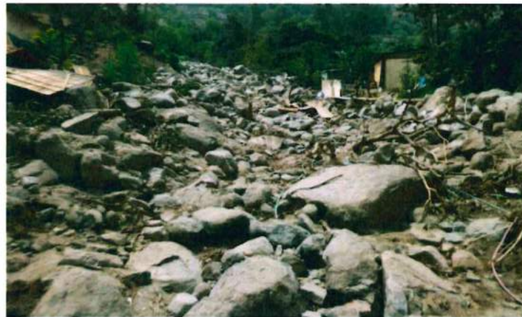
Foto 18. Material transportado por la avalancha de rocas, que afectó a viviendas.
