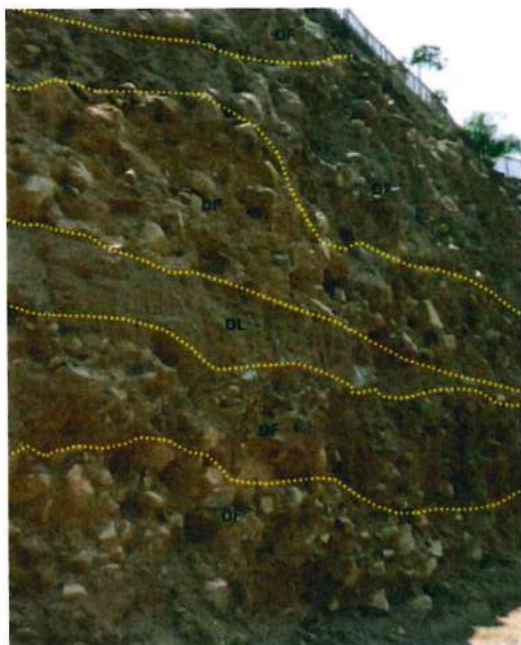
Foto 43. Se aprecian varios niveles de flujos de detritos (DF) y de flujos de lodo (DL). Quebrada Rayos de Sol
