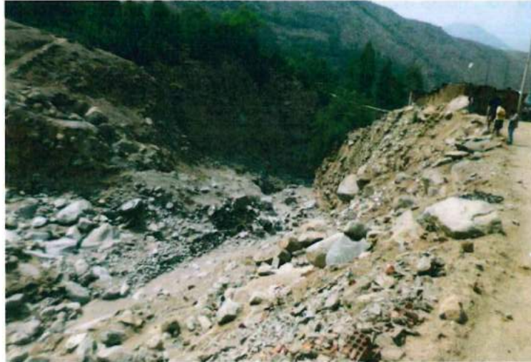
Foto 9. Se aprecia el ancho actual de la quebrada, en el sector San Antonio-Anexo 13.
