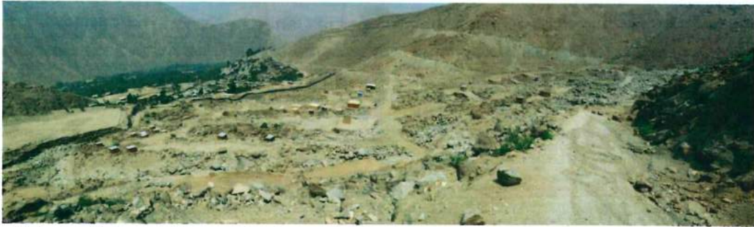
Foto 61. Vista en el terreno donde se aprecian las viviendas ubicadas en pleno cauce de la quebrada.
