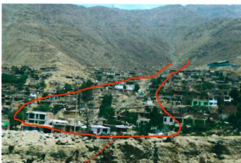
Foto 5. Viviendas asentadas en la margen derecha de la quebrada Quirio, se encuentran sobre antiguos depósitos de avalanchas de rocas.
