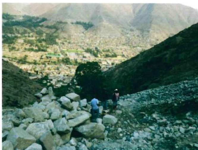
Foto 33. Se aprecia las laderas con pendientes entre 45° y 35° en la parte alta de la quebrada.
