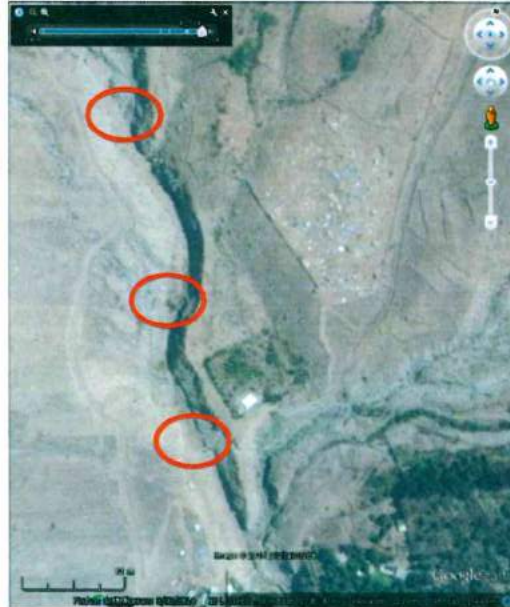
Figura 18. Imagen 2014, los muros disipadores de energía se aprecian tenuemente (rojo).
