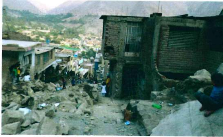
Foto 37. Calle que sirvió como cauce del flujo.
