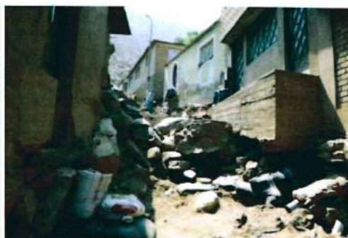
Foto 30 y Foto 31. Erosión de bases de las viviendas y vía de acceso ocasionado por el paso del flujo.
