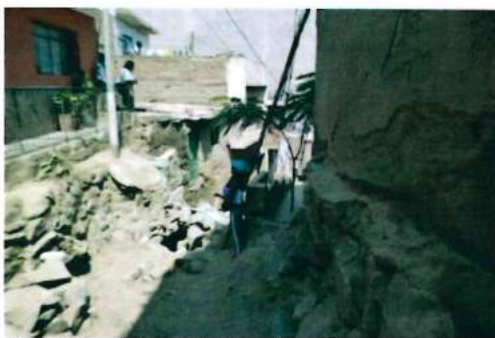
Foto 30 y Foto 31. Erosión de bases de las viviendas y vía de acceso ocasionado por el paso del flujo.
