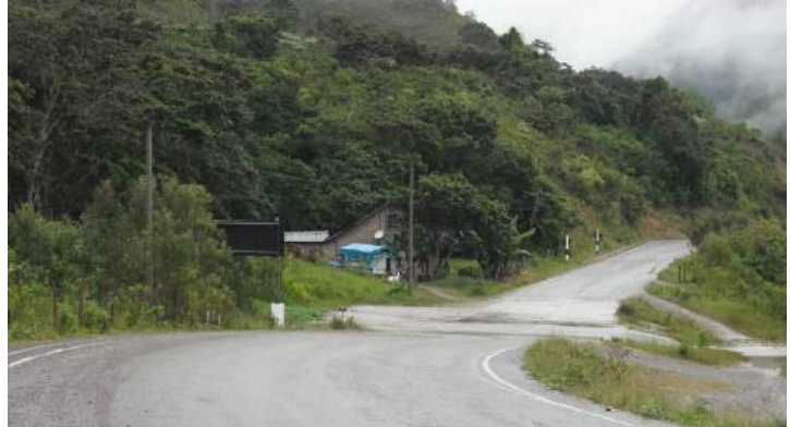
Foto N° 85 Badén: sistema de paso a nivel de escorrentía sobre la carretera Puente Paucartambo-Oxapampa, zona de Llamaquizú
