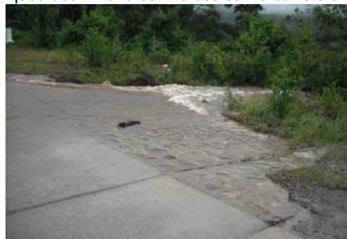
Foto N° 81 Descarga a través de un badén quebrada Miraflores I –cruce con la carretera
