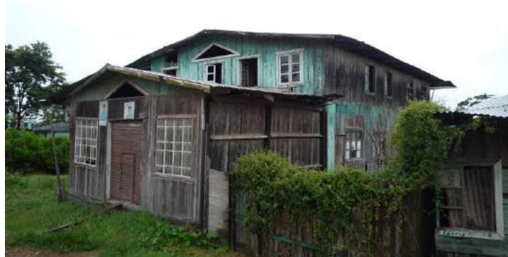
FOTO 56: Vivienda en la Av. San Martín
