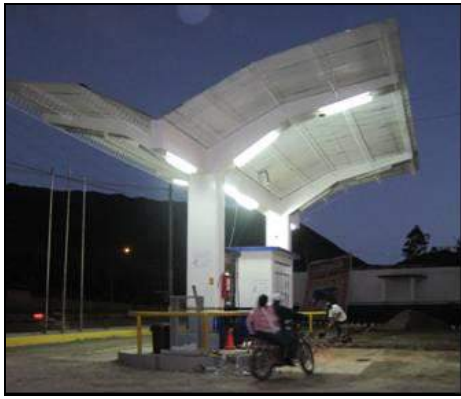
Foto N ° 130. La Nueva Esperanza E.I.R.L (Grifo Nueva Esperanza) Situado en Av. San Martín N° 1514 en el Barrio San Alberto.
