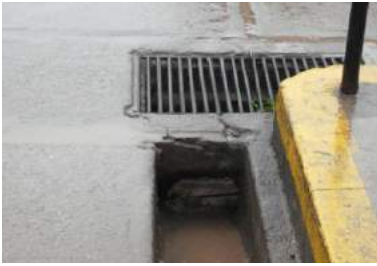
Foto N° 84 Sumidero continuo rectangular sin cobertura y con cobertura. Representada por rejillas metálicas
