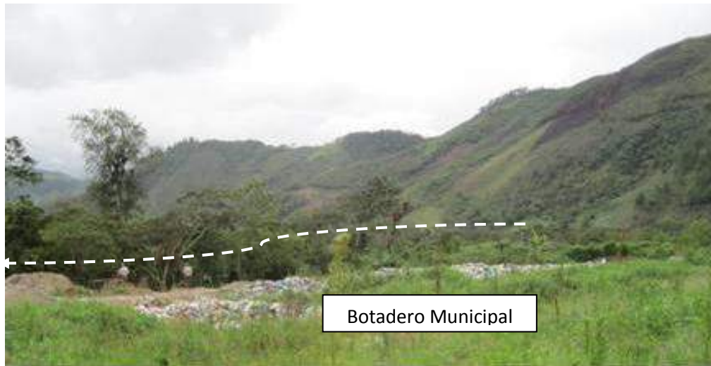
Foto N ° 115 Botadero Municipal ubicado en una zona con una fuerte pendiente.
