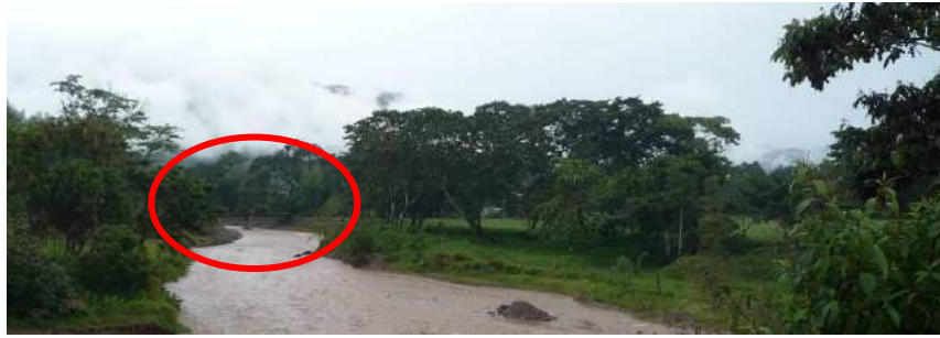
Puente peatonal que une ambas márgenes del río La Esperanza
