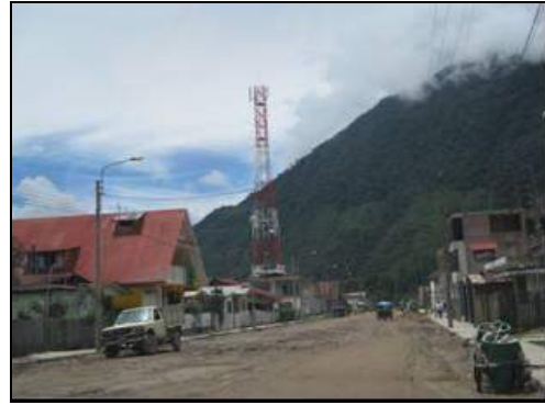
Foto N ° 124. Peligros de contaminación electromagnética.
