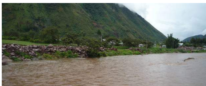
Enrocado del río Chontabamba
