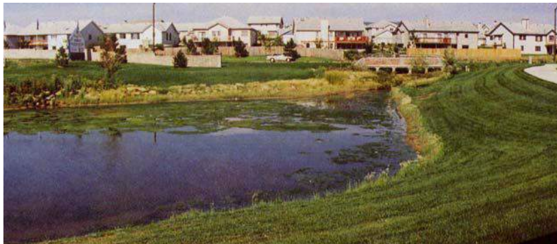
Figura 3.1.3.: Laguna de retención aprovechando una hondonada, E.E.U.U.
