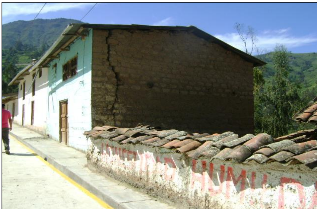
Foto 17: Vivienda antigua ubicada en el distrito de Huachos
