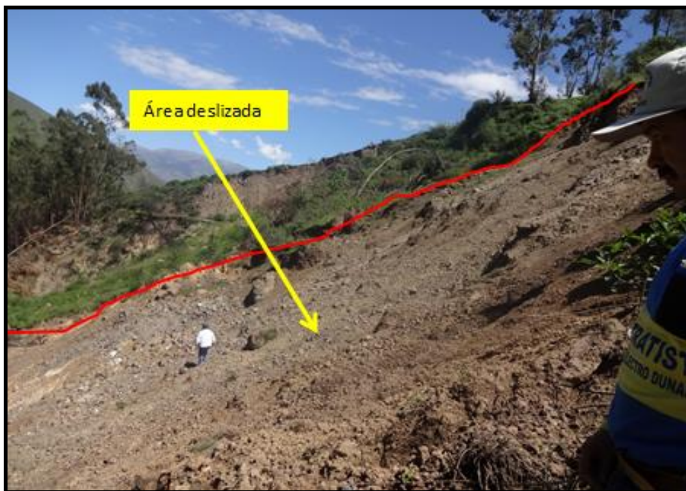
Foto 10: Deslizamiento de aproximadamente 6438 m 2
