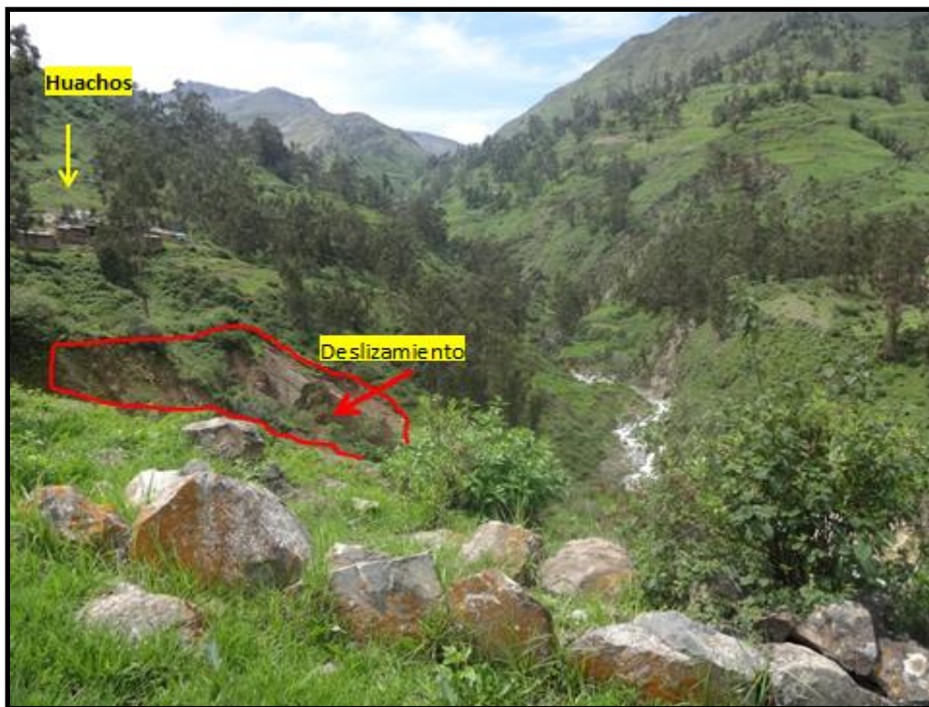
Foto 01: El distrito de Huachos se encuentra ubicado en las faldas del cerro Manzanapata (flecha de color amarillo), la flecha de color rojo indica la escarpa principal del evento.
