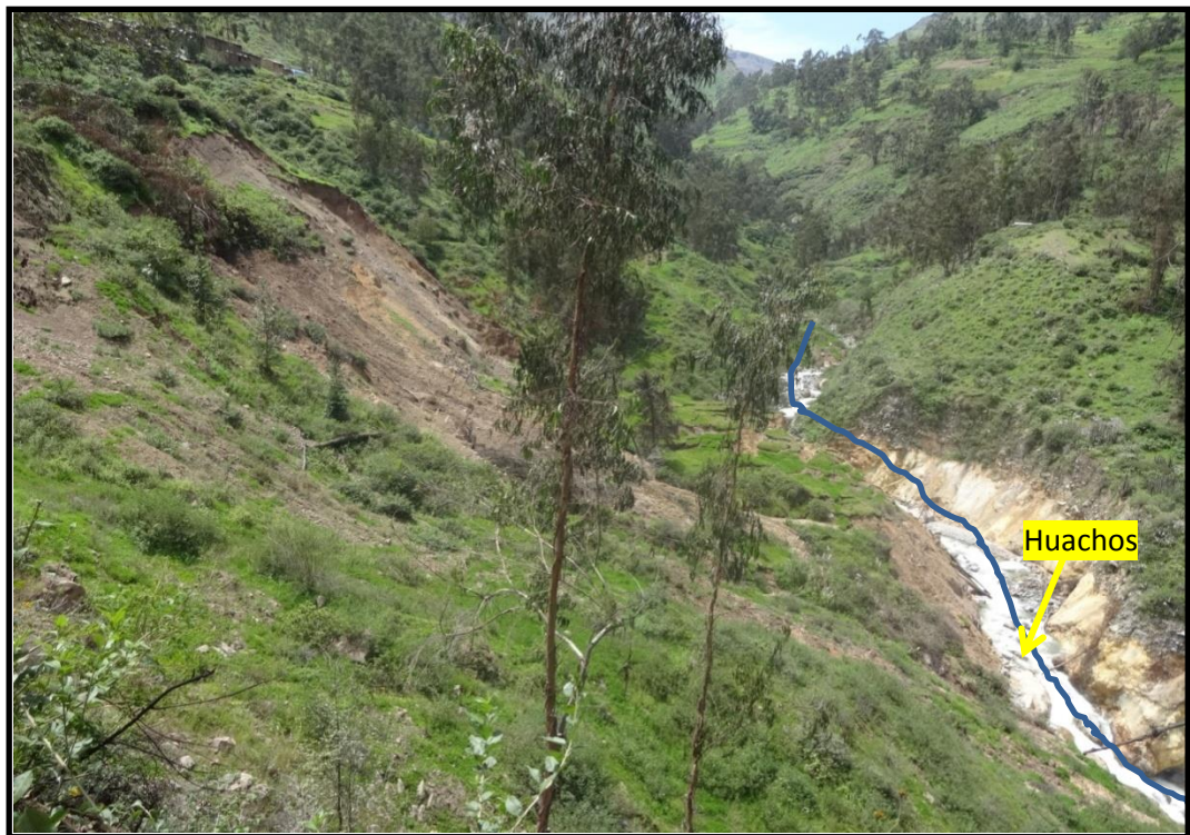
Foto 02: Vista aguas abajo del río Huachos, se observa que sobre la margen derecha se asienta el distrito de Huachos.
