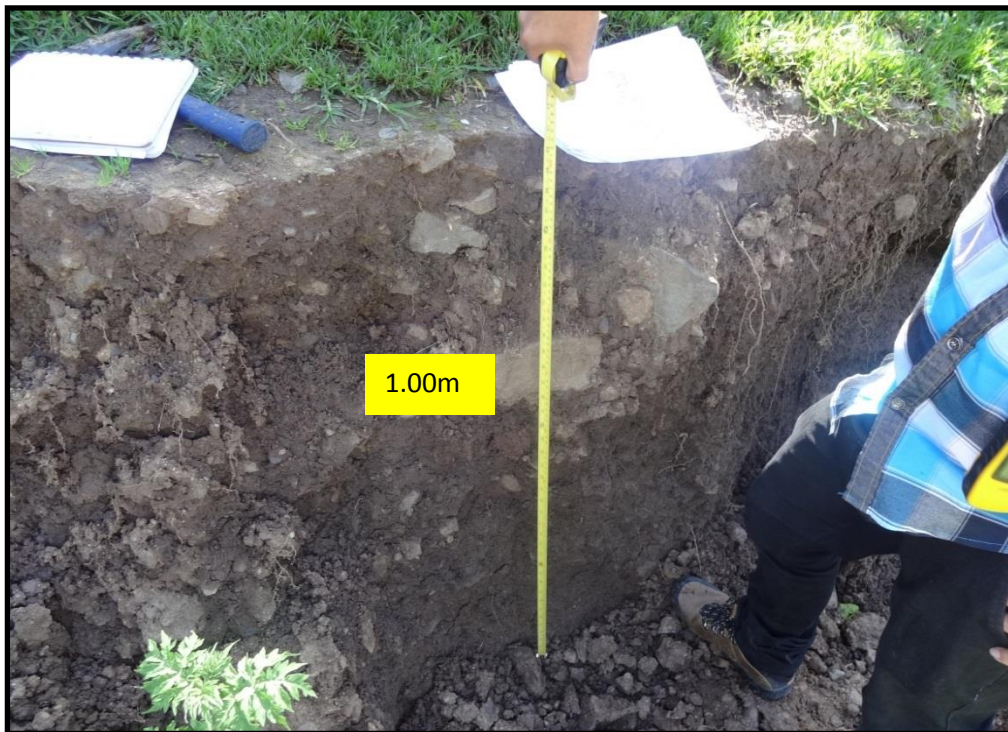
Foto 09: Superficie de ruptura del deslizamiento del 28-12-2013.
