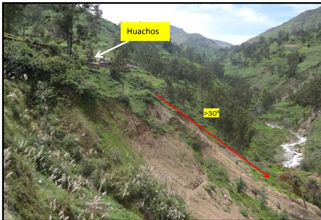
Foto 03: La ladera, presenta una pendiente mayor a 30°, factor que contribuye la ocurrencia de deslizamientos de tierra además de los materiales que lo constituyen, flecha de color blanco señala el distrito de Huachos.
