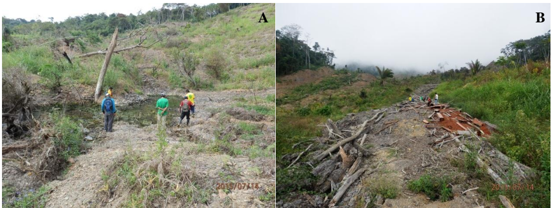
Foto 7. Vistas tomadas con dirección SE, donde la foto (A) se observa residuos de un puquial que se encuentra en la parte superior del cuerpo del deslizamiento. foto (B) se observa deposito lacustrino producto del desembalse del puquial generado por el movimiento del terreno.
