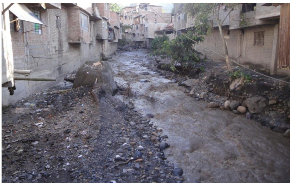
Foto 1.- Cauce del río Shankirwato. Las viviendas han “encajonado” el cauce, convirtiéndola en zona de alto riesgo.
