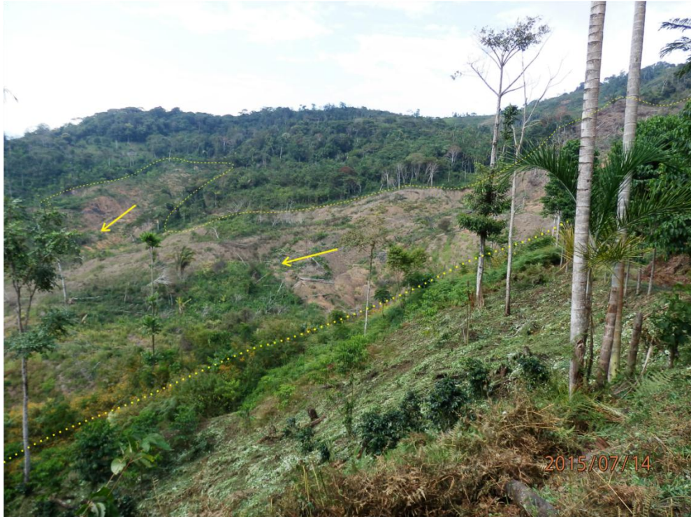
Foto 2 Vista tomada con dirección SE, donde se observa el flanco derecho y parte de la escarpa principal del deslizamiento en el sector de Ahuaruchayocc.
