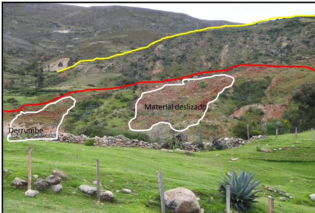
Foto 14: El material deslizado está conformado por clastos sueltos lo que favorece la retención del flujo, posterior al evento se han registrado derrumbes de tierra. La línea color amarillo marca una escarpa anterior suscitada en 2011, línea color rojo escarpa actual.
