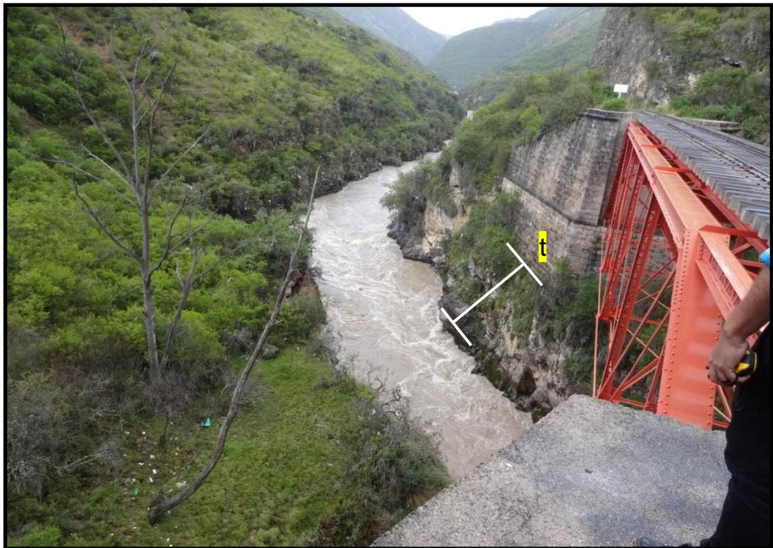
**Foto 03:** En la terraza “t” se observa socavación debido a la acción erosiva del río Mantaro.
