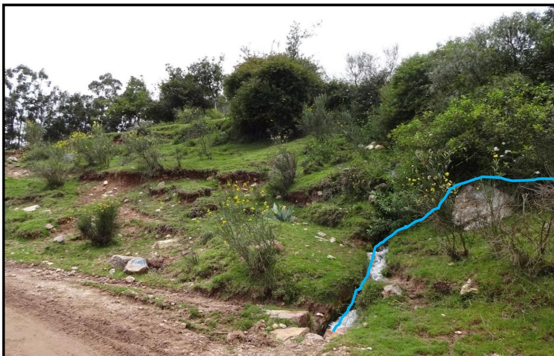
**Foto 12:** Superficie deslizada en corte de la carretera de acceso a la zona urbana de Pilchaca, progresiva 6+100, la línea de celeste indica escorrentía.
