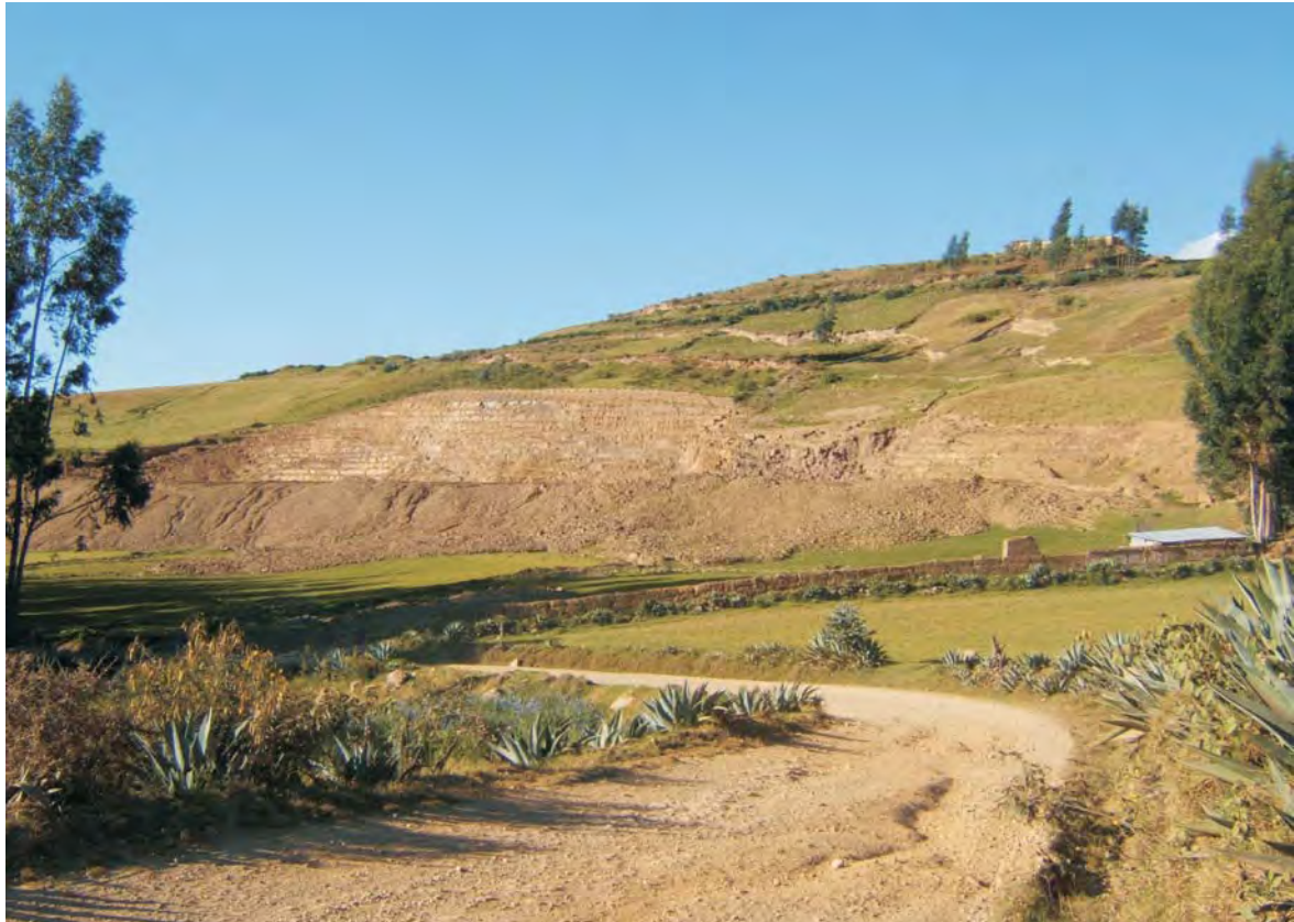
Terraceo o banqueteo de talud afectado por deslizamiento en el sector de Chacas (carretera Chacas-San Luis).
