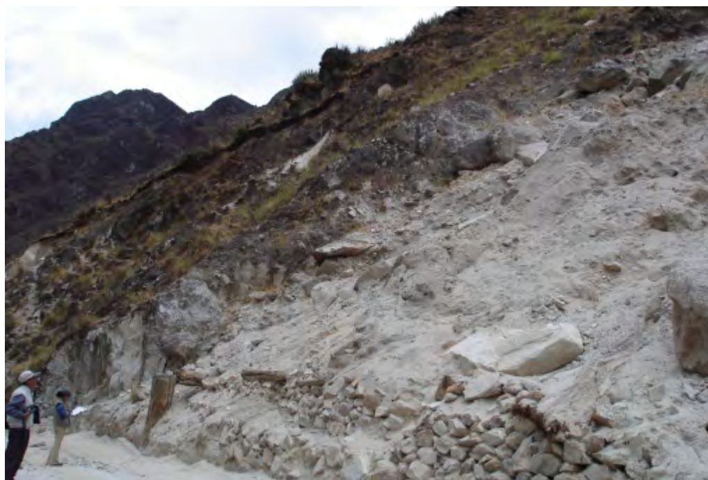
Foto 100 Carretera hacia la laguna Pelagatos, que se ve seriamente afectada por deslizamientos y derrumbes.
