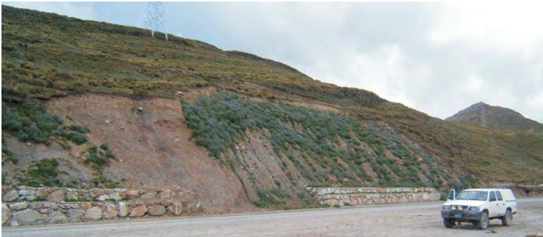
Muro de encoados contra derrumbes de talud en la carretera Conococha-Antamina.
