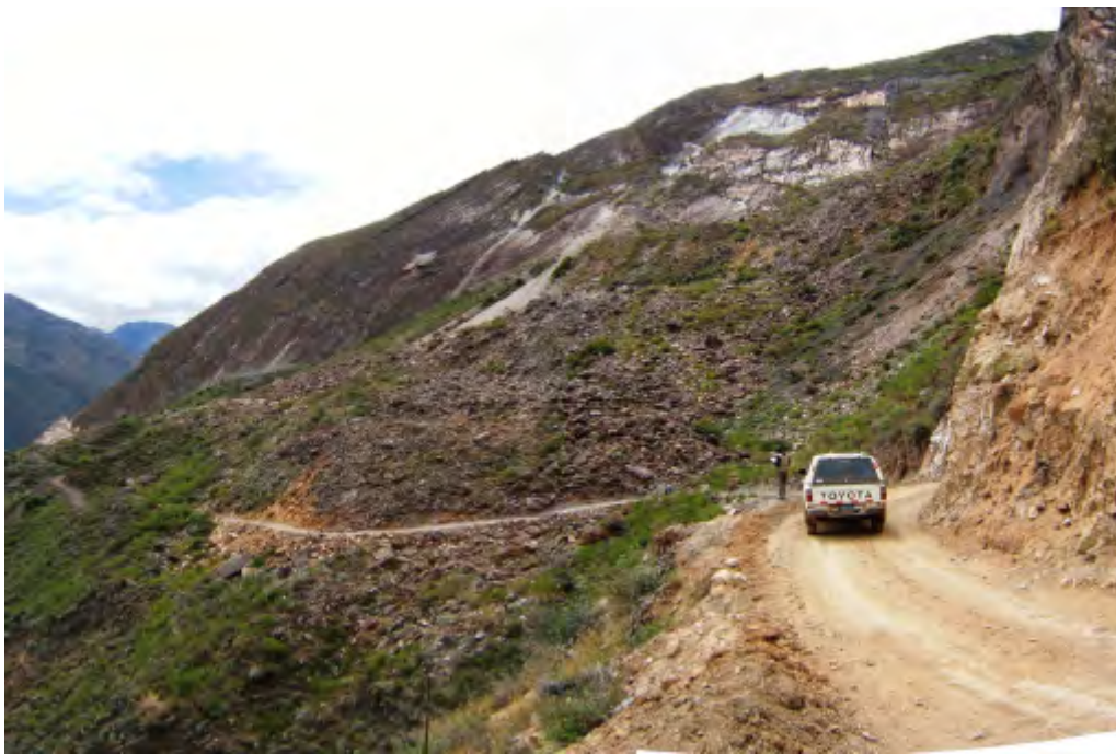
Foto 78 Avalancha de rocas en el sector entre Yauya y San Nicolás. Su reactivación con sismo compromete un tramo de carretera.
