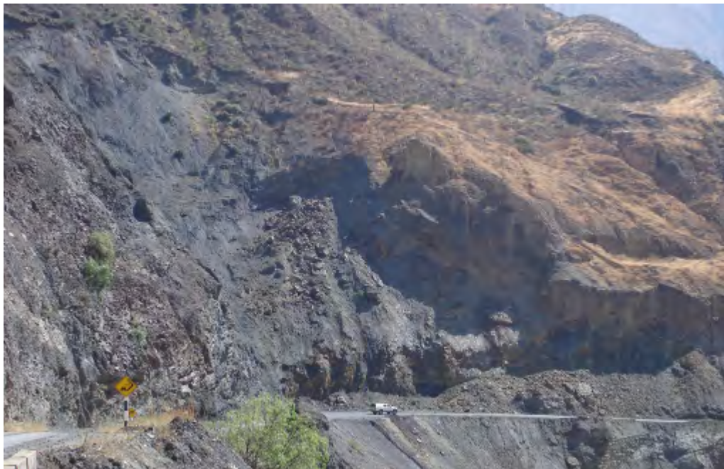
Foto87 Tramo de la carretera Caraz-Huallanca en elCañón Pato, afectado por caídas de rocas y deslizamientos.
