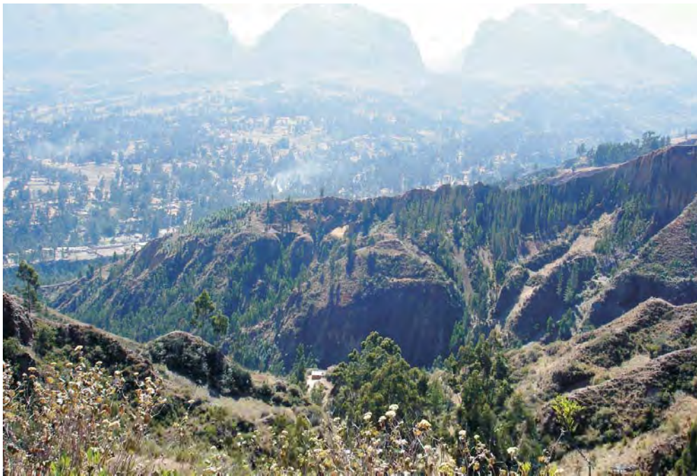
Control de erosión en cárcavas en las cabeceras del río Quilcay y río Seco (Huaraz).
