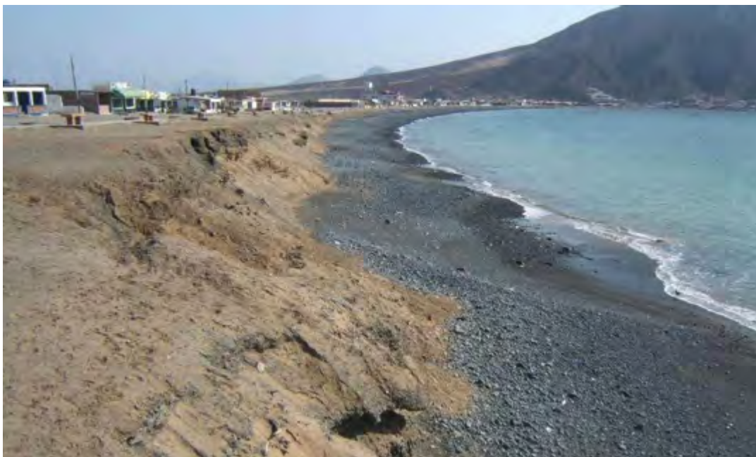
Foto 61 Erosión marina en el sector de playa La Tortuga, Casma. Nótese la socavación del talud de la terraza o planicie litoral.
