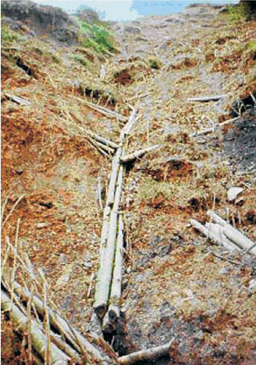
Construcción de filtro vivo en forma de espina de pez.
