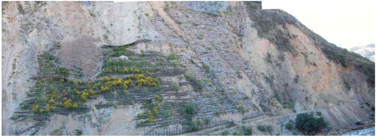
Construcción de trinchos para estabilización de laderas susceptibles a derrumbes (margen izquierda del río Santa, Huaraz).
