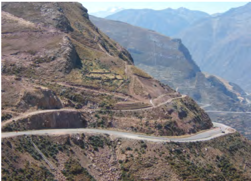
Foto 75B Km 15a18(Conococha-Antamina), cerca de Aquia, zona crítica por derrumbes y caída de rocas.
