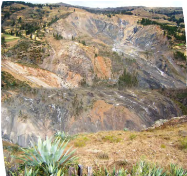
Foto 79 Deslizamiento de Yauya, activo con avance retrogresivo afectando terrenos de cultivo y con aporte de material de remoción a la quebrada para generar flujos o huaycos.
