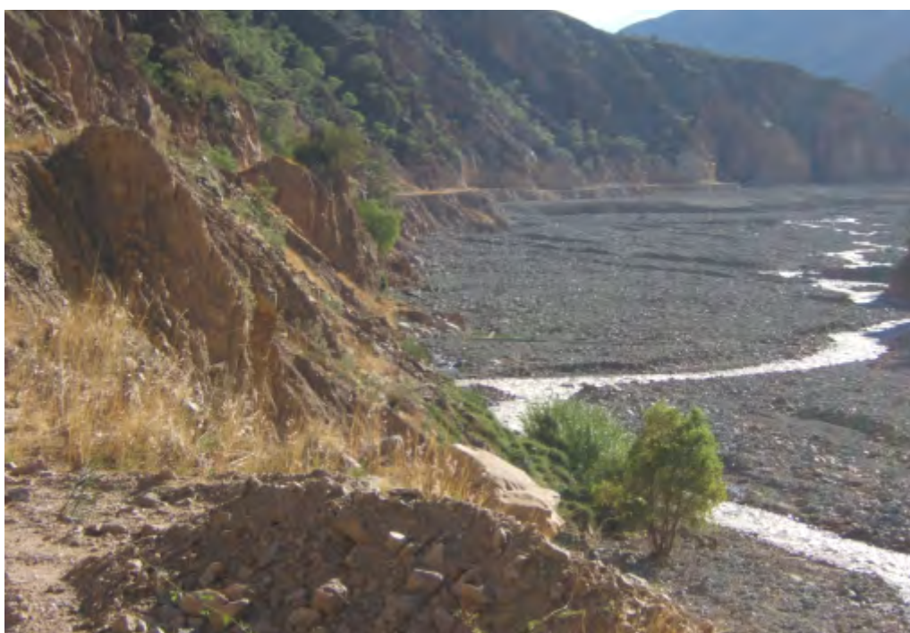
Foto 105 Erosión fluvial en la margen derecha del río Rupac, aguas debajo de la quebrada Sacabamba. En el mismo tramo hacia la desembocadura en el río Marañón, derrumbes y avalanchas de detritos. Con el sismo de Lamas del 2005 el derrumbe interrumpió un tramo de la carretera.
