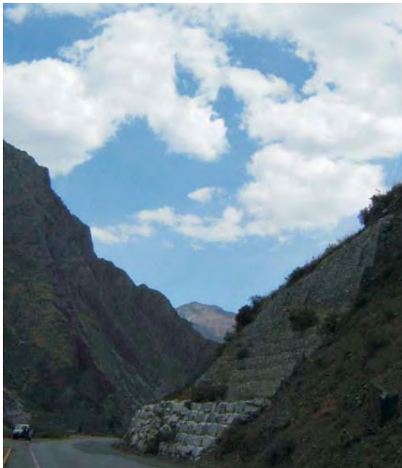
- Construcción de muros secos al pie del talud.
