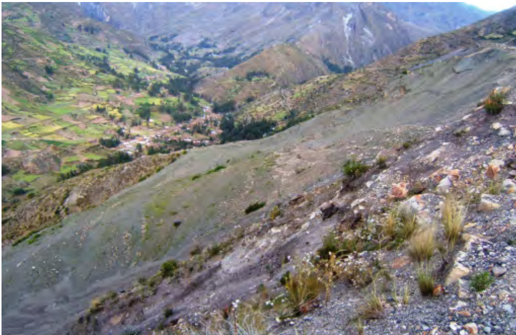
Foto 92 B Vista de la zona del Mirador Bandera en el tramo de carretera en construcción entre túnel Cahuish-Chavín (talud inferior), afectado por un proceso de deslizamiento activo y caídas de rocas.
