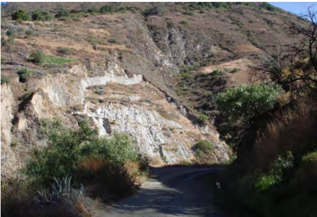
Foto 31 Deslizamiento en el cerro Quellocoto-Corongo con ladera de fuerte pendiente, en la margen derecha aguas abajo de la quebrada Aticara. Se observan escarpas sucesivas y progresivas con reactivaciones en la parte inferior y que afectan un tramo de la carretera Aticara-Yupán.
