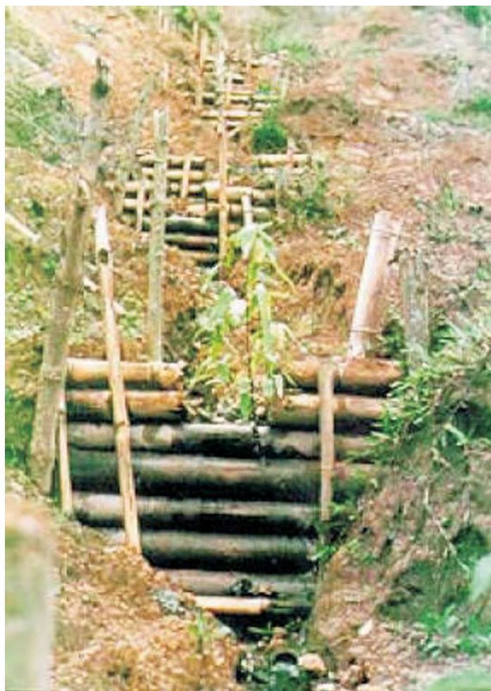
Evacuación de aguas superficiales y control de erosión en cárcavas, mediante trinchos escalonados.
