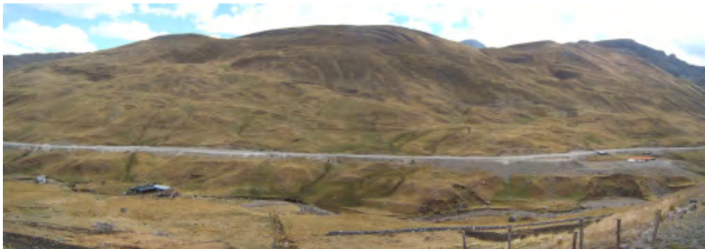
Foto 46 Reptación de suelos en ladera de moderada pendiente, sector del desvío de la carretera que va a Huanzalá.
