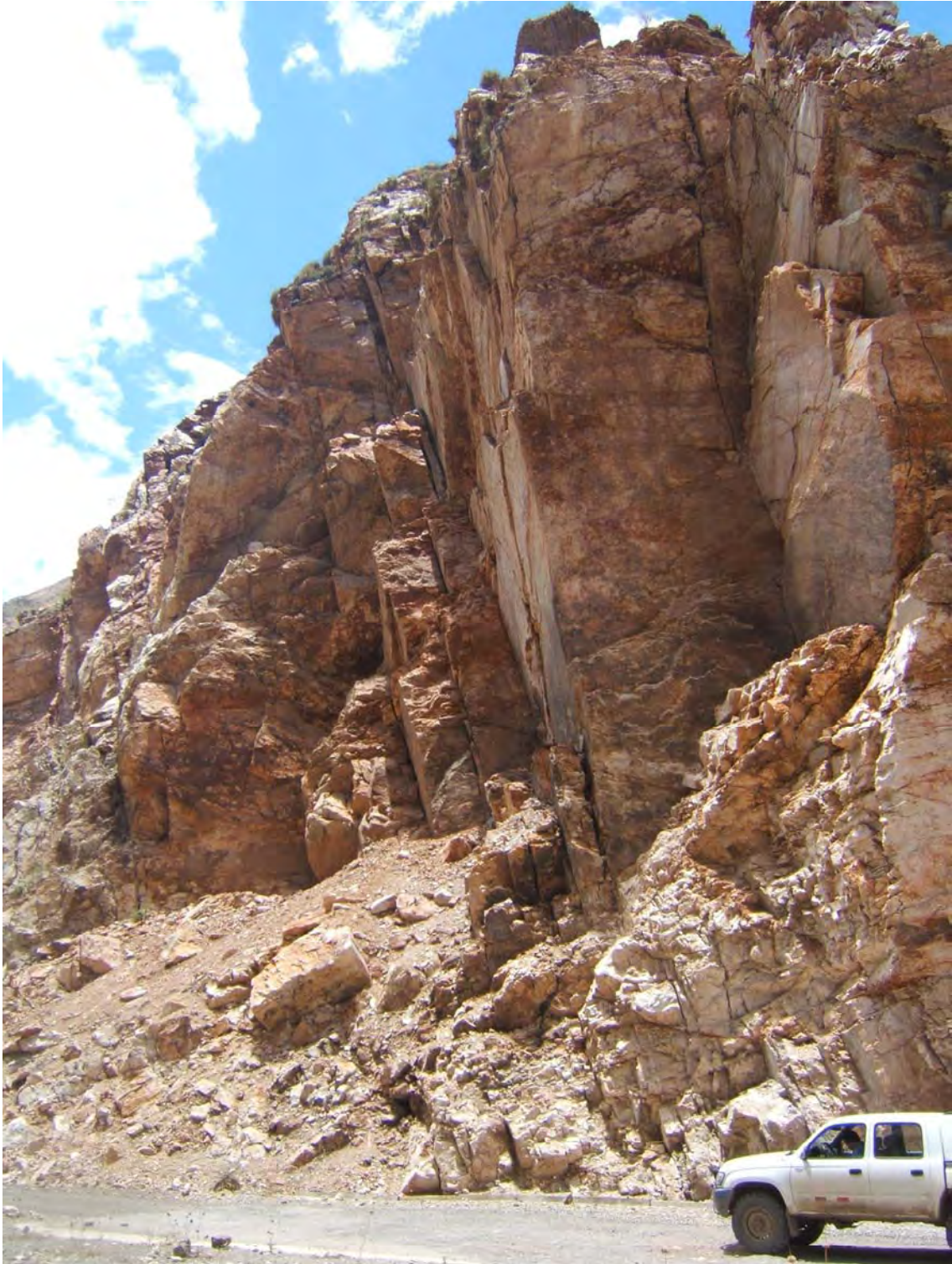
Foto 28 Vuelco de estratos en el sector de puente El Águila, carretera de Sihuas hacia el río Marañón, donde se accede a Huacrachuco y Tayabamba. Muestra una zona de arranque de 300 m de ancho y 90 m de altura.
