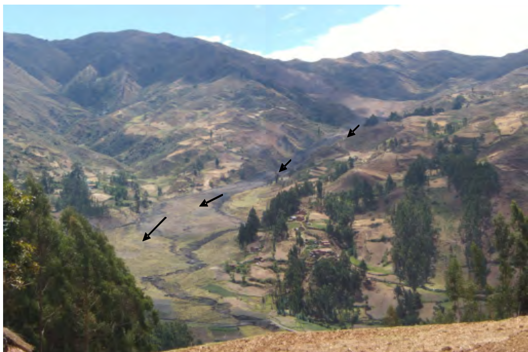
Foto 42 Vista de un flujo reciente originado por un deslizamiento en el sector de Yanaulpa, frente a la localidad de Parobamba.
