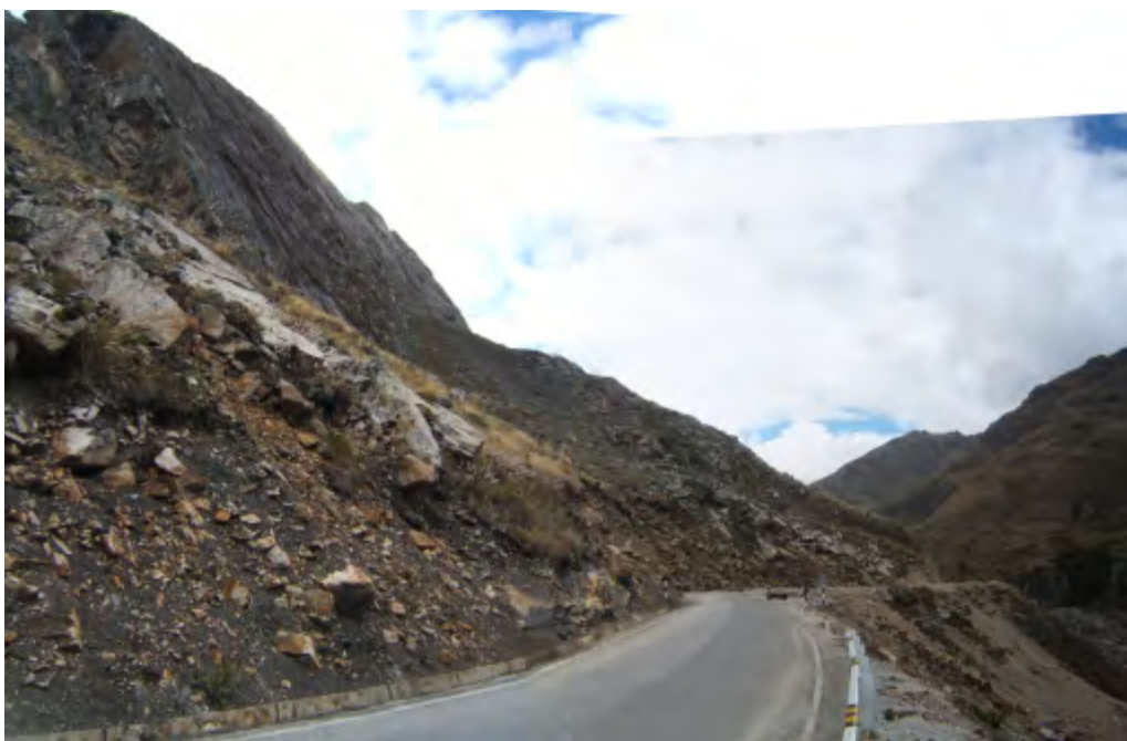
Foto 72A Tramo de la carretera mina Huanzalá - Huallanca. Deslizamiento traslacional y derrumbes en la zona.
