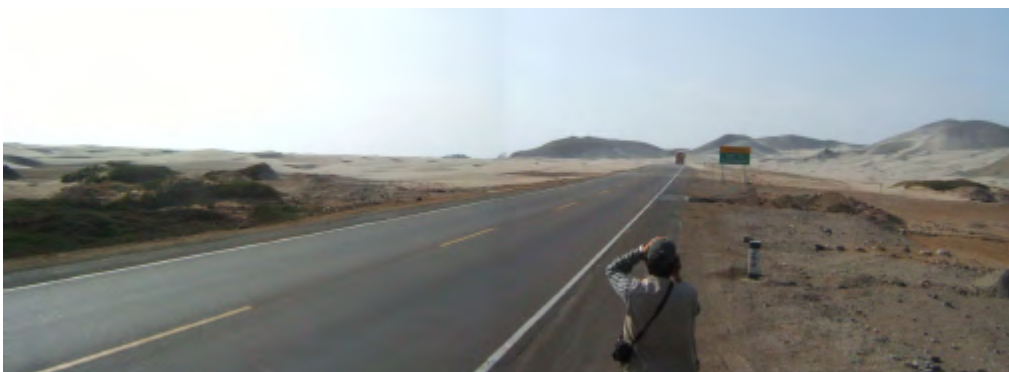
Foto 8 Carretera Panamericana Norte en el sector de pampa; unidades de lomadas y planicie costanera con acumulaciones eólicas.
