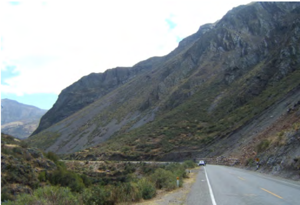
Foto 44 Tramo de la carretera Conococha-Antamina susceptible a caída de rocas y avalancha de detritos. Se distingue los grandes talus de detritos.
