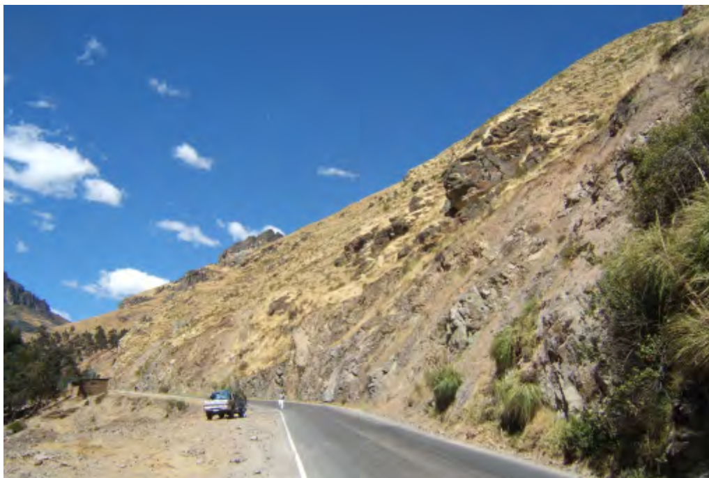
Foto 76 B Sector de Mayorarca cerca de puente Mellizos (carretera Pativilca-Conococha), zona crítica por derrumbes.
