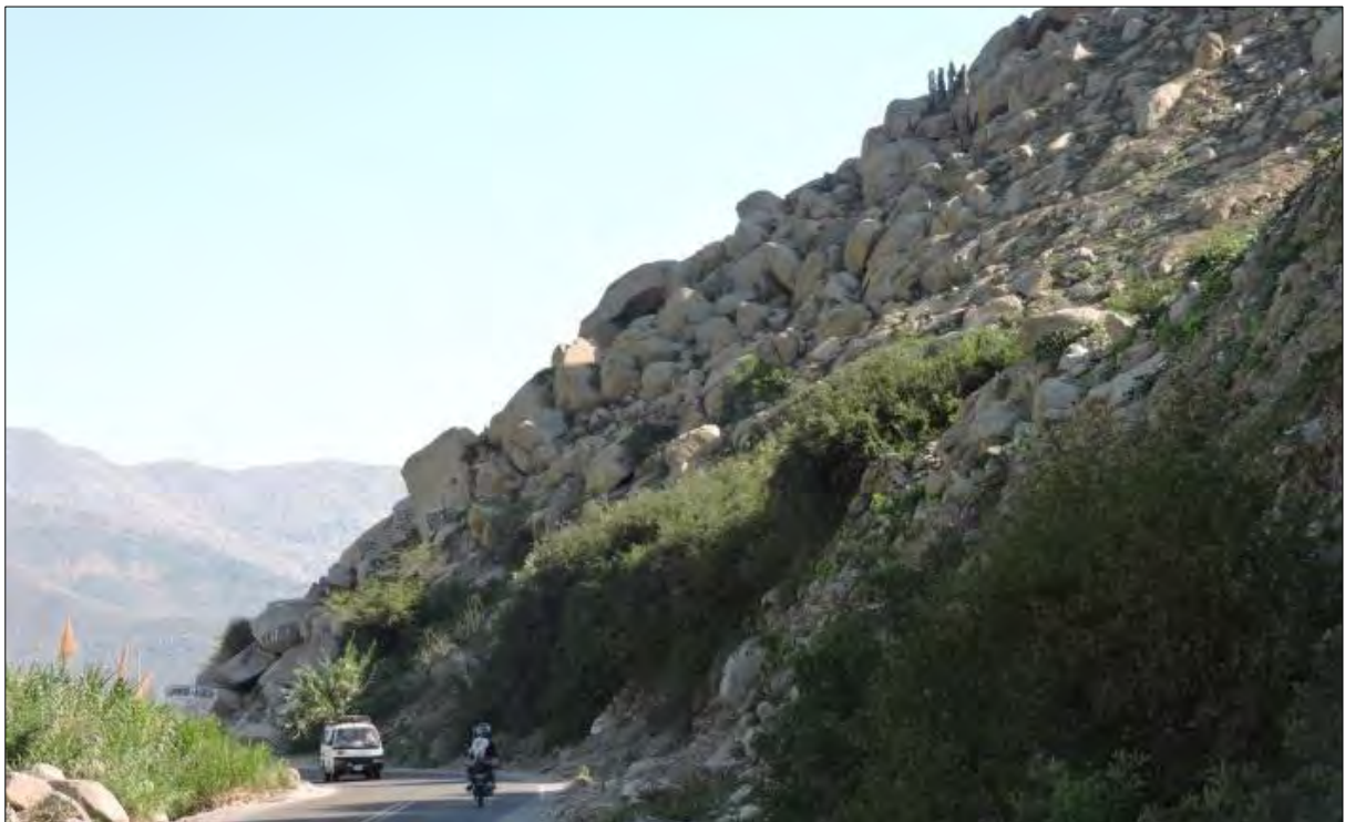
Foto 22: Caída de rocas sobre la margen derecha del río Santa. Se observan los bloques sub redondeados de rocas ígneas con tamaños mayores a 1 m. Vista tomada hacia el oeste.
