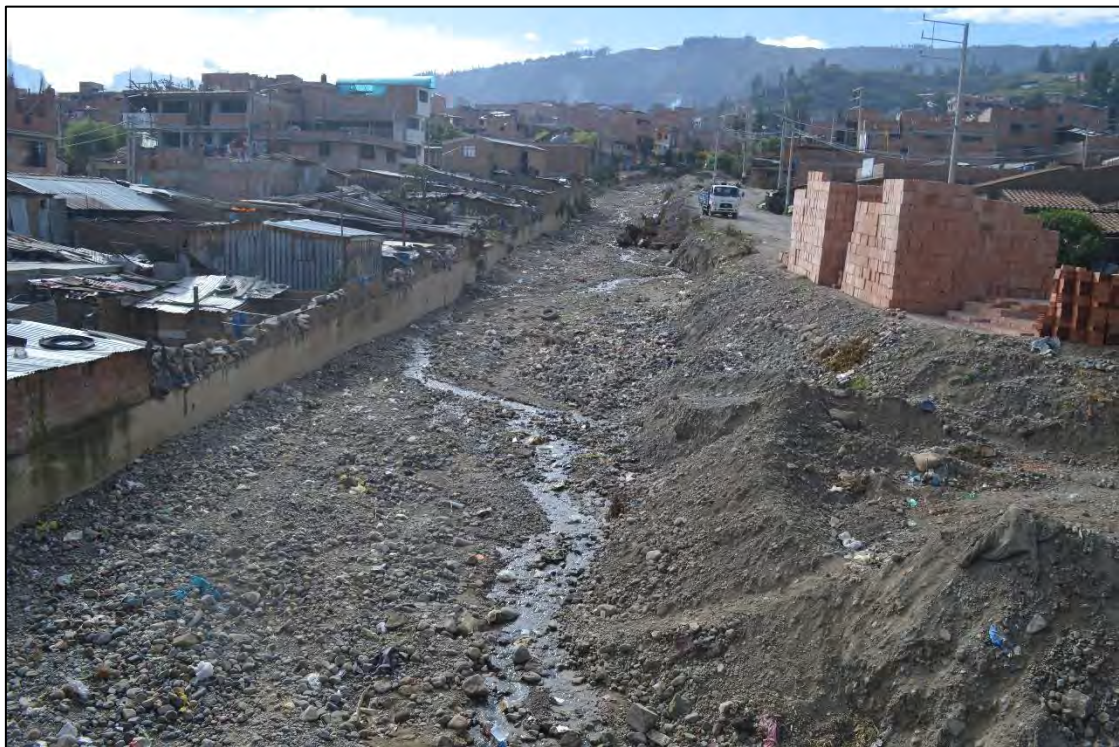
Foto 8: Viviendas en la ciudad de Huaraz en zonas de alto riesgo por huaicos, erosión fluvial e inundaciones.
