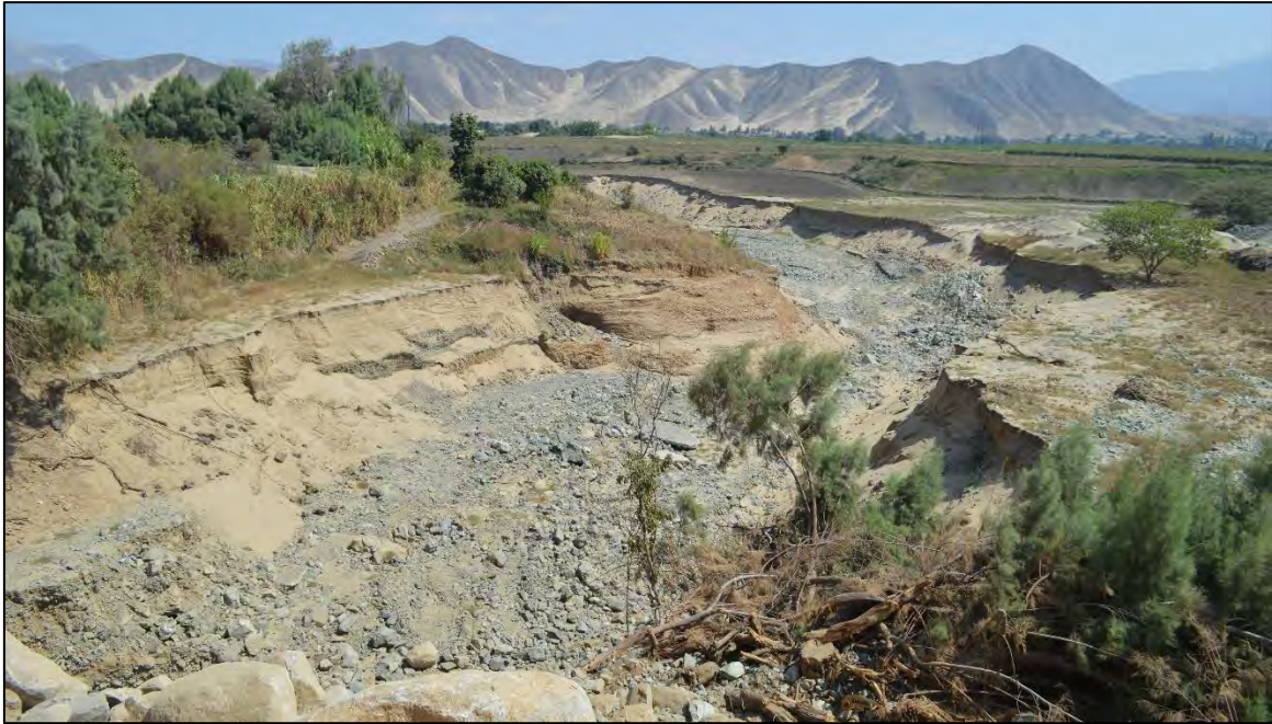
Foto 7: Socavamiento e incisión de un afluente del río Lacramarca, ocasionado por la ruptura del canal Chinecas.
