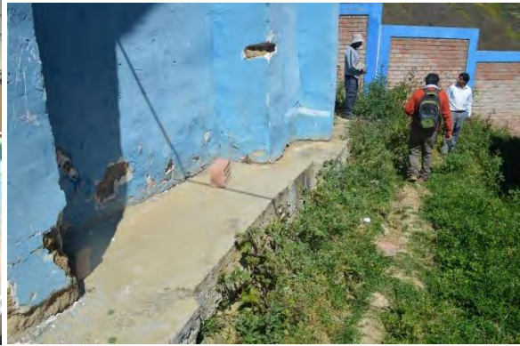
Fotos 17 y 18: Centro educativo, en el distrito de Phira con daños estructurales ocasionados por un deslizamiento activo profundo.
