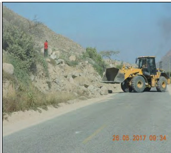
Fotos 31 y 32: Daños ocasionados por caída de rocas. A. Vista de la caída de rocas (sedimentarias) sobre un tramo de la carretera Chimbote-Sihuas. Vista tomada hacia el Norte. B. Vista de la caída de rocas (intrusivas) sobre un tramo de la carretera Chimbote-Huallanca. Nótese el leve daño ocasionada sobre la vía que está siendo limpiada.
