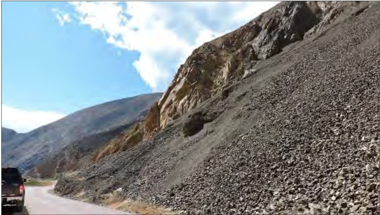
Foto 21: Caída de rocas sobre la margen derecha del río Santa. Se observan fragmentos angulosos de rocas sedimentarias (limolitas y areniscas) con tamaños menores a 0.20 m. Vista tomada hacia el noroeste.
