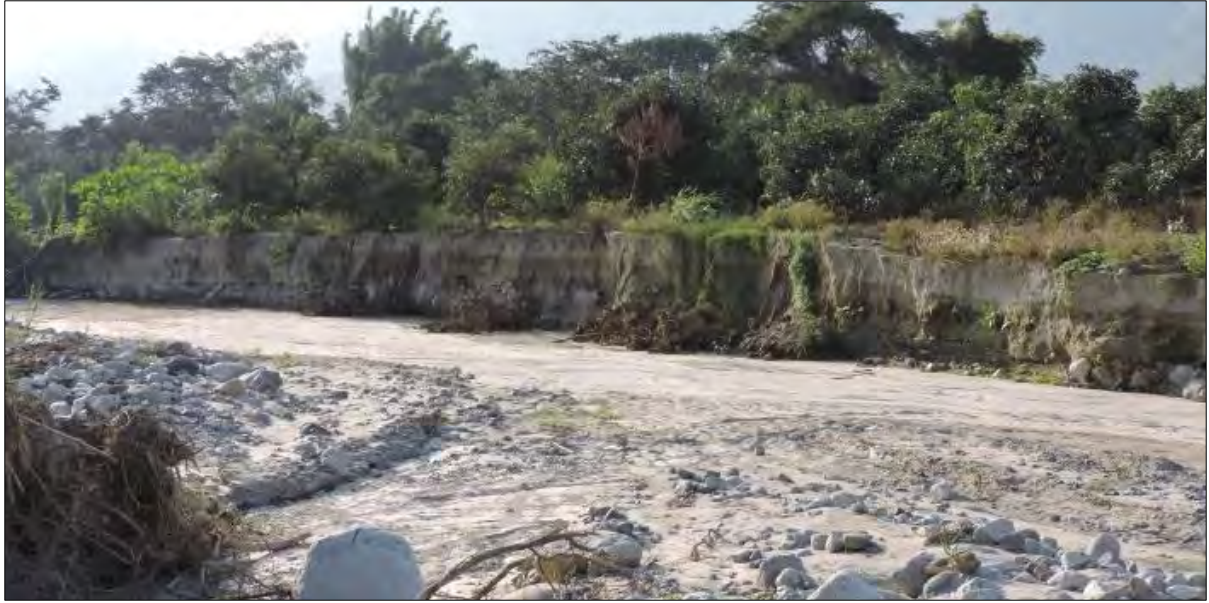
Foto 27: Erosión de ribera en la terraza baja ubicada sobre la margen izquierda del río Nepeña. Vista tomada hacia sureste.
