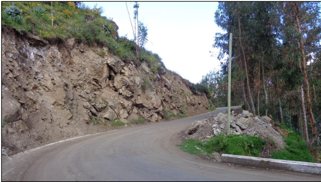
Foto 26. Vía hacia Santiago de Chuco, se puede observar restos de material colapsado, que provocaron el bloqueo de la vía Quebrada Chulite, distrito de Santiago de Chuco. Vista al Este.
