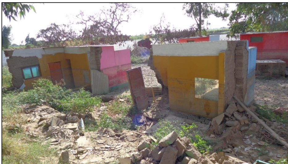
Foto 9. Hotel destruido con la inundación provocada por el desborde del río Virú, esta a su vez arrastró arenas pertenecientes a depósitos eólicos encontrados en la zona. Localidad Calunga, distrito Virú. Vista al Oeste.
