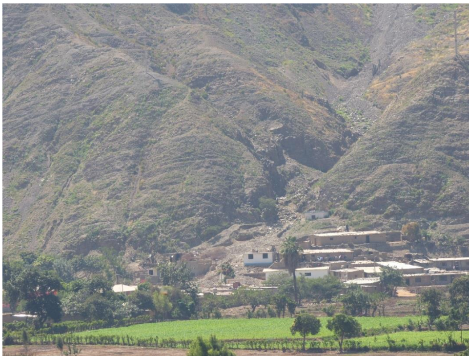
Foto 1. Viviendas sepultadas en el CP. La Portada por depósitos de flujo detrítico. Distrito San Benito, provincia Contumazá, Cajamarca.
