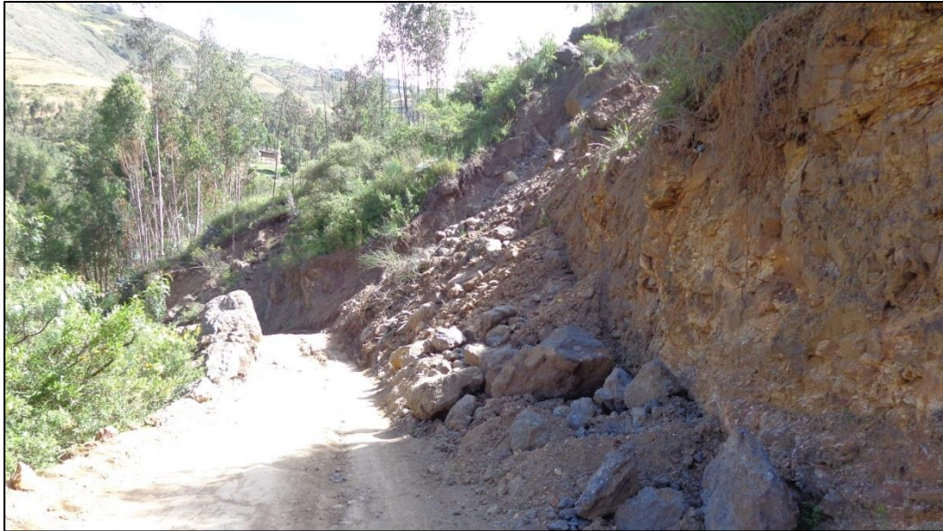
Foto 27. Derrumbes que provocaron el bloqueo de la vía, originadas por el fracturamiento, meteorización y las precipitaciones pluviales. Localidad Carnachique, distrito Otuzco. Vista al Norte.
