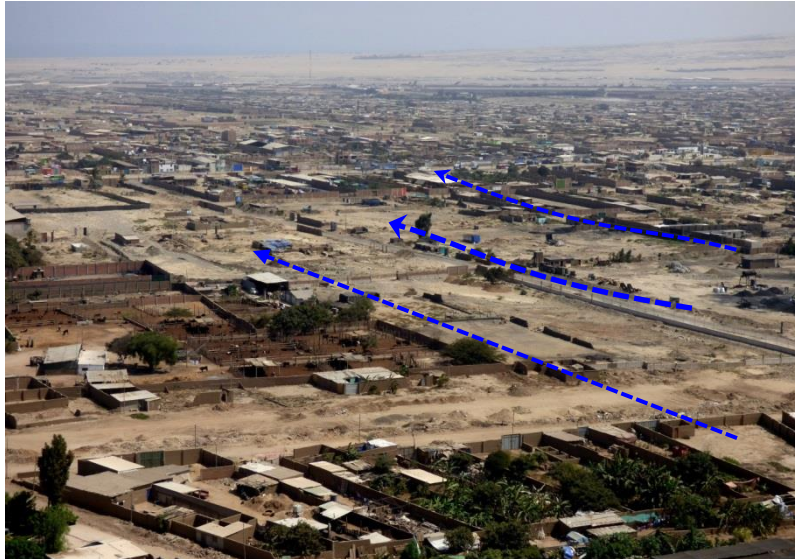
Foto 7. Activación de la quebrada Del León afectó carretera, calles y viviendas en la ciudad de Trujillo; jurisdicción de los distritos Huanchaco y La Esperanza.
