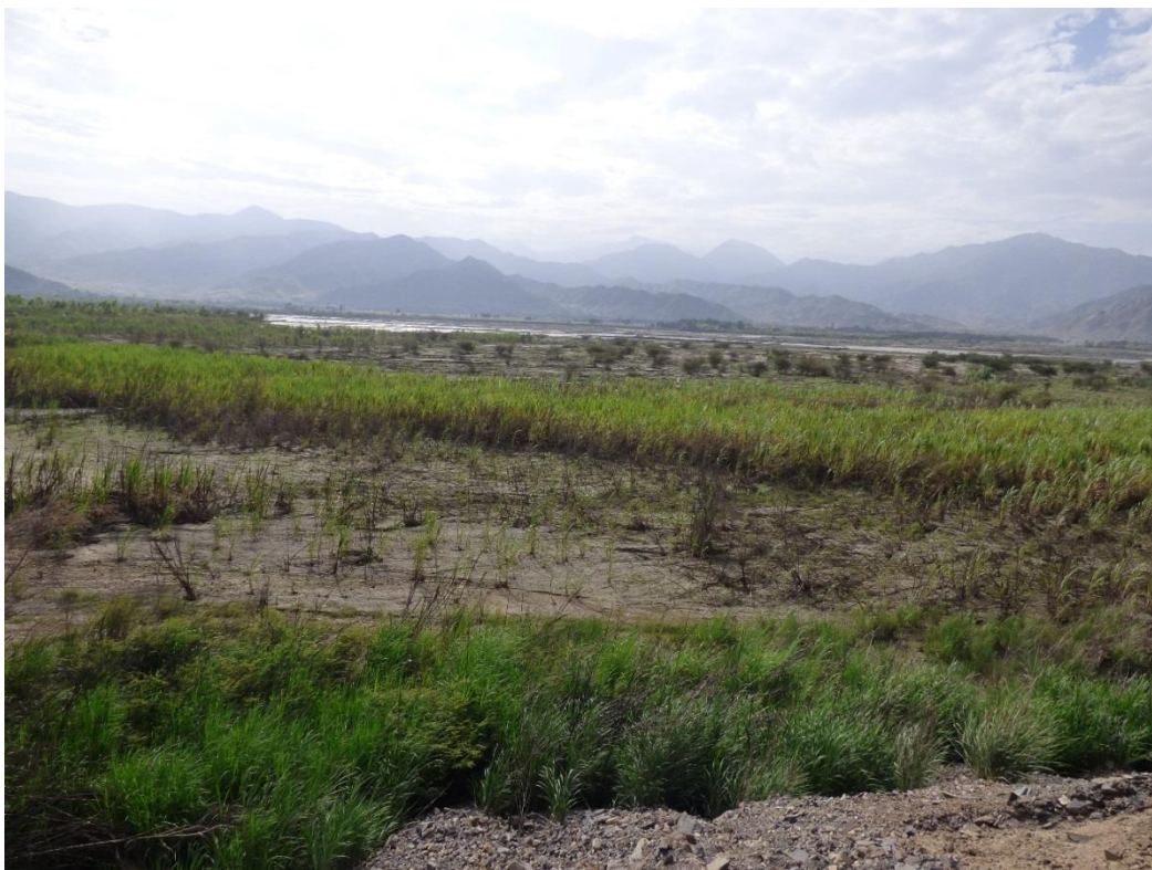
Foto 28. Rastros de inundación fluvial en la margen izquierda del río Chicama; distrito Chicama, provincia Ascope, La Libertad.
