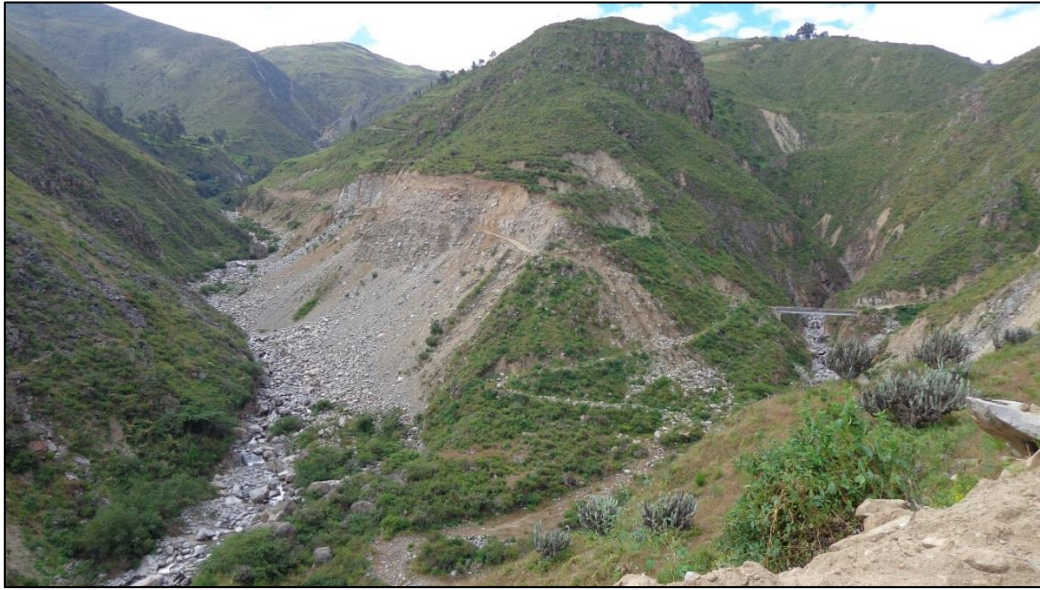
Foto 25. Deslizamiento rotacional, originado por el intenso fracturamiento, meteorización y saturación, ocasionando la destrucción de la carretera y un posible represamiento del río Huaraday. Localidad Guacapungo, distrito Santiago de Chuco. Vista al NE.
