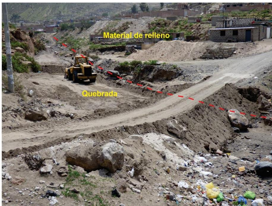
*Figura 7. Margen derecha del Asentamiento Humano “Las Canteras”. Quebrada si nombre, el cauce ha sido relleno por material de desmonte y basura.*
