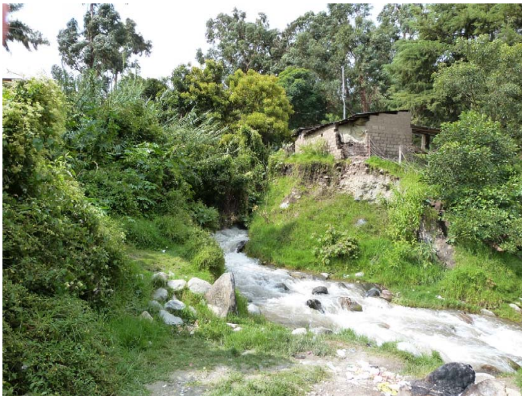
Foto N° 5: Invasión de los espacios públicos hidráulicos por construcción de viviendas Qda. Colcaqui.
