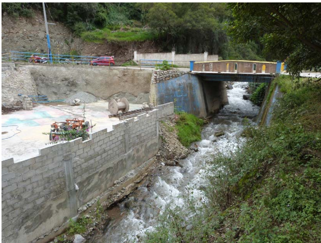
Foto N° 8: Invasión de los espacios públicos hidráulicos por construcción de viviendas Qda. Colcaqui.
