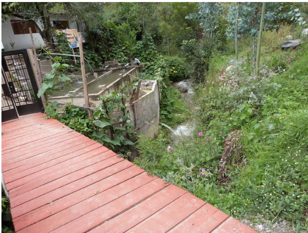
Foto N° 1: Invasión de los espacios públicos hidráulicos por construcción de criaderos de trucha
