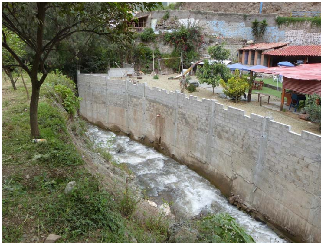
Foto N° 7: Invasión de los espacios públicos hidráulicos por construcción de viviendas Qda. Colcaqui.
