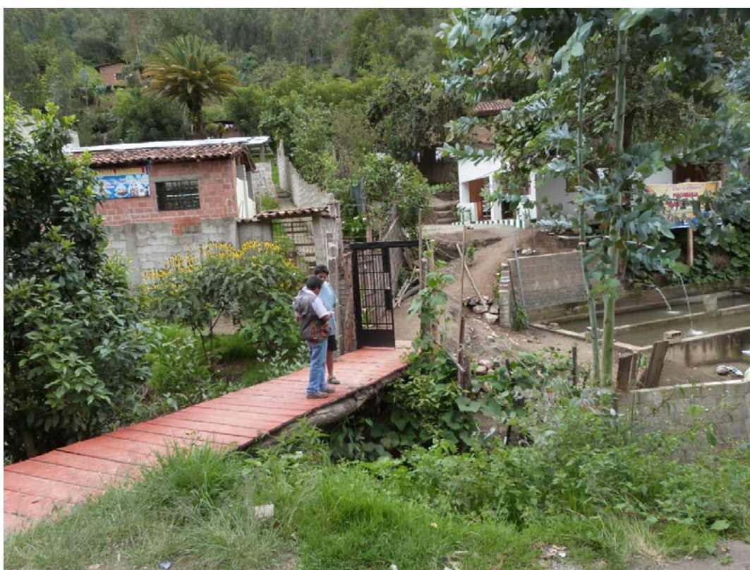
Foto N° 2: Invasión de los espacios públicos hidráulicos por construcción de viviendas y criaderos de trucha
