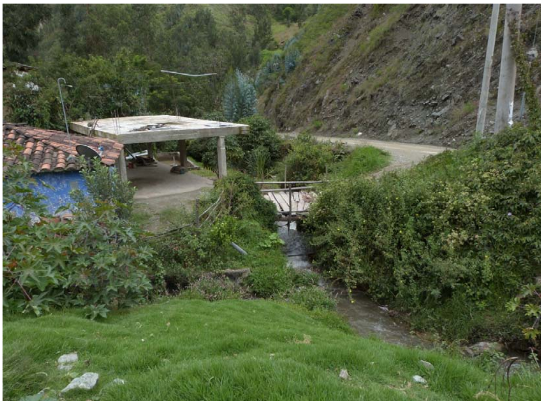
Foto N° 3: Invasión de los espacios públicos hidráulicos por construcción de viviendas Qda. Marcahuasi
