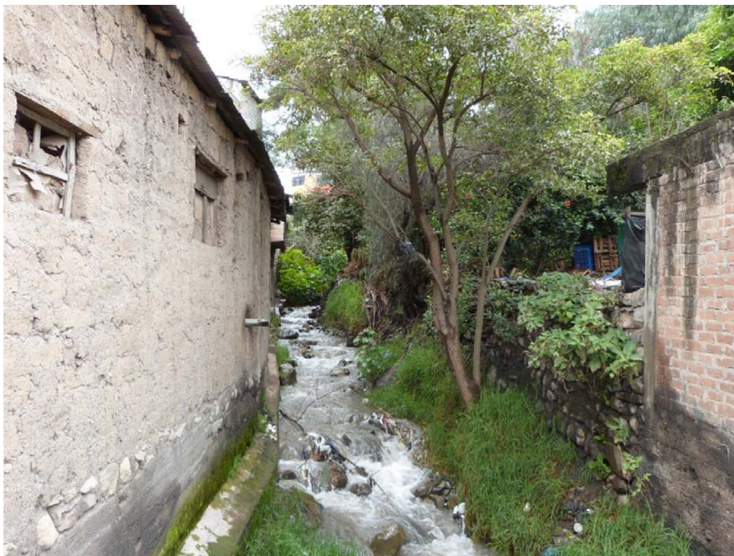
Foto N° 13: Construcción de viviendas en ambas márgenes Qda. Sahuanay
