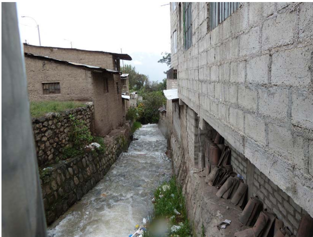
Foto N° 15: Viviendas construidas en ambas márgenes de la quebrada Sahuanay.
