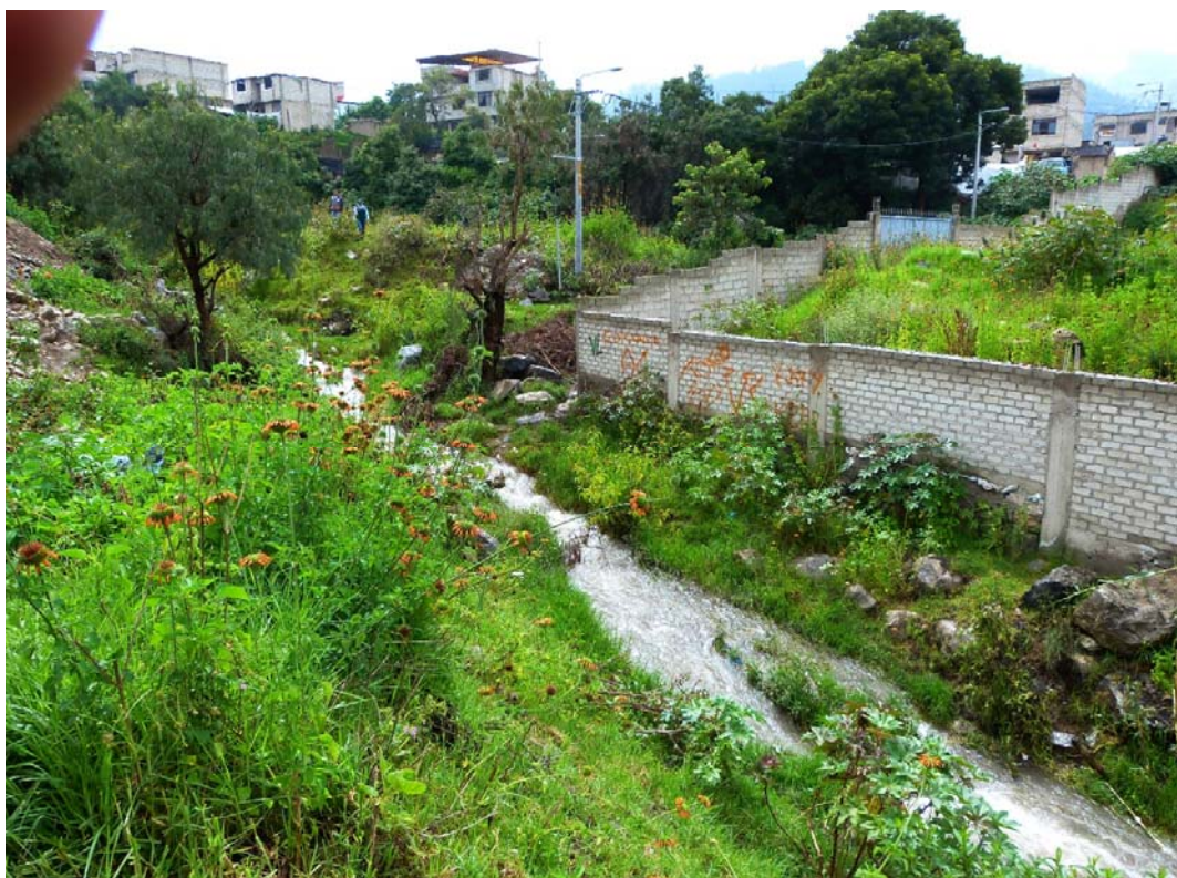
Foto N° 11: Construcción de cercos perimétricos dentro de los espacios públicos hidráulicos, quebrada Sahuanay
