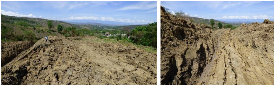
Fotos 14 y 15. Se muestra el canal de drenaje y material del cuerpo del deslizamiento removido.
