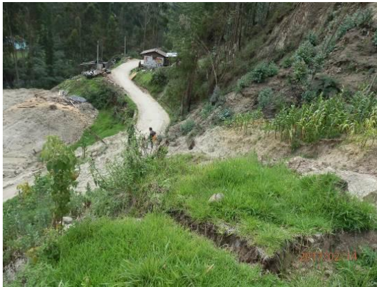
Foto 3. Vista de la parte superior del deslizamiento, se observa la escarpa principal con de 170 m. de longitud, salto vertical de 10 m.
