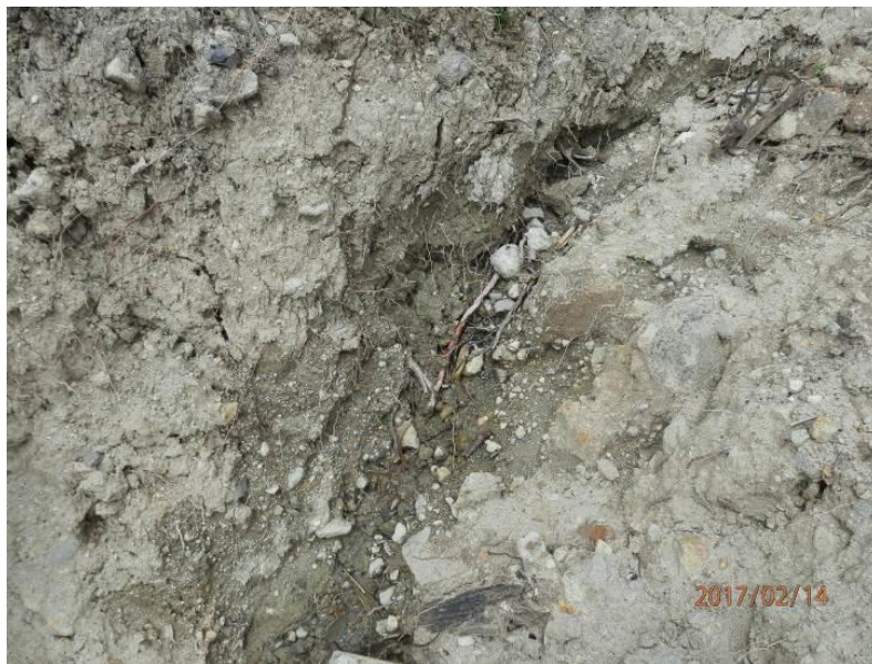
Foto 7. Margen derecha del deslizamiento se observa surgencia de agua.
