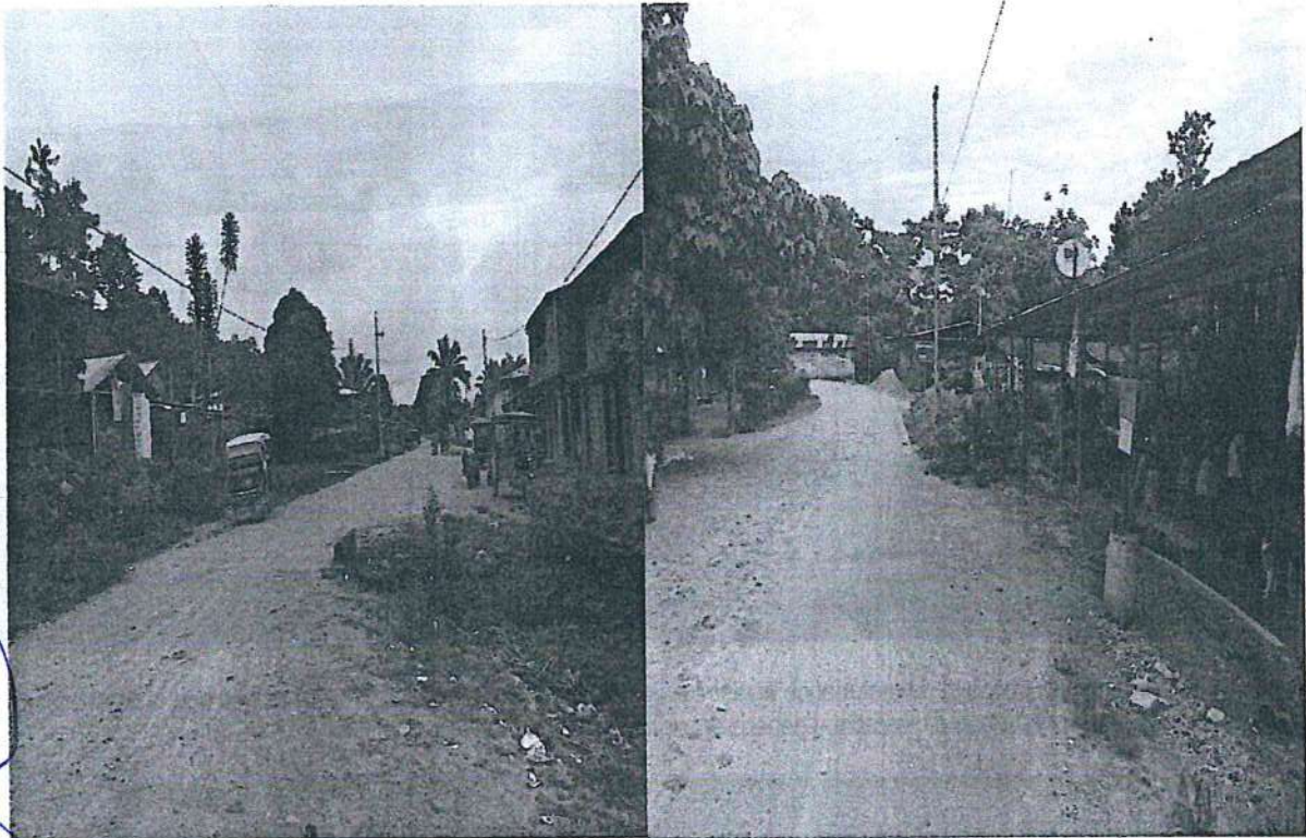
Imagen 6. Viviendas principalmente construidas de material noble y de madera sin una adecuada técnica constructiva
