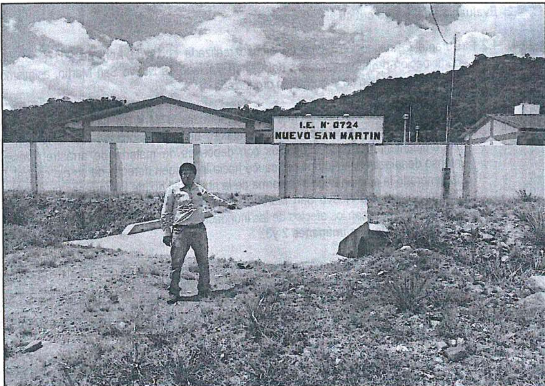
Imagen 3. Imagen de la infraestructura de servicio: Institución Educativa
