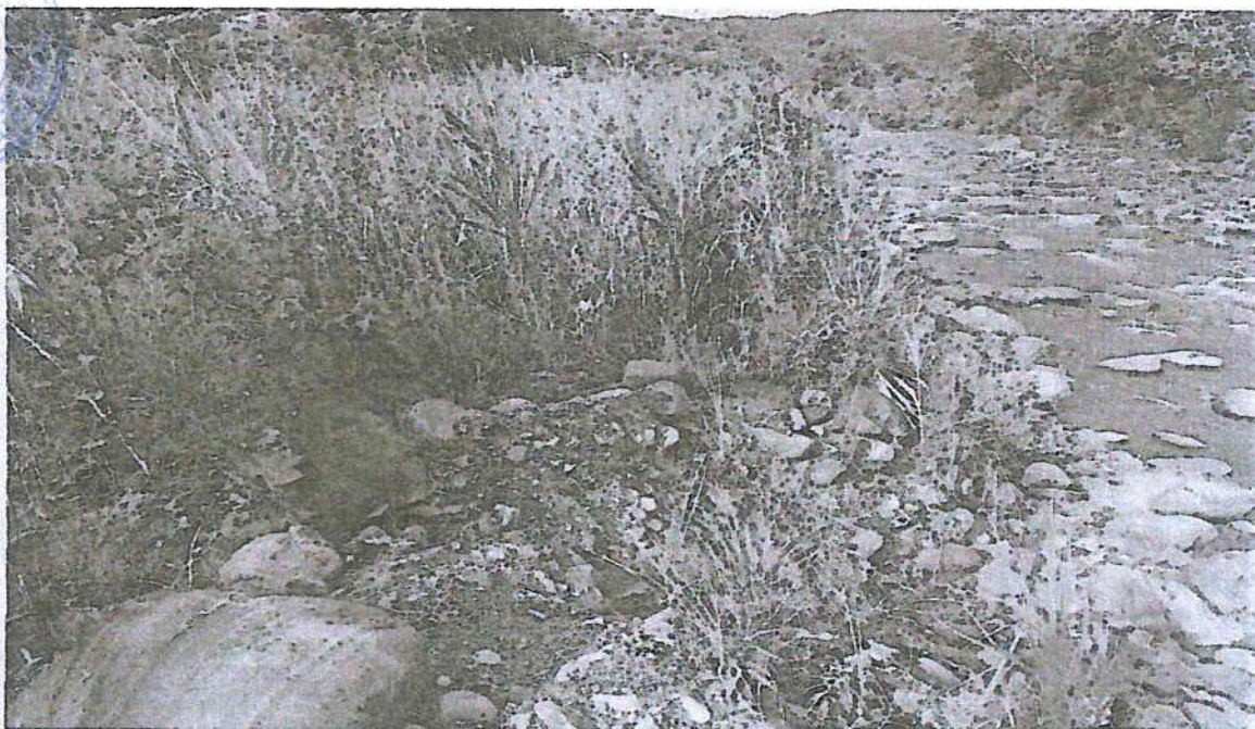
Imagen 3. Se observa la acumulación de material hacia la margen derecha del cauce del río Pacota, en donde se ubica el CP de Las Palmeras
