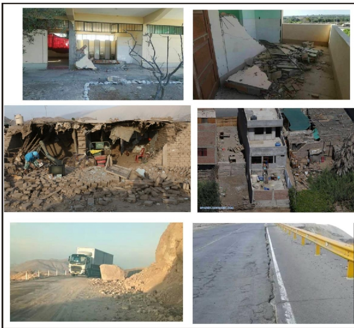
Figura 4.- Imágenes de daños y efectos observados en el área de máxima intensidad de sacudimiento del suelo debido al sismo de Lomas – Yauca del 14 de enero de 2018.
